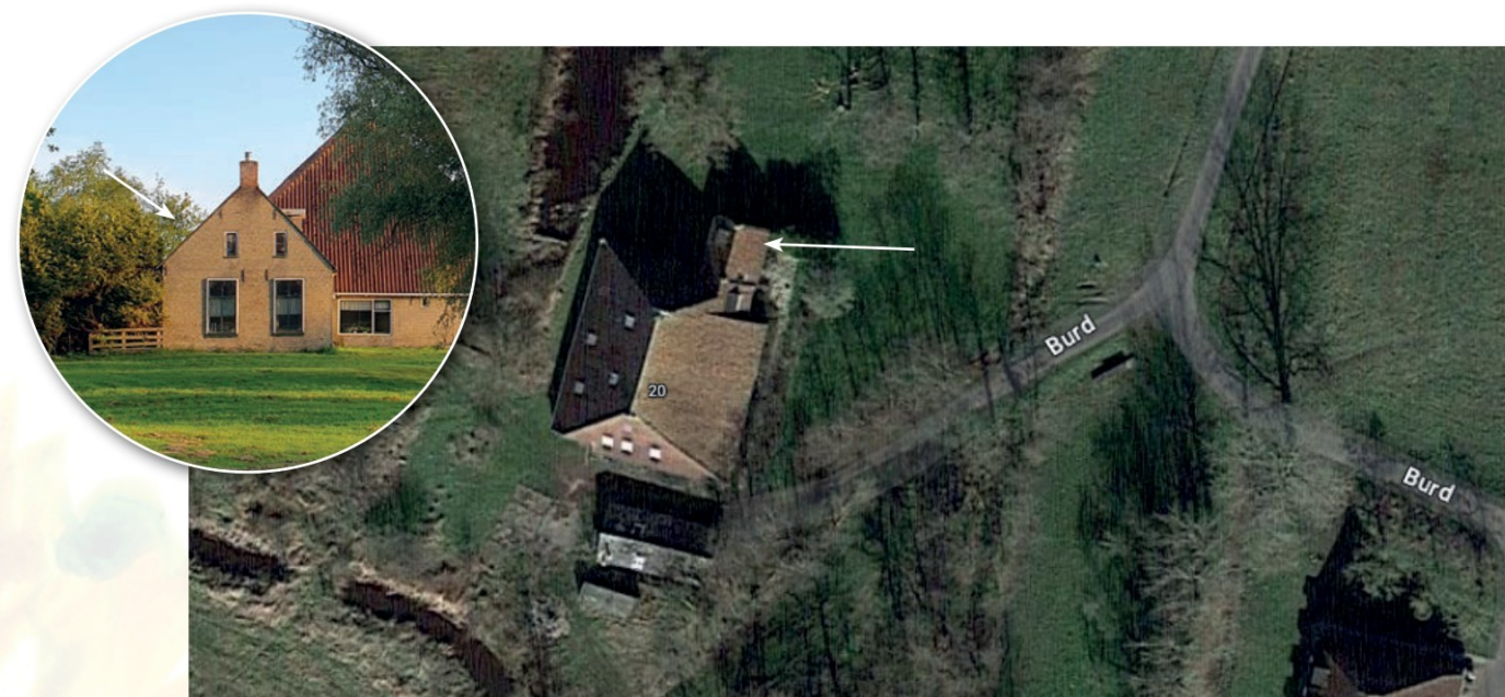
Figuur 5. Locatie van aangetroffen paarverblijfplaats gewone dwergvleermuis (witte pijl). Inzet: noordzijde woongedeelte boerderij.
