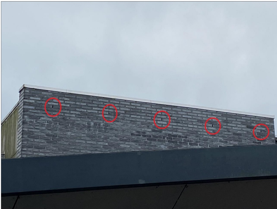
Foto 9. Open stootvoegen boven hoofdingang.
