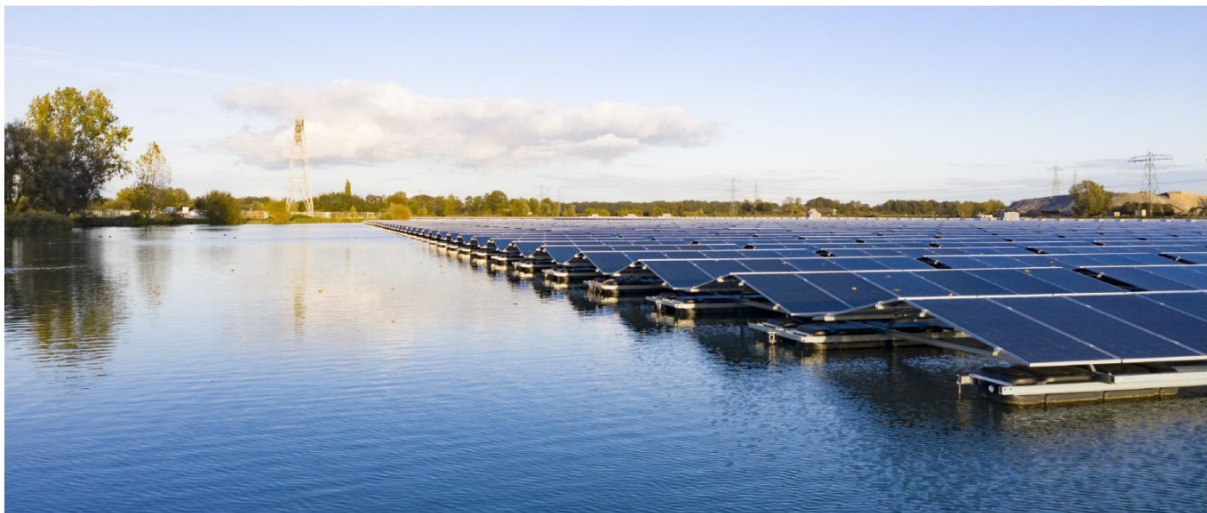
Afbeelding 2. Illustratie beoogd type drijvend zonnepark (Zim Float)
