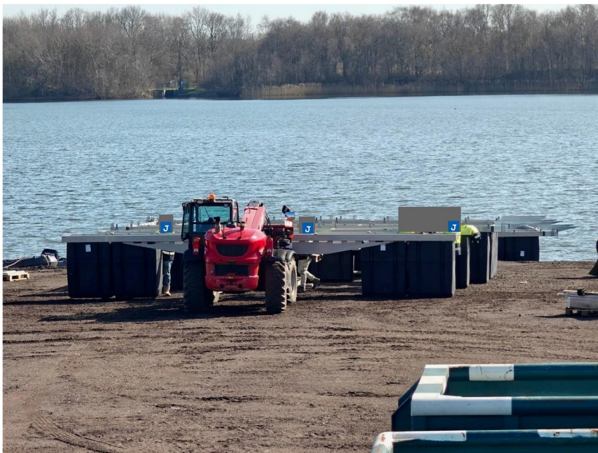
Zicht op de bouwplaats met de pontons.
