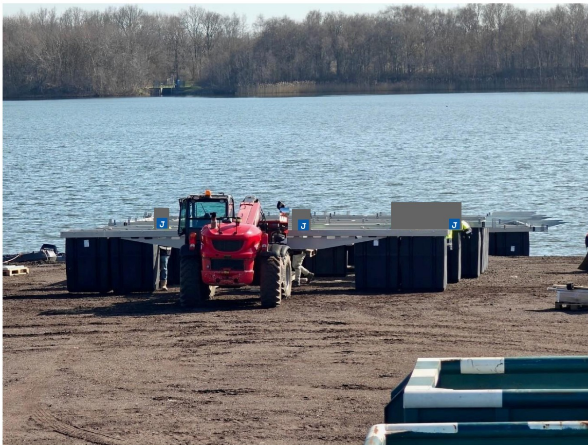
Foto 1: Zicht op de bouwplaats met de pontons.
