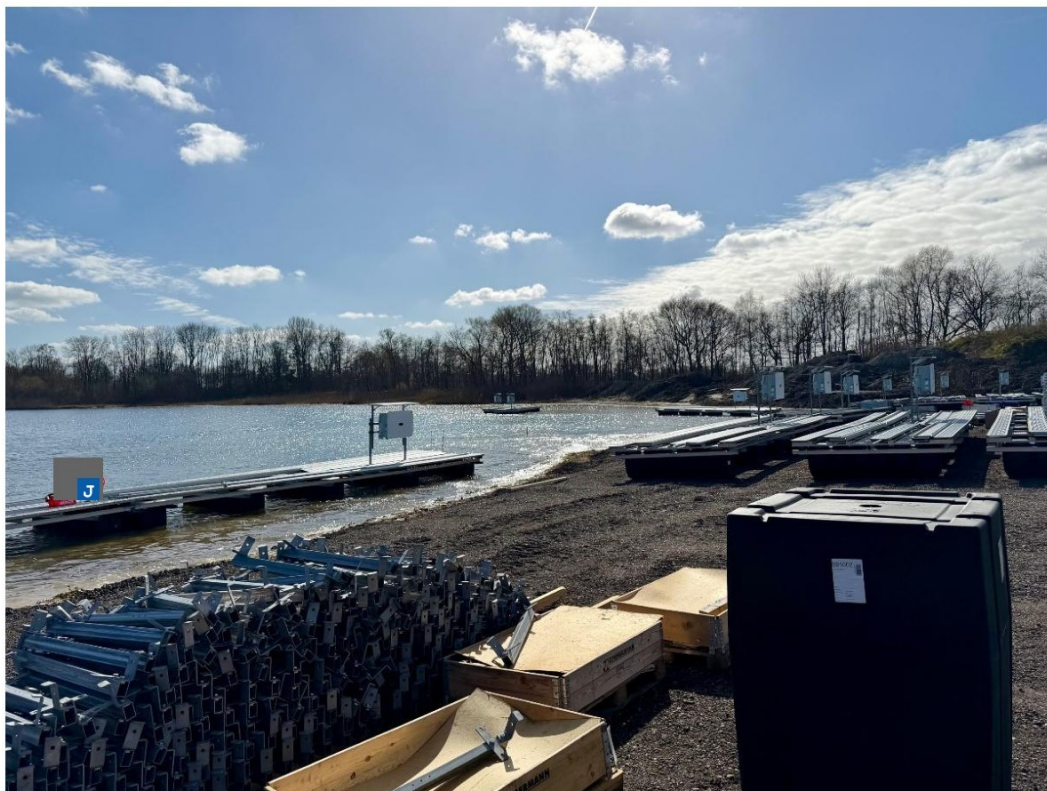
Foto 1: zicht over het bouwterrein op de westkant van de vml. zandwinput.
