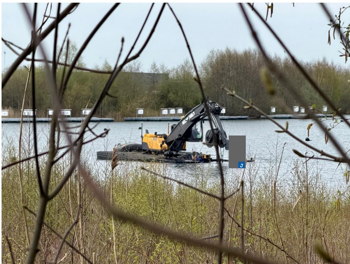
Foto 2: Werkzaamheden op het water met op de achtergrond pontons met omvormers
