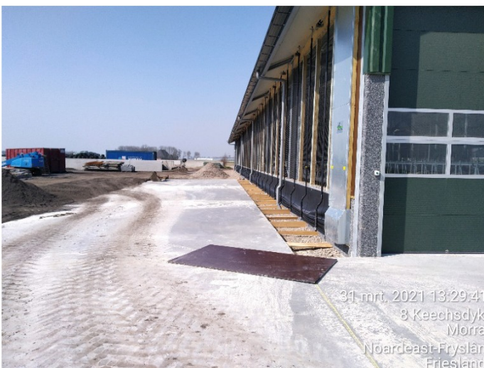
De betonvloer aan de linkerzijde zal worden doorgetrokken rondom de stal met de melkkoeien
