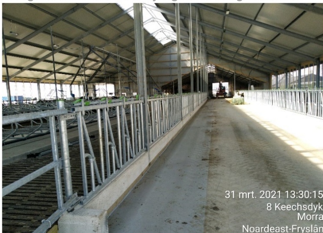
De ligboxenstal met roostervloer (BWL 2010.30.V1) in opbouw
