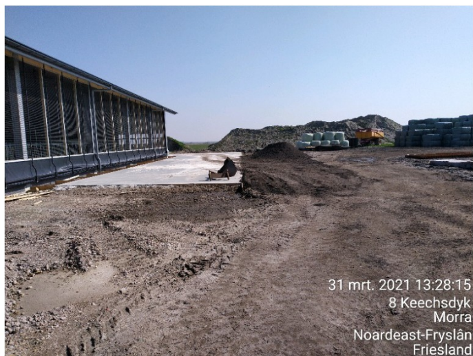
De betonvloer aan de linkerzijde zal worden doorgetrokken rondom de stal met de melkkoeien
