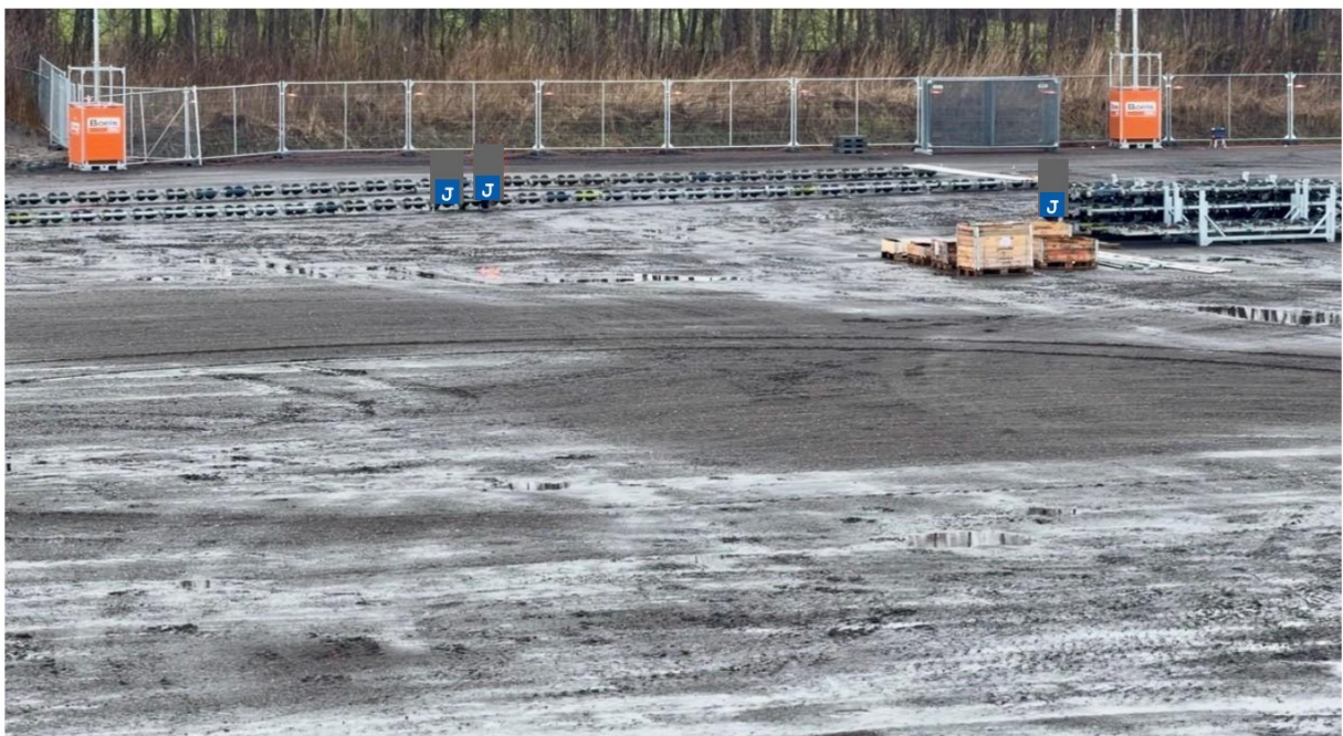
Foto 2: bouw van de rails voor de zonnepaneelboten.
