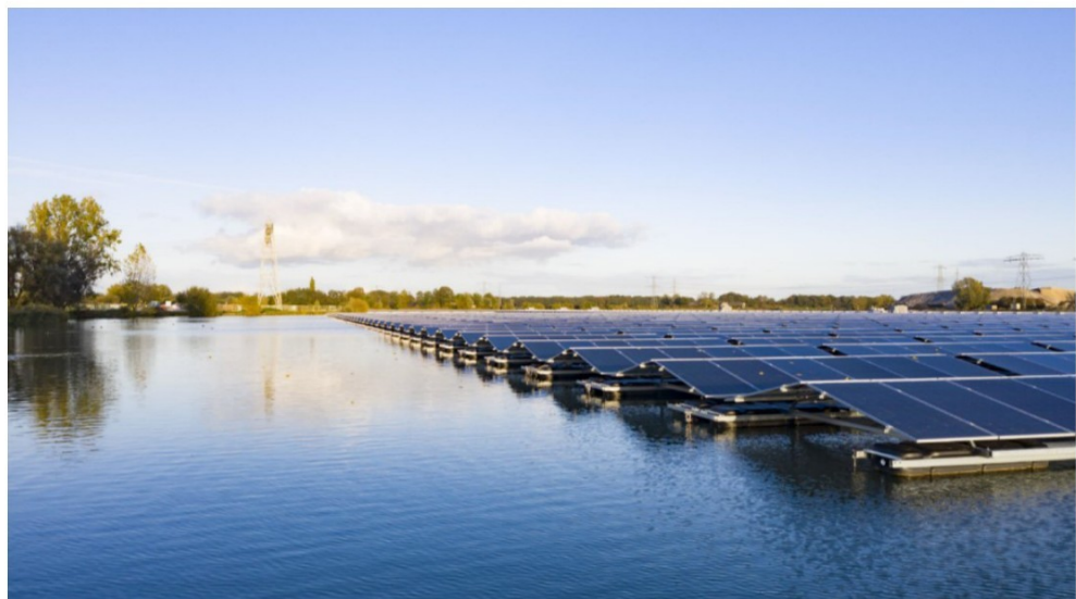
Afbeelding 3.6 Illustratie beoogd type drijvend zonnepark (Zim Float)
