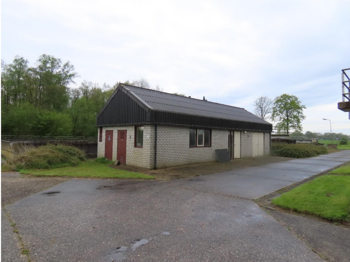
Figuur 2.1. De uiteinden van de gegolfde dakplaten op het werkgebouw lopen steil naar beneden.
