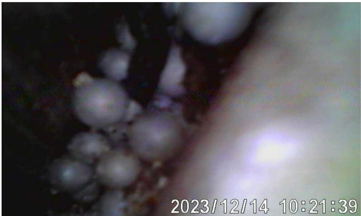
Figuur 21. Polystyreen korrels tezamen met oud isolatiemateriaal. Hier is tweemaal isolatie uitgevoerd
