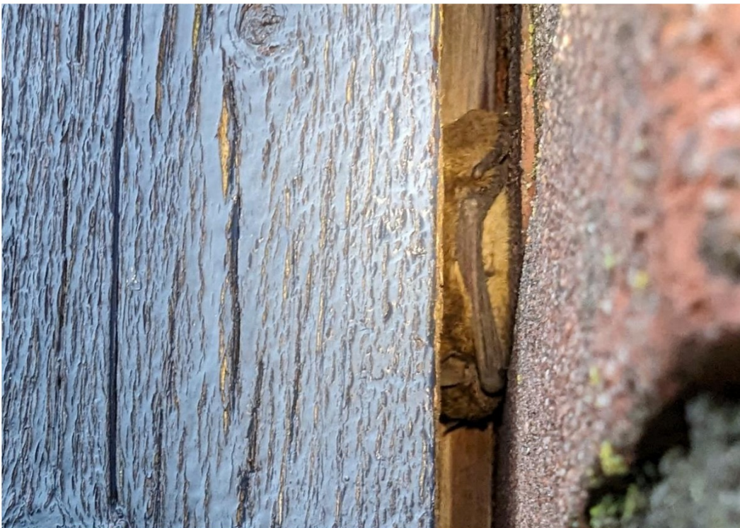
Figuur 19. Ruige dwergvleermuis achter houten bekleding van een gevel.
