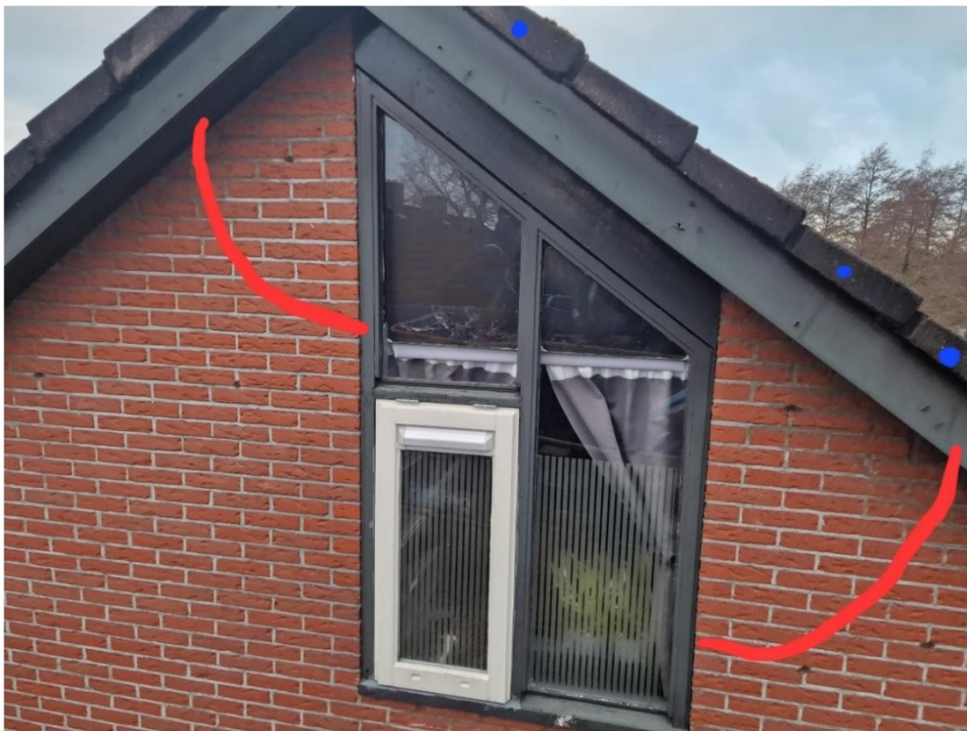
Figuur 2. Voorbeeld van een kopgevel met boorgaten waarlangs de spouw is gecontroleerd. De rode lijnen maken inzichtelijk waar, naar schatting, de restruimte (zonder isolatiemateriaal) aanwezig is. Foto Cynthia Hardeman.
