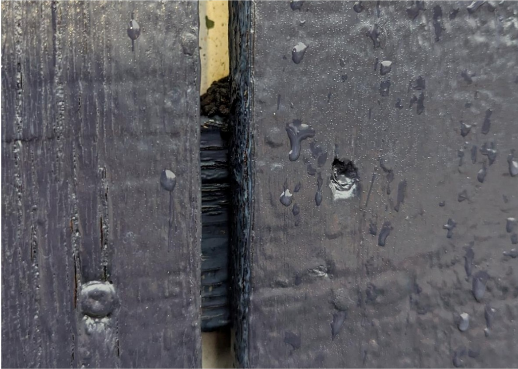
Figuur 18. Uitwerpselen van vlermuizen achter houten bekleding van gevels.
