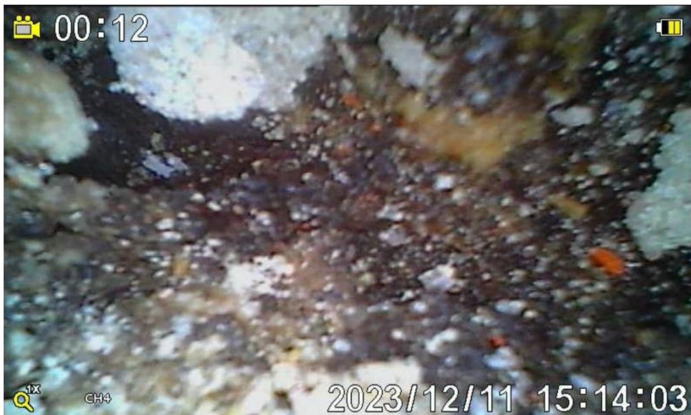
Figuur 17. Beeld uit een filmopname van een grote hoeveelheid vleermuisuitwerpselen in een spouw.
