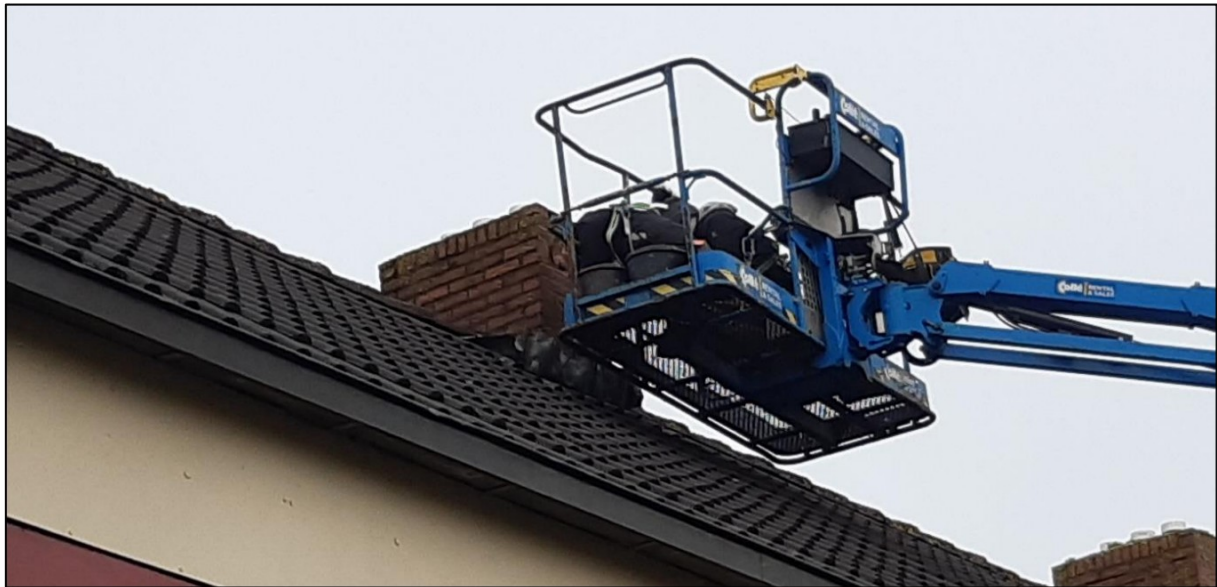
Figuur 4. Cynthia Hardeman en Jordi van der Klooster voeren een inspectie uit van loodslabben vanuit een hoogwerker.
