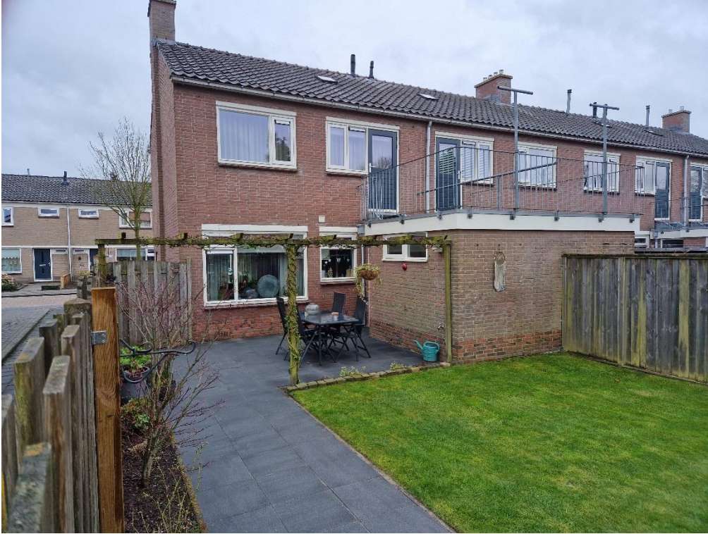
Figuur 13. Achterzijde van de woningen Kammingastrjitte 35 – 41.
