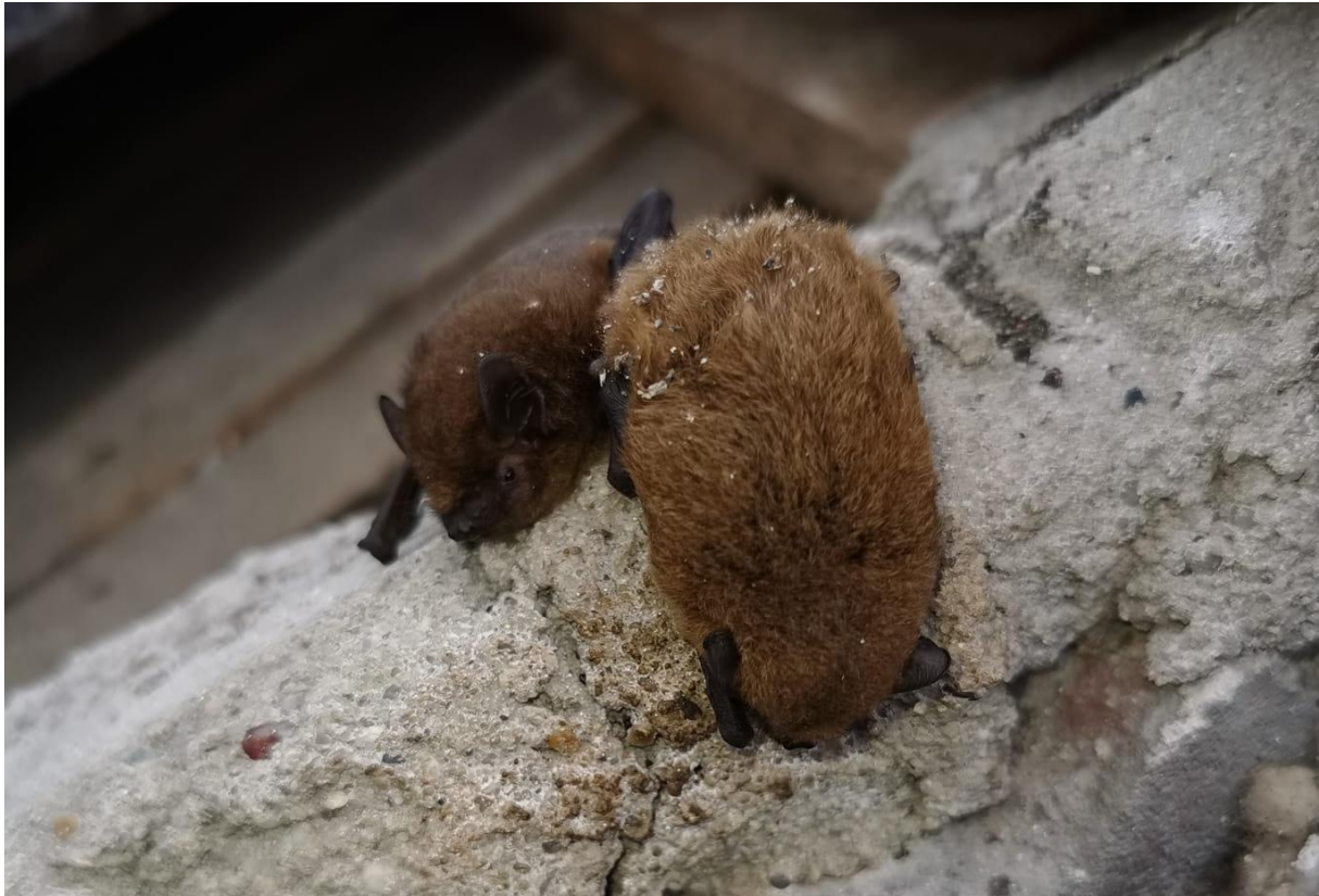
Figuur 5. Onder een kantpan bij nr. 35 werden twee gewone dwergvleermuizen aangetroffen. De bruine verkleuring van het cement maakt duidelijk dat deze plaats regelmatig door de vleermuizen wordt gebruikt.
