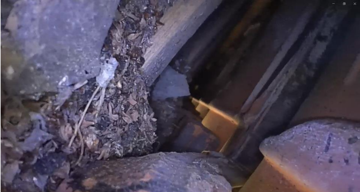
Figuur 3. Printscren uit een video opname gemaakt met de in figuur 2 weergegeven camera van de ruimte tussen dakbeschoot en dakpannen.
