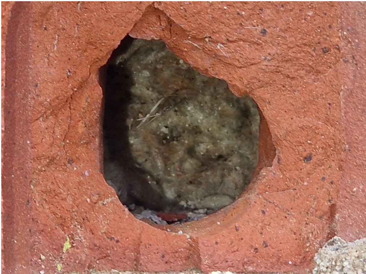
Figuur 4. Opening in de buitenmuur van een van de woningen waarin inblaaswol zichtbaar is. Hieruit, en uit de inspectie met endoscoop, bleek dat de spouwmuren volledig gevuld zijn.
