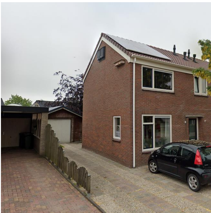
Figuur 2.10 De woning aan de Oosterstraat 80 te Witmarsum (foto 2022). Inmiddels zijn de kasten verplaatst.
