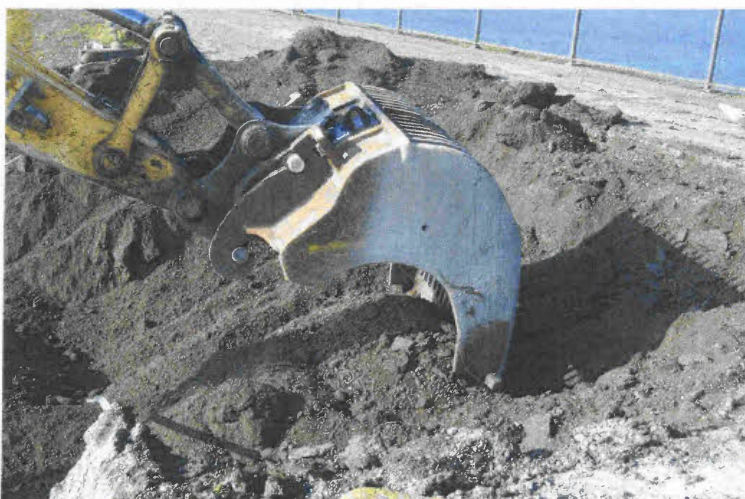
Foto 1. Proefsleuf in de dijk rondom de Averijhaven, 14 jaar na aanleg.
