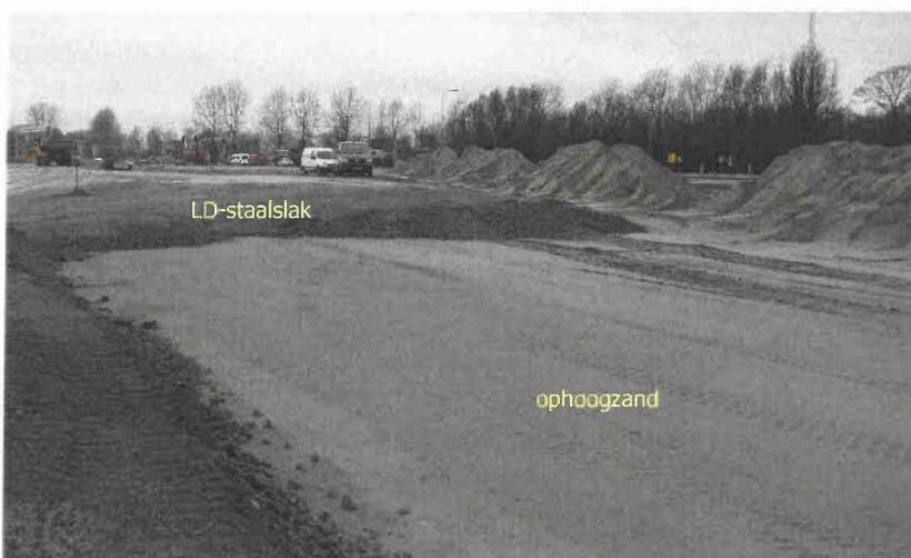
Foto 2. Aanleg van een sandwichconstructie afwisselend 0,5 m LD-staalslak en 0,5 m ophoogzand.
