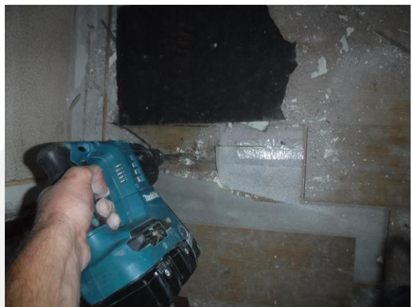
Inspectie onder laminaat.
