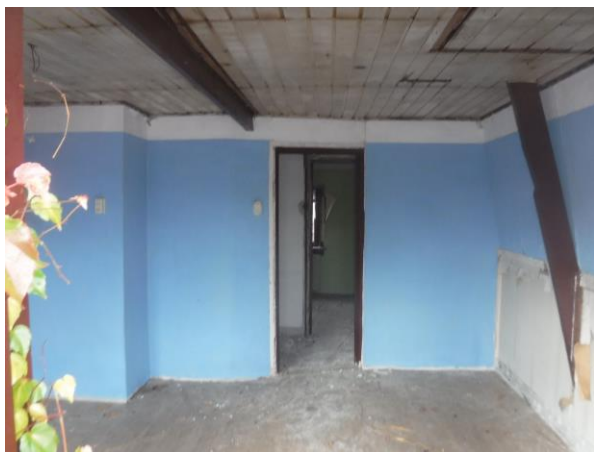
Eerste etage: laminaat over de houten verdiepingvloer. Houten plafonds.
