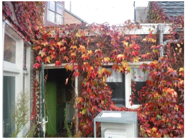
Aanbouw; gedeelte met plat dak.
