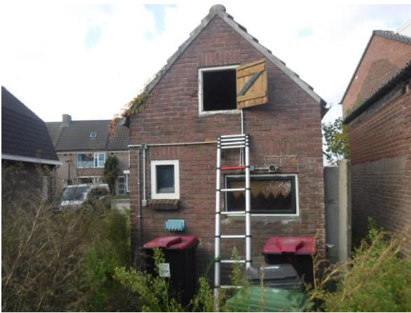
Aanbouw; gedeelte met pannen dak.
