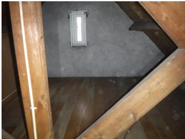
Houten kapconstructie en zoldervloer.
