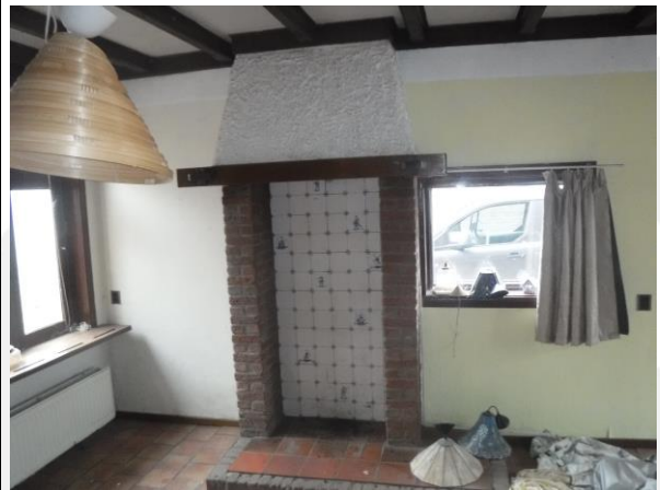
Gemetselde schouw: geen verdachte materialen in deze schouw en schoorsteen.
