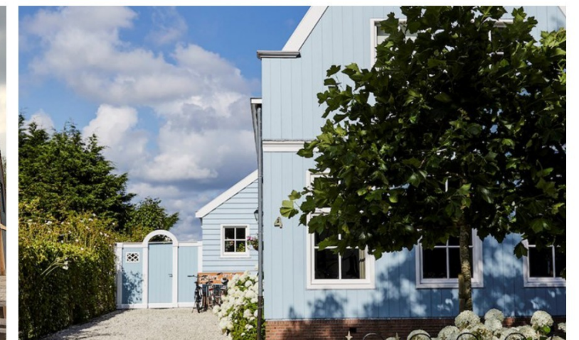
Stijl van woningen aan het Lint
