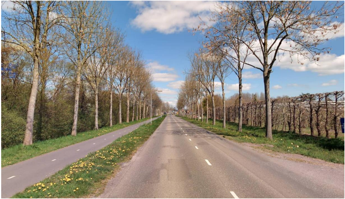
Afbeelding 1.3 De inrichting van de Hoornseweg met vrijliggend fietspad en bomenstructuur aan beide zijden.
