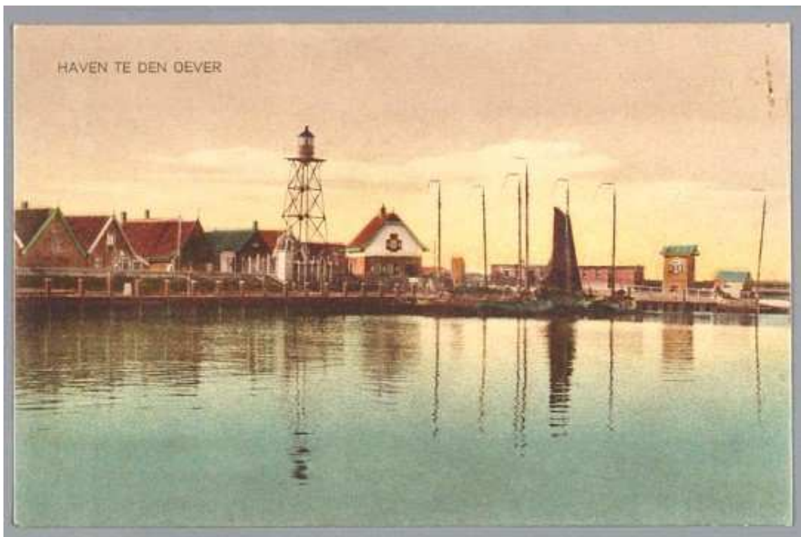
Figuur 2-5 Den Oever en met rechts het peilschaalgebouw omstreeks 1930. Links naast het peilschaalgebouw, het gebouw van de toenmalige Visafslag
