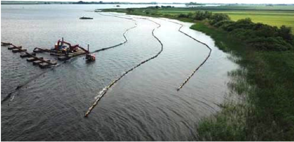
Figuur 1 Aanleg ondiepe zone in de Kûfurd
