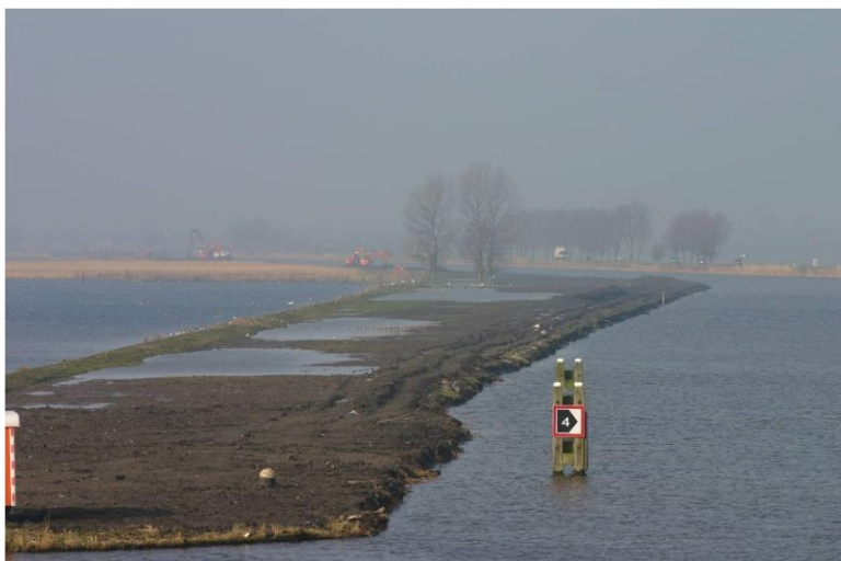
Saskerleidam (fase 1) vóór werkzaamheden in 2010
