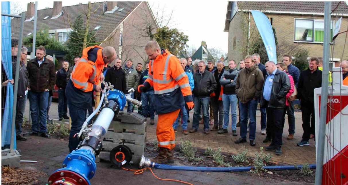
Foto: Persleidinginspectie door inspectierobot
