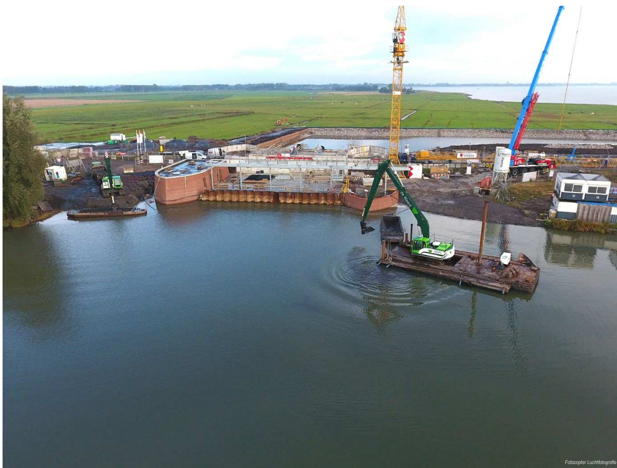
Foto: Laatste werkzaamheden gemaal C. Mantel
