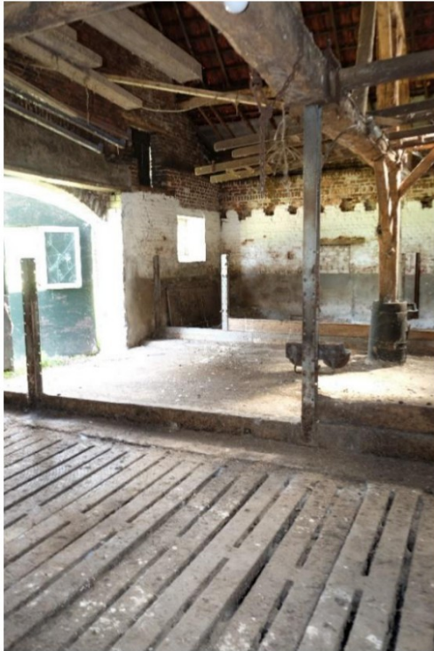
De betonnen vloerelementen van de stal hergebruiken als buitenbanken op het terrein of als nestgelegenheid voor vleermuizen.
