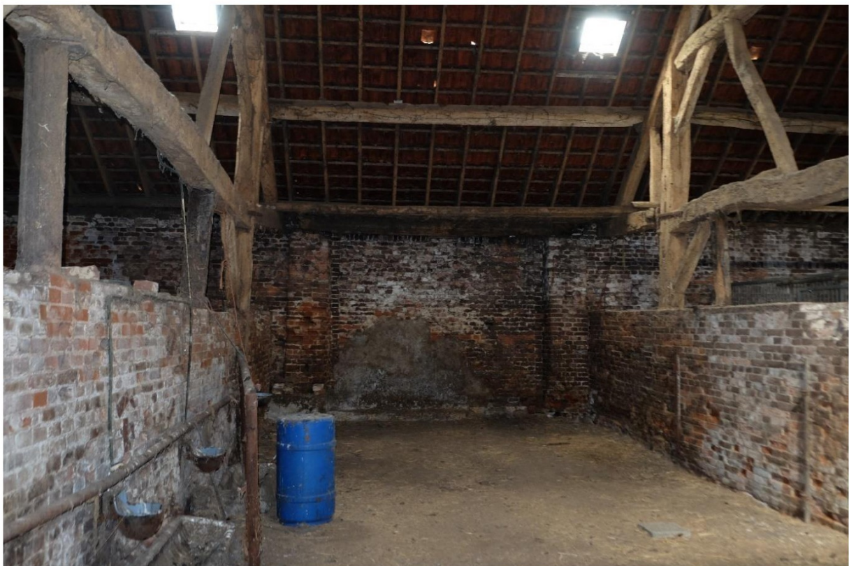
Terugbrengen oorspronkelijke dwarsdeelschuur openingen. Verlagen muren onder gebinten tot vloerniveau voor verhoogde bruikbaarheid.
