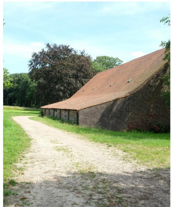
Aanbouw tegen oude schuur verwijderen
