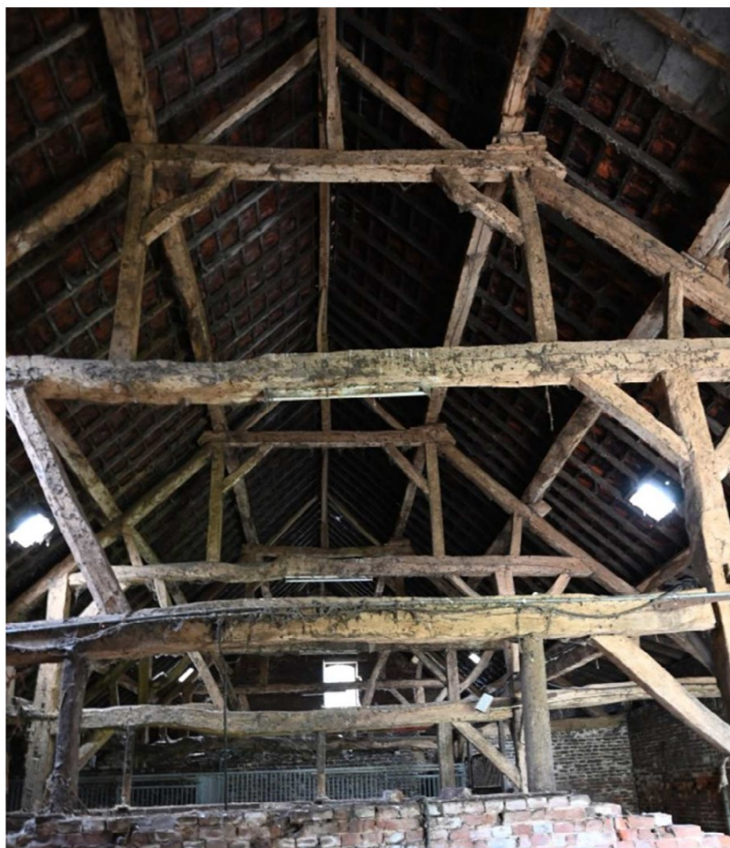
Spanten in grote schuur
