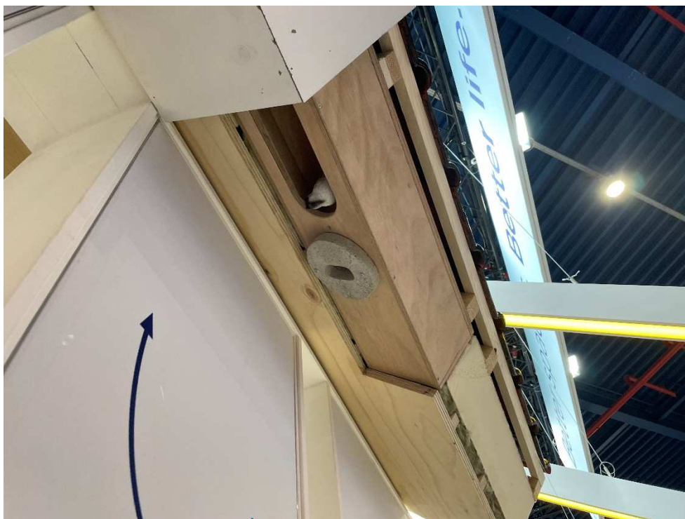
Nestkast maken in de dakconstructie
