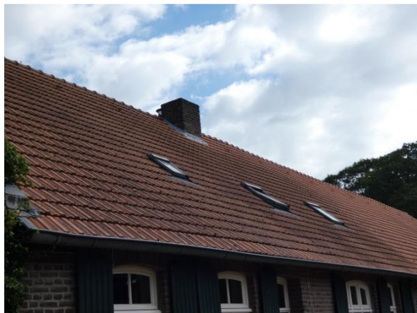
Afb. 3. Dak met muldenpannen. De schoorsteen hoort bij de oorspronkelijke stookplaats van de herd/keuken.
