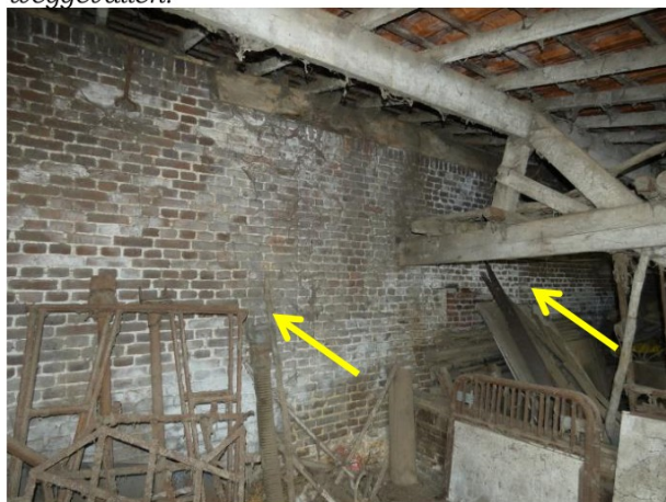
Afb. 120 Dichtgezette poortopening onder eikenhouten latei. Aan weerszijde is een rij klezoren zichtbaar (gele pijlen).
