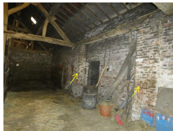
Afb. 137 Muurdammen aan weerszijde van de voormalige poortopening in de zijgevel.
