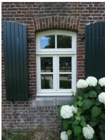
Afb. 244 Achttiende-eeuwse vensteropening in de westgevel.
