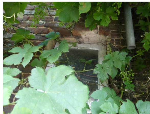
Afb. 193 Later geplaatst venster in de zuidelijke gevel van het zuidoostelijke volume.
