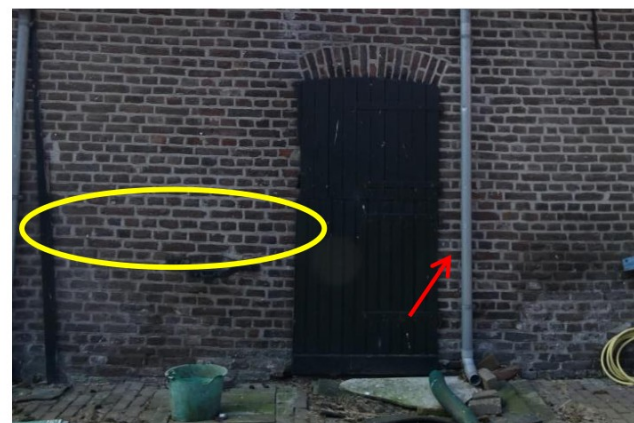
Afb. 39 Oude staldeur, geplaatst onder segmentboog. De deur is van binnenuit dichtgezet. Rechts van de deur is een rij klezoren zichtbaar (rode pijl). Het gele ovaal omcirkeld de opvallende dubbele rij koppen.
