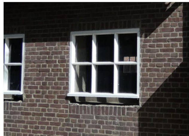
Afb. 24. Een van de betonvensters. De rollaag onder de vensters is smaller dan het venster.
