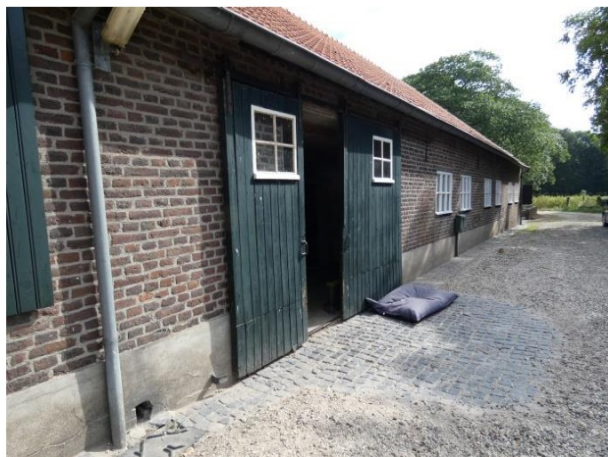
Afb. 20. Zuidgevel: overzicht stal.
