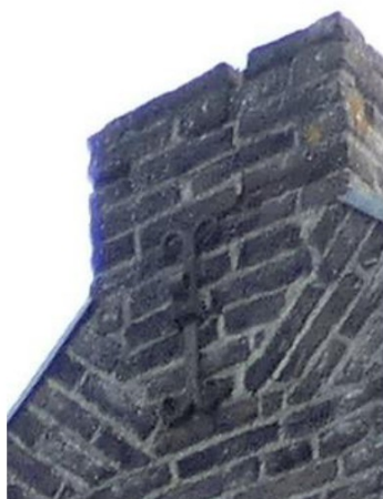
Afb. 13 Krulanker in de geveltop.
