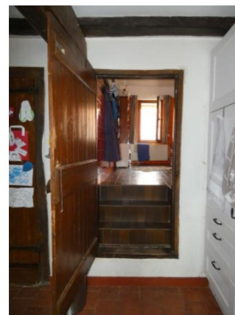
Afb. 85 Bakstenen trap vanuit de keuken, met tegels bekleed.
