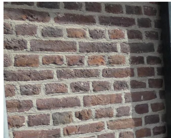
Afb. 5 Grove, gemëleerde veldbrandsteen (groot formaat), voeg deels voorzien van dagstreep.
