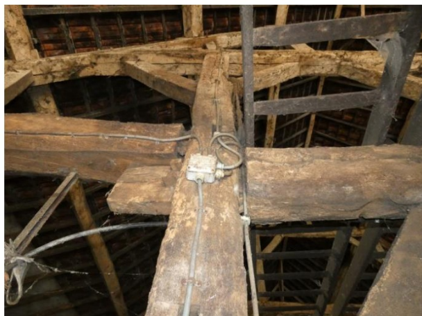
Afb. 145 Detail van de zuidelijke gebintstijl van het oostelijke spant.
