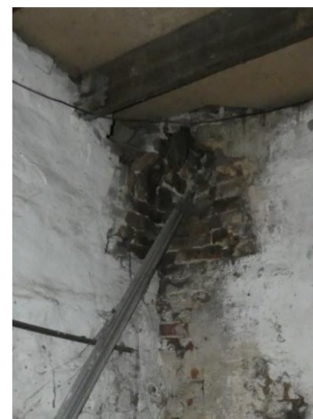
Afb. 199 Sporen van het rookkanaal.
