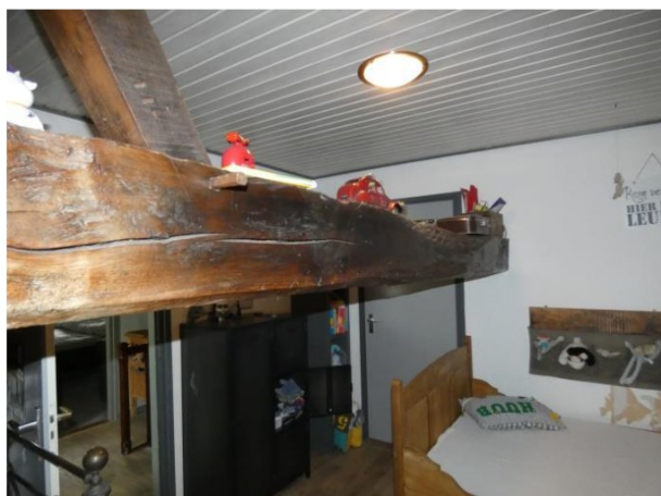
Afb. 97 Impressie oostelijke slaapkamer, met dwars door de ruimte de dekbalk van het spant.
