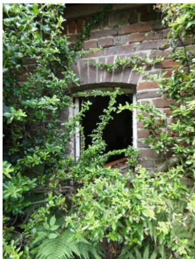
Afb. 186 Getoogd venster onder hanenkam en rollaag ter afsluiting van de gevel.
