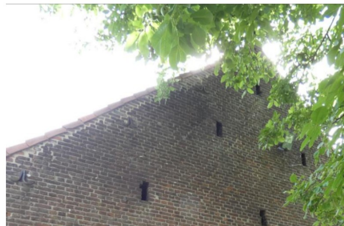
Afb. 125 Uilen- of duivengaten en haakvormige ankers.
