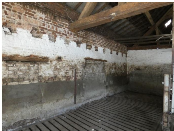
Afb. 135 Balkgaten van een voormalige slietenzolder boven de zuidelijke zijbeuk.
