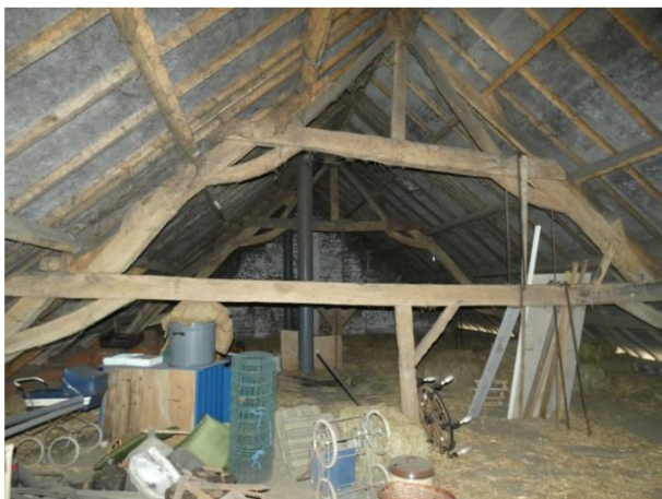
Afb. 56 De twee oostelijke spanten: zoldergebint, vlieringgebint en nokgebint.
