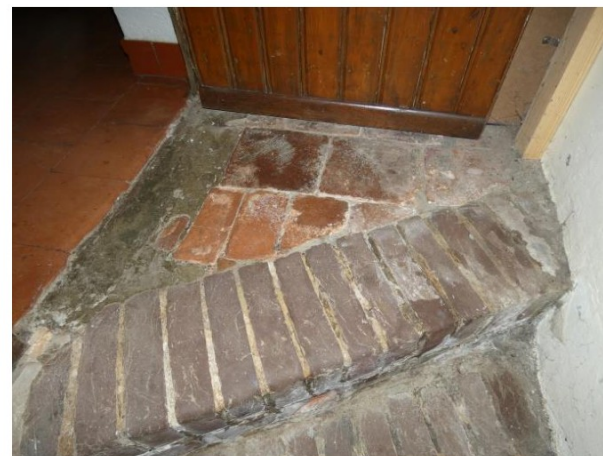
Afb. 76 Authentieke rode plavuizen onder de trap.
