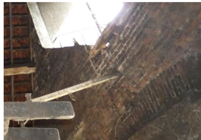
Afb. 129 De oorspronkelijke segmentboog (anderhalf streks) is aan de binnenzijde nog herkenbaar. De kruin bevindt zich 11 rijen onder het hooiluik.
