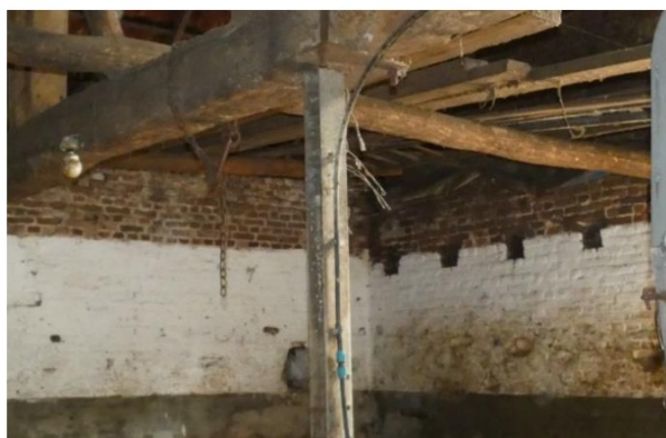
Afb. 136 Balkgaten in de oostelijke gevel, boven de noordelijke stal.
