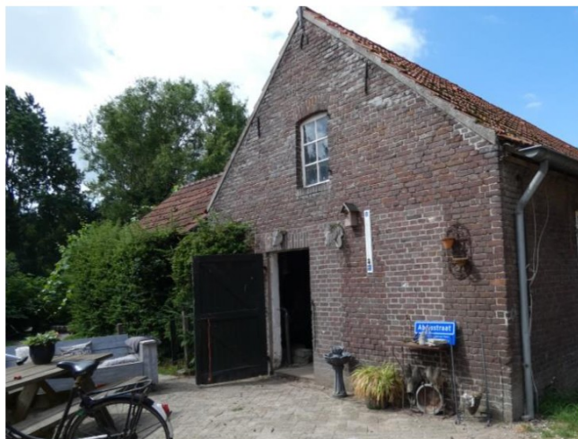
Afb. 183 Oostgevel van de stal.
