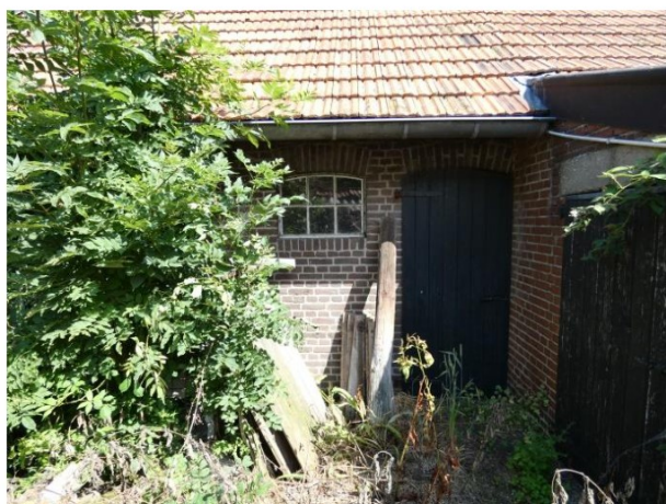
Afb. 196 Zuidelijke gevel van de westelijke stal: staldeur en -venster onder segmentboog.
