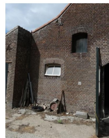
Afb. 131 Stalvenster, uitgevoerd als tweeruuts tuimelraam onder segmentboog. Linksboven de opgehoogde gevel.
