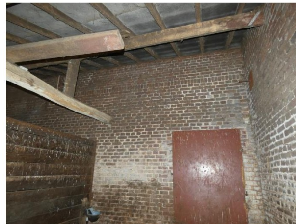
Afb. 115 Dichtgezette staldeur in het vierde travee (vanuit het westen gezien).
