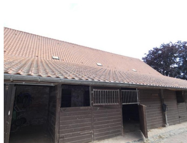
Afb. 154 Open schuur, later voorzien van rabatbeschot en staldeuren.
