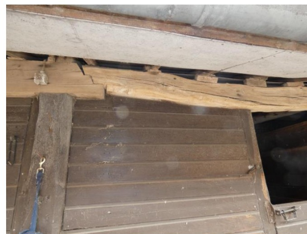
Afb. 155 Hergebruikt materiaal: links een grenen dekbalk, rechts een eiken dekbalk, beide via een lasverbinding gekoppeld.
