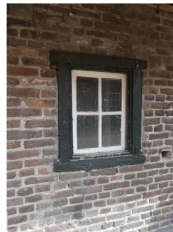
Afb. 150 Authentiek kozijn met sponning in de zuidgevel.
