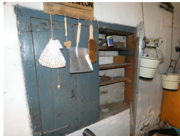
Afb. 92 Voormalige doorgang naar de stal, nu in gebruik als ondiepe wandkast. Authentieke luiken.
