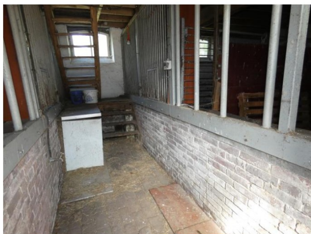
Afb. 169 De voergang, met authentieke bakstenen muurtjes. De kei-formaat klinkers zijn niet authentiek, echter wel karakteristiek.
