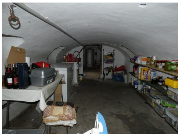
Afb. 61 De kelder, gezien vanuit het westen.
