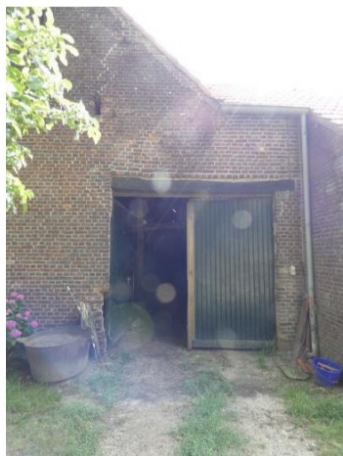
Afb. 254 'Nieuwe' bandeuren in de westelijke kopgevel.
