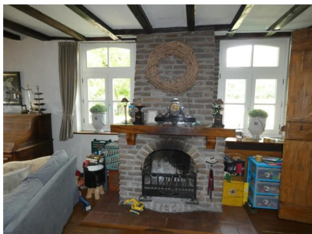
Afb. 67 Moderne stookplaats. De kinderbalken tussen de moerbalken en de westgevel, inclusief de raveling zijn uitgevoerd in grenen en dateren uit circa 1900.
