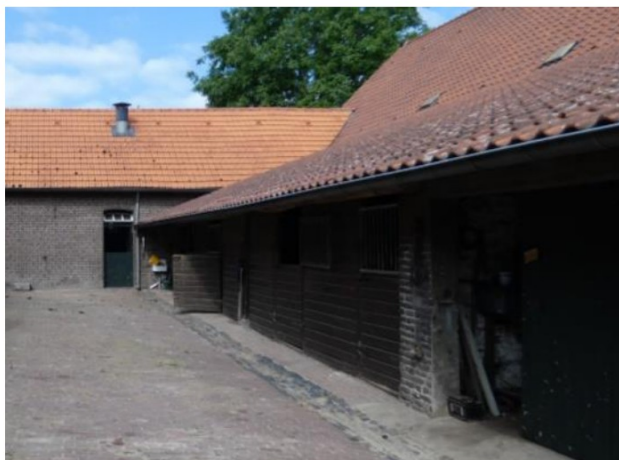
Afb. 252 Aanbouw tegen de zuidgevel van de schuur.
