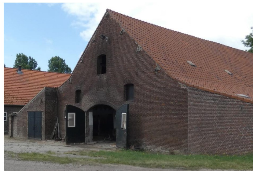
Afb. 126 Oostgevel van de schuur, gezien vanuit het noordoosten.
