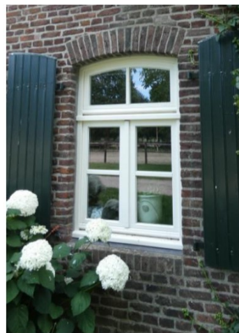
Afb. 245 Vroeg-twintigste-eeuwse vensteropening in de westgevel.
