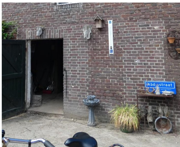
Afb. 184 Bouwsporen die erop duiden dat de deur oorspronkelijk meer naar echts lag (onder het geveltopvenster) en dat er rechts een venster zat.
