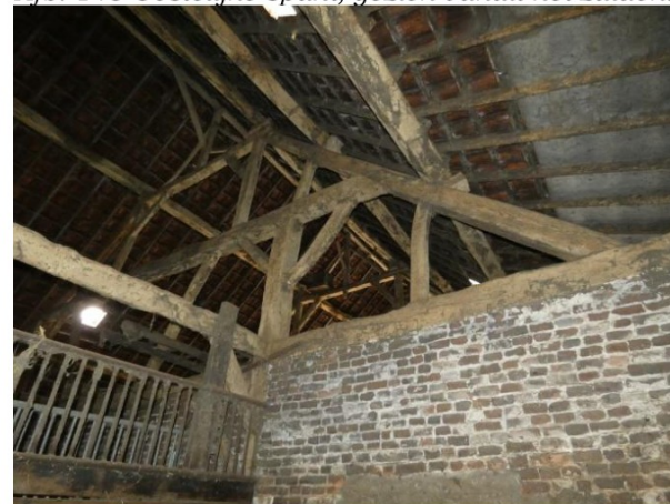
Afb. 144 Derde spant vanuit het westen, op de muur tussen dwarsdeelschuur en stallen gelegen.
