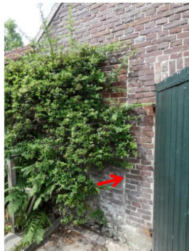
Afb. 187 Verticale bouwnaad: overgang van ouder zuidoostelijk volume naar stal uit 1910-1930.
