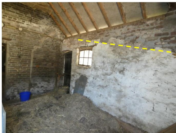
Afb. 205 Zuidelijke gevel. De diagonale belijning in het muurwerk is duidelijk herkenbaar.
