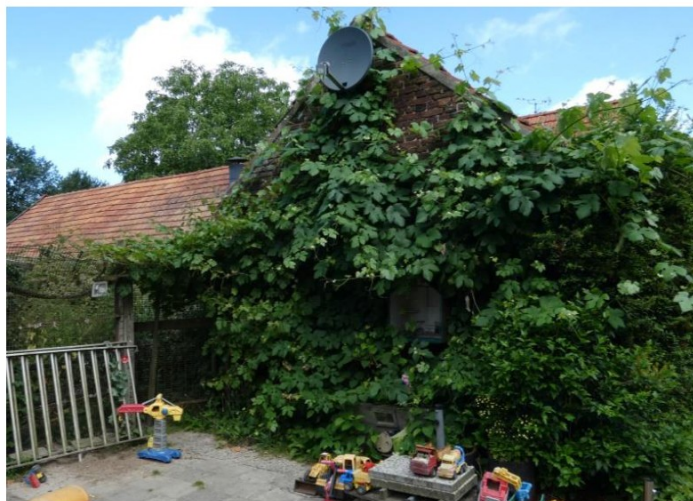
Afb. 192 Zuidgevel zuidoostelijk volume.
