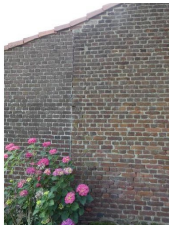
Afb. 122 Aansluiting van de aanbouw op de schuur. De gevel wordt afgesloten door een rij klezoren.
