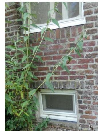
Afb. 11. Het metselwerk tussen beide vensters is vervangen.
