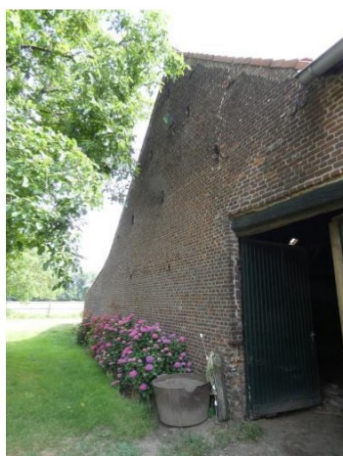
Afb. 123 Westelijke gevel vanuit het zuiden gezien.
