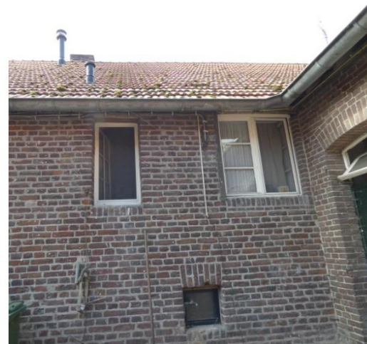
Afb. 33 Middenboven een authentiek opkamervenster. Midden onder een authentiek keldervenster. Het venster rechtsboven is na de bouw van het koppelstuk aangebracht.
