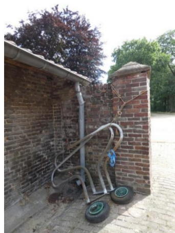
Afb. 240 Doorgetrokken oostelijke stalmuur en de later geplaatste pijler.
