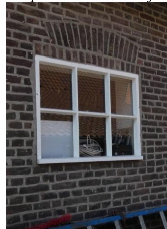
Afb. 40 Segmentboog boven het venster, rechts van de deur.
