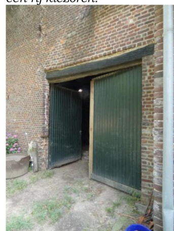
Afb. 124 De later geplaatste bandeuren.
