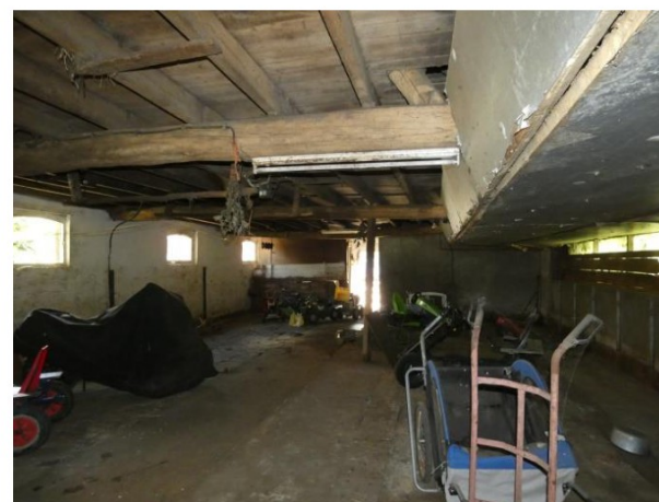
Afb. 202 Impressie van de stal, gezien vanuit het westen.
