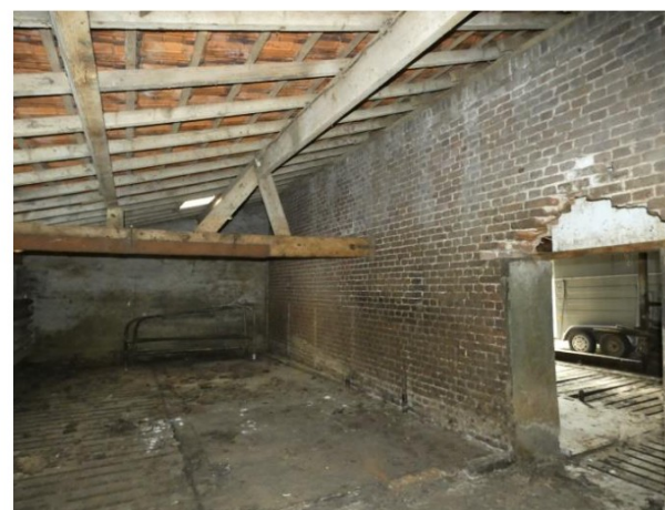
Afb. 118 Blinde zijgevel met kopse rollaag aan de bovenzijde. Geheel rechts de staldeur.
