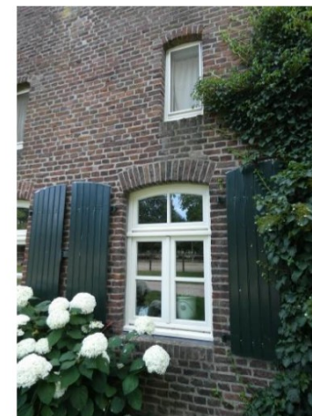
Afb. 9 Venster, circa 1900, geplaatst onder strekse segmentboog.
