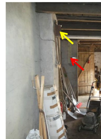
Afb. 200 Westelijke wand. De rode pijl wijst de noordelijke gevel van het zuidoost volume aan. De gele pijl het I-profiel.
