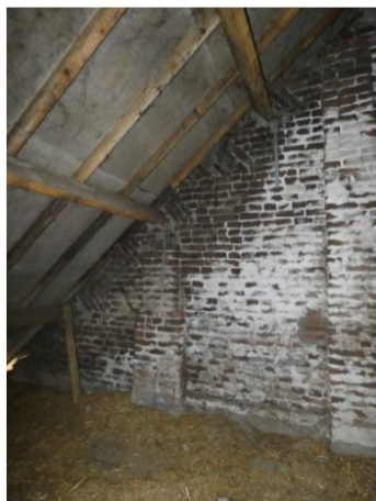
Afb. 30 Noordelijke gedeelte van de achtergevel van het hoofdvolume, met steunberen en vlechtwerk.
