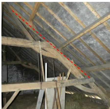
Afb. 56 De twee oostelijke spanten: zoldergebint, vlieringgebint en nokgebint.
