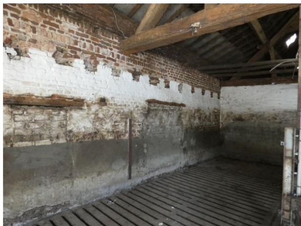
Afb. 117 Dichtgezette staldeur en stalvenster onder eiken latei, gezien vanuit de schuur.
