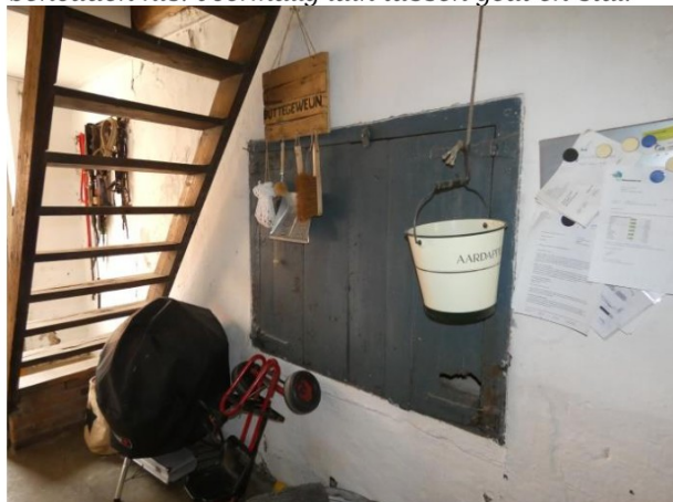
Afb. 48 Nog behouden luik (nu ondiepe wandkast) tussen geut en stal. Op de foto is ook te zien dat links (ter plekke van de zoldertrap) geen doorgang zit die bij een grupstal te verwachten is.
