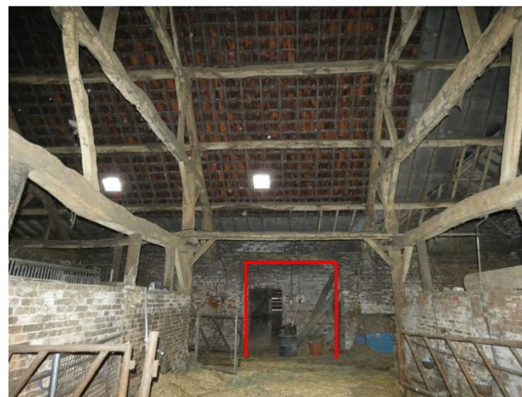
Afb. 253 Dichtgezette dwarsdeeldeuren in de zuidgevel.
