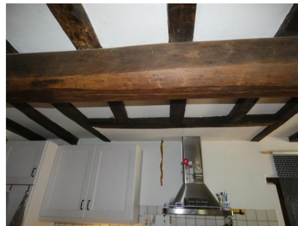
Afb. 75 De moerbalk en de raveling van de oorspronkelijke stookplaats.
