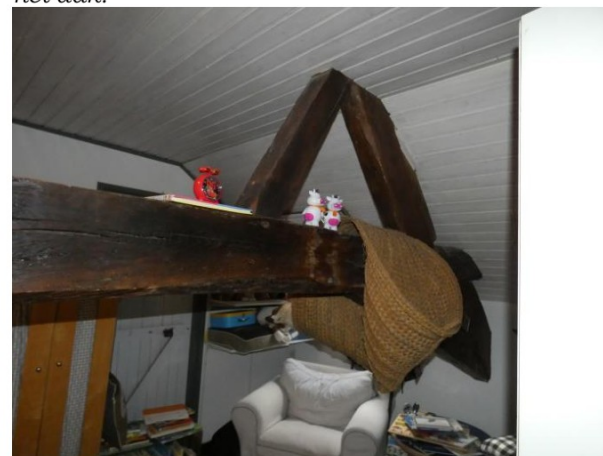
Afb. 59 Dekbalk van het zoldergebint in de slaapkamer boven de keuken (tweede spant).
