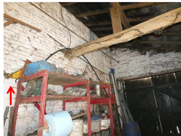
Afb. 116 Geveldeel onder de stal tegen de zuidoost gevel. Linksonder is de segmentboor van een stalvenster zichtbaar.
