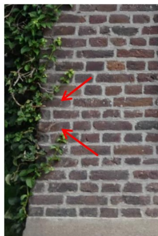
Afb. 221 Kruisverband met drieklezoren bij de boerderij.
