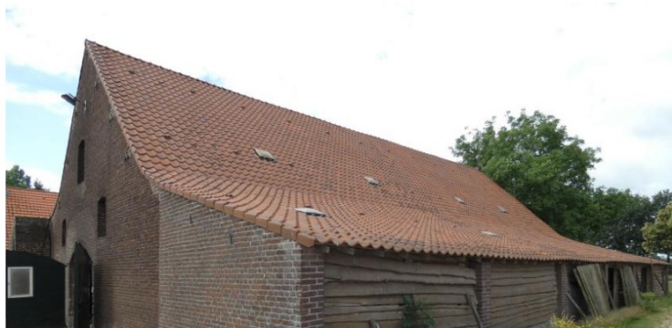
Afb. 111 Verbeterde pannen op het dak. Tegen de zijgevel van de schuur staat een naoorlogse aanbouw.
