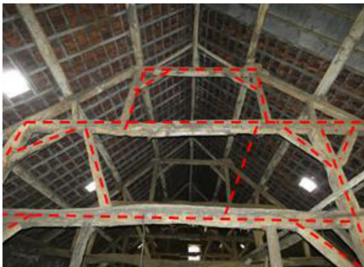
Afb. 219 Westelijke gebint van de schuur (één gebintstijlschoor ontbreekt). In rood de constructie van de oude vakwerkschuur.
