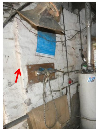
Afb. 188 Verdikking in de gevel (binnenzijde) ter indicatie van de overgang van het zuidoostelijke volume naar de stal.
