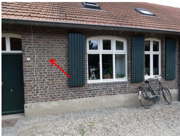
Afb. 17. Zuidgevel: voorhuis keuken en geut. De rode pijl geeft een rij klezoren weer (bouwspoor voormalig venster).
