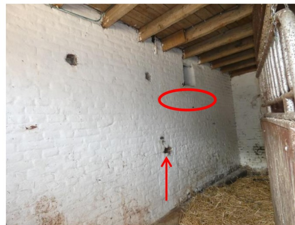
Afb. 34 Inpandig gelegen geveldeel van het voorhuis. De rode pijl wijst een hanenkam van een keldervenster aan (zie ook afb. 35), de rode ovaal omkadert een kopse rollaag van een opkamervenster.
