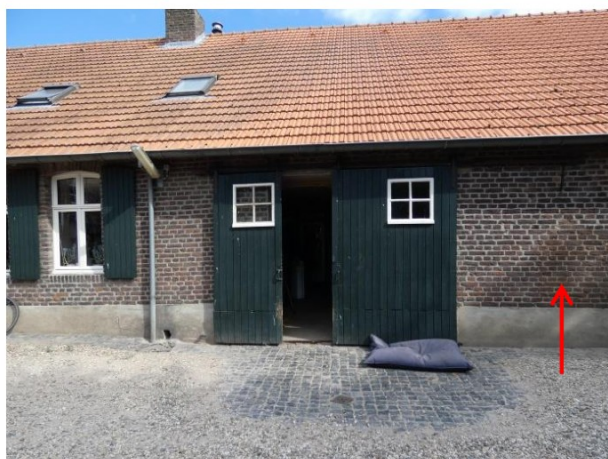
Afb. 21. Schuifpoort, vermoedelijk jaren vijftig. De rode pijl geeft een onder het staafanker zichtbaar bouwspoor weer.
