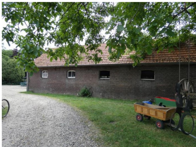
Afb. 179 Noordgevel van de stal: linker gedeelte.
