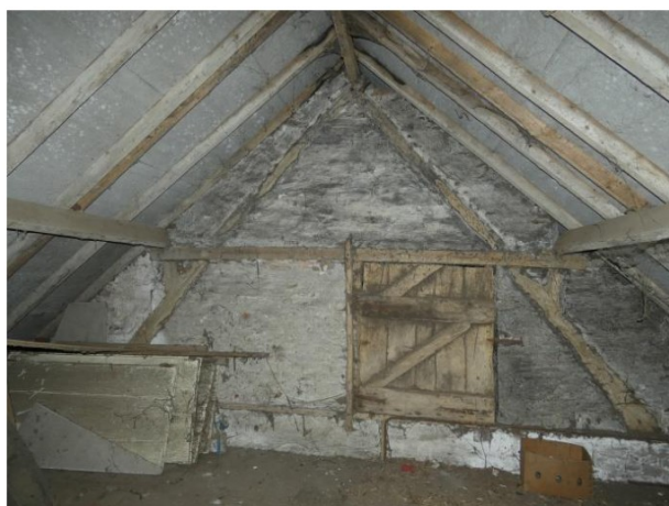
Afb. 176 Noordelijk spant, met baksteenvulling en luik: verbinding met de grote schuur.
