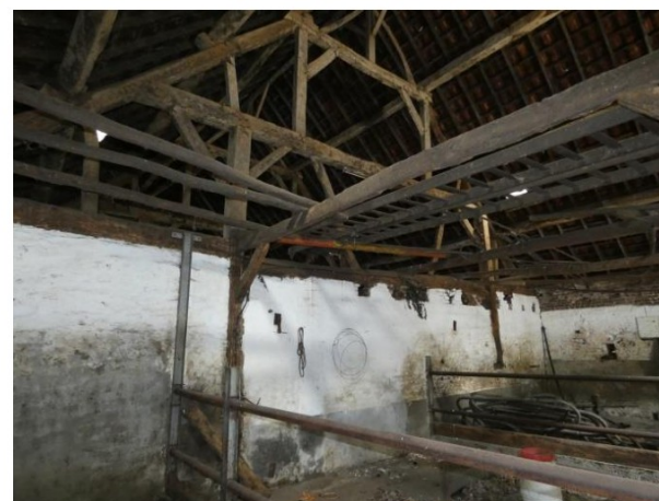
Afb. 134 Oorspronkelijke muur tussen voormalige tas en stal.
