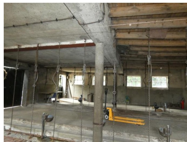
Afb. 104 Overgang tussen de oorspronkelijke stal (rechts) en de uitbreiding uit 1910-1930 met betonnen dek (links).
