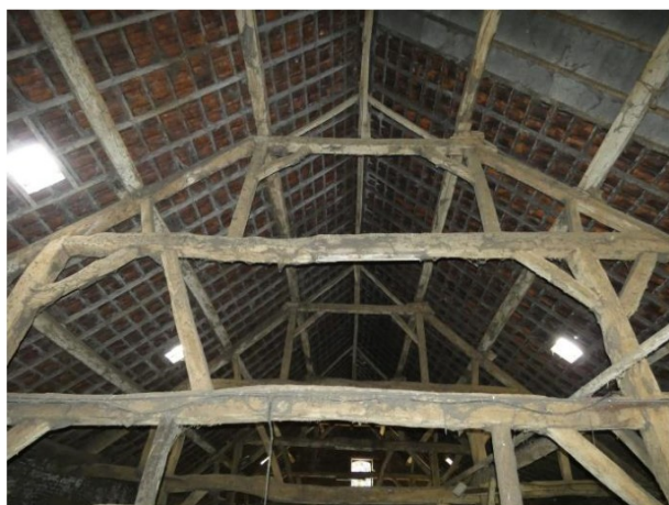
Afb. 142 Westelijke gebint. Rechts de oversteek van de dekbalk. Links steekt de balk door in de stijl.
