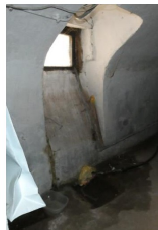
Afb. 63 Vensternis (oostelijk venster).
