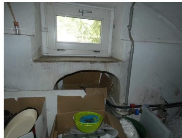
Afb. 62 Keldervenster uit circa 1900 in de westgevel. Hieronder een nagenoeg geveldikke nis.
