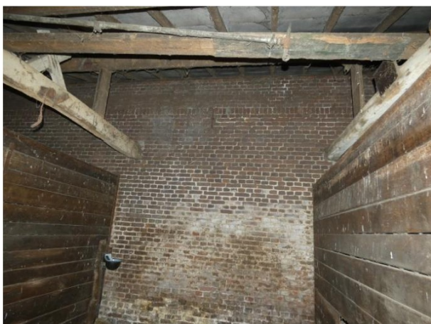
Afb. 114 Blind muurvlak, aan de bovenzijde afgesloten door een kopse rollaag. Hierboven is in de loop van de twintigste eeuw de gevel opgehoogd.
