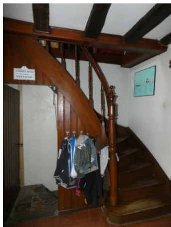
Afb. 77 Draaitrap met daaronder keldertrap.
