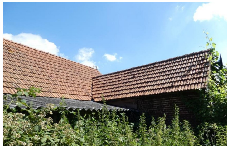
Afb. 178 Muldenpannen op het hoofdvolume en het zuidoostelijke volume. Profielplaten op de aanbouw tegen de zuidgevel van de stal.
