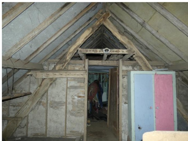
Afb. 175 Spant met leemwand.
