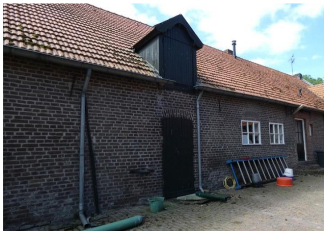
Afb. 37 Twee westelijke traveeën van de stal.
