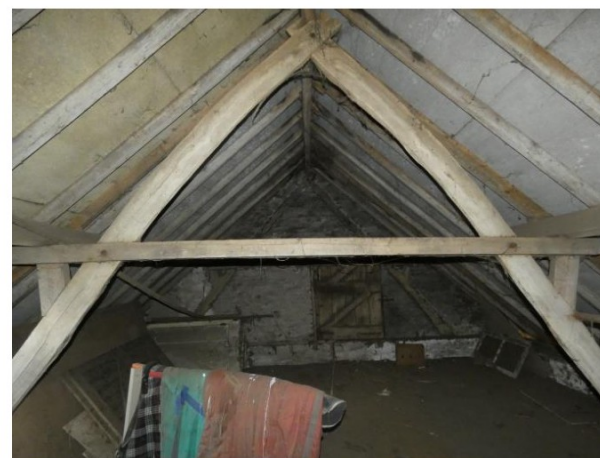
Afb. 174 Schaarspant (tweede, vanuit het noorden bezien).
