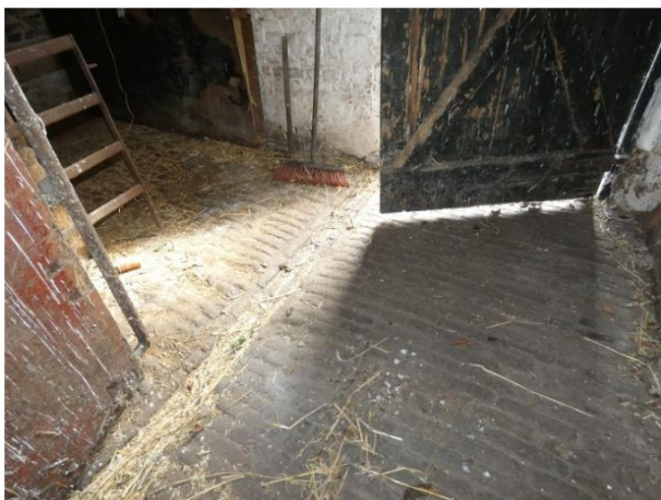
Afb. 173 Waaltjes vloer in de zuidelijke stal.
