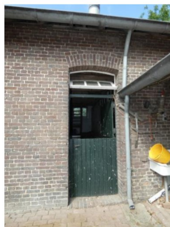
Afb. 168 Boerendeur met tuimelraam bij de centrale voergang.
