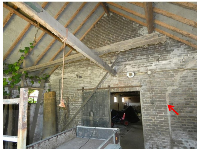
Afb. 203 Westelijke stal, oostelijke gevel (buitengevel hoofdstal). De rode pijl geeft de verticale naad weer: oorspronkelijke breedte poort. In de geveltop is het metselwerk in wildverband uitgevoerd.
