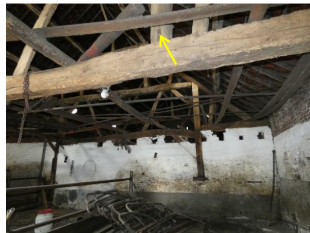
Afb. 147 Oostelijke gebint, noordzijde. Aan deze zijde zit geen tot de grond doorlopende gebintstijl (gele pijl), maar is een jukstijl op de moerbalk gelegd.
