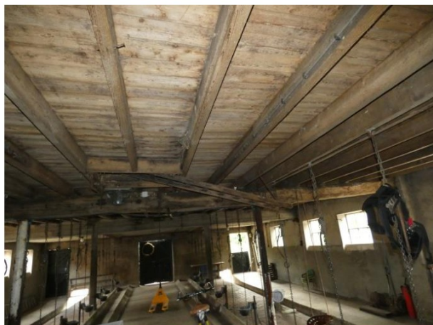
Afb. 105 Naoorlogse kinderbalklaag met mangat.
