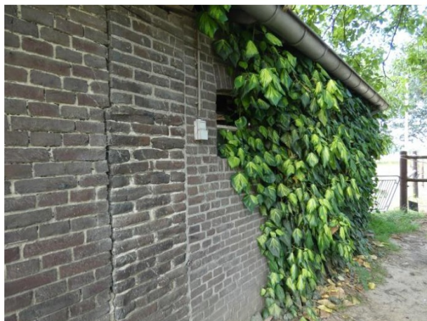
Afb. 181 Noordgevel van de stal: rechter gedeelte en opvallende tweestreks muurdam.
