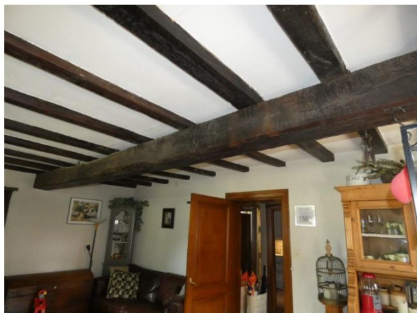
Afb. 66 Impressie van de goeikamer. De noordelijke zijde van de kinderbalken is rond 1900 vervangen door grenen exemplaren (vanaf derde balk van rechts op foto).
