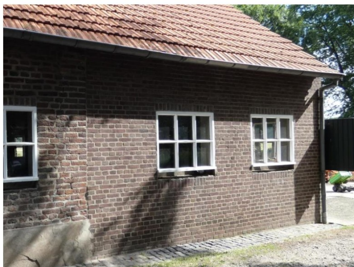
Afb. 23. Uitbreiding van de stal uit 1910-1930. De betonvensters zijn in de jaren vijftig-zestig toegevoegd.
