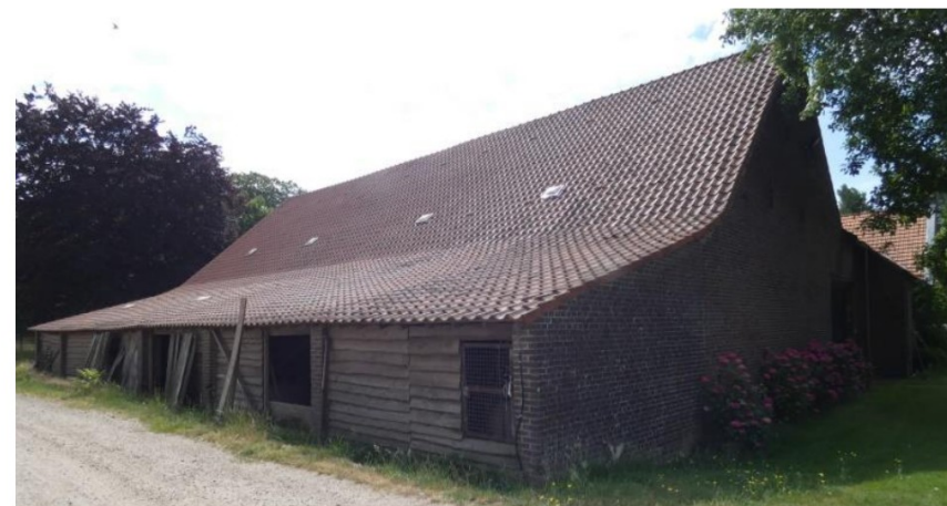
Afb. 251 Aanbouw tegen de noordgevel.
