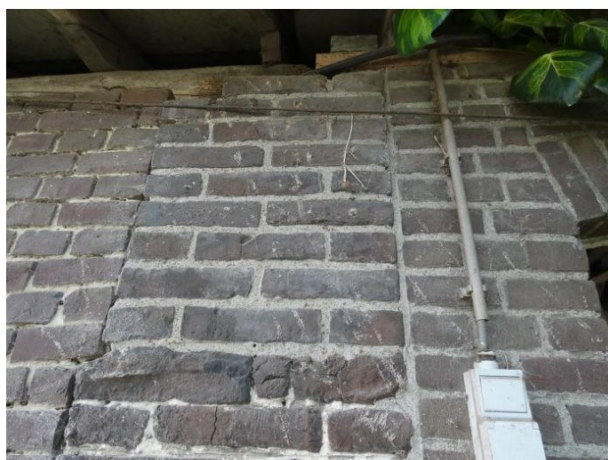
Afb. 182 Verschillende bakstenen: links de stal, rechts de westelijke stal (oorspronkelijk onder lessenaardak) in het midden de kopgevel met aan onderzijde veldbrandstenen.
