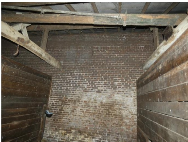
Afb. 156 Halfhoge houten wanden tussen de individuele stallen.
