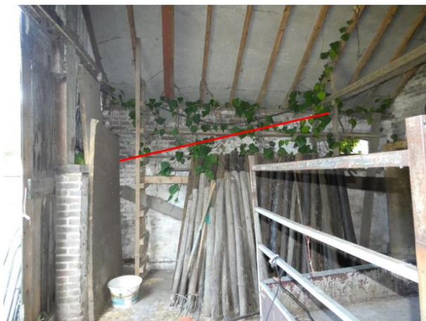
Afb. 256 Het ophogen van het volume is herkenbaar aan het contrast in muurwerk (andere baksteen en begrenzing van de witte verf).
