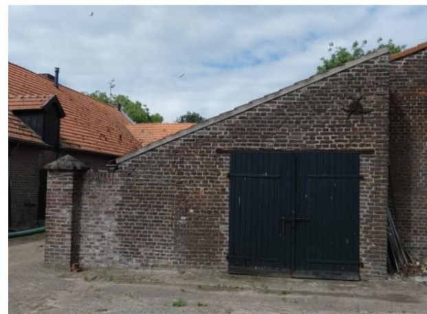
Afb. 152 Oostelijke gevel met later geplaatste poort.
