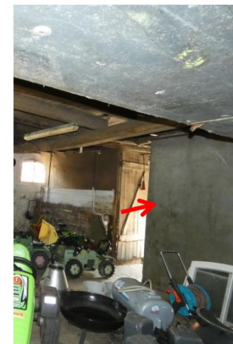
Afb. 189 Muur van het zuid-oostelijke volume, dat als bouwmasa in de stal staat.
