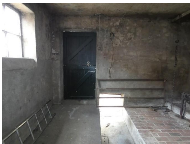
Afb. 106 Noordoost hoek met rechts de plavuizenvloer voor de koeien en in het midden de mestgoot.
