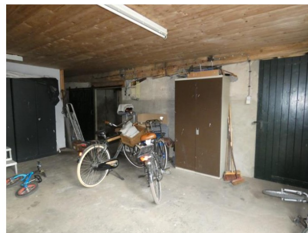
Afb. 108 Muur uit de jaren vijftig tussen de twee westelijke staltraveeën. De deur naar de voedergang is uitgevoerd als schuifdeur.
