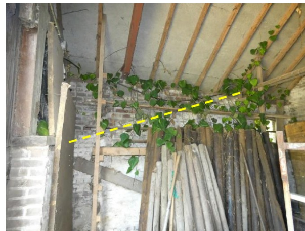
Afb. 206 Noordelijke gevel. De diagonale belijning in het muurwerk is duidelijk herkenbaar.
