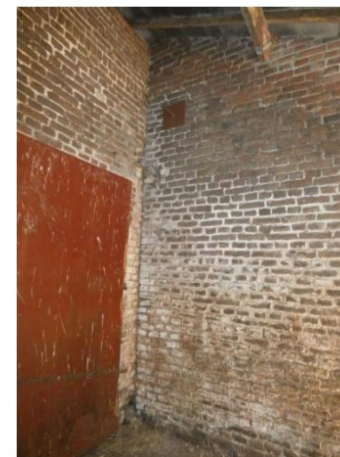
Afb. 151 Blinde westgevel. Aan de bovenzijde is aan het kleurverschil van de steen zichtbaar dat het volume is opgehoogd.
