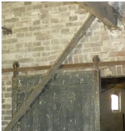
Afb. 204 Aanzet segmentboog boven schuifpoort.
