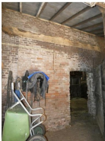
Afb. 112 Voormalige poortopening van de dwarsdeel, geplaatst onder zware eiken latei.
