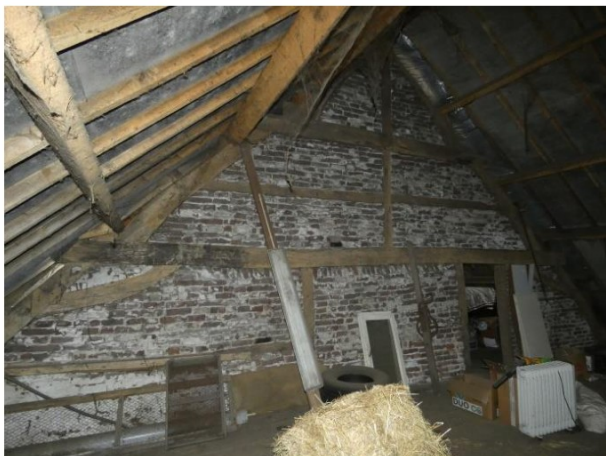
Afb. 52 Bakstenen wandvulling tussen de zoldering van de geut en de stal.
