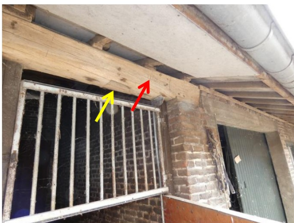
Afb. 157 Telmerk (rode pijl, III) en pengat (gele pijl) in de hergebruikte eiken dekbalk.
