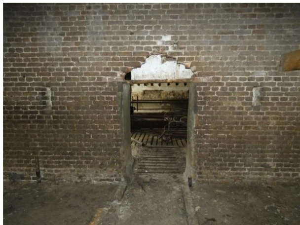
Afb. 119 Oorspronkelijke staldeur in het tweede travee (vanuit oosten gezien). De ontlastingsboog is weggefallen.
