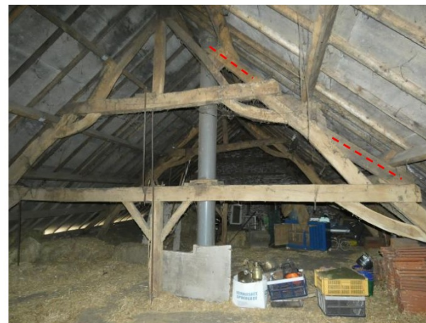
Afb. 58 Oostelijke spant. Aan de noordzijde voorzien van nieuwe balken ten behoeve van het uitlijnen van het dak.
