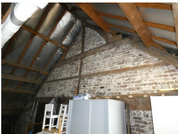
Afb. 100 Wand tussen geutzolder en hooizolder.
