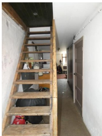
Afb. 95 Authentieke eikenhouten steektrap naar de zolder.
