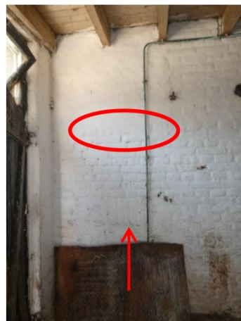
Afb. 36 Dichtgezet keldervenster en de rollaag van een dichtgezet opkamervenster.
