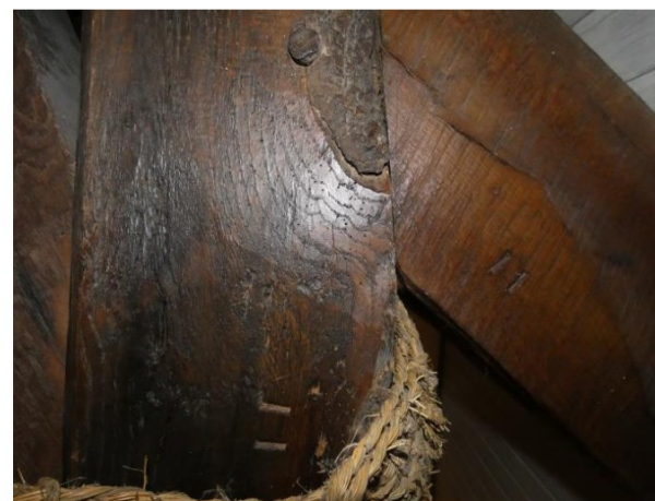
Afb. 54 Telmerken (II) in het tweede spant vanuit het oosten gezien.
