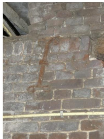
Afb. 113 Sieranker en kopse rollaag. Rechts de aanzet van de eikenhouten latei.
