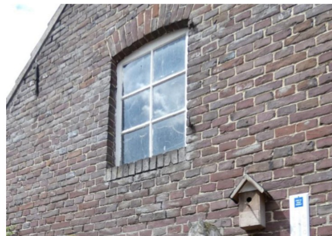
Afb. 185 Venster in de geveltop. Rechts van de gevelopeningen zijn de duimen van het oorspronkelijke luik nog aanwezig.
