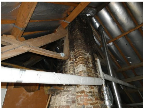
Afb. 99 Authentieke rookkanaal van de stookplaats in de keuken. Deze wordt aan beide zijden gestut door een half, verbeterd Hollands spant.
