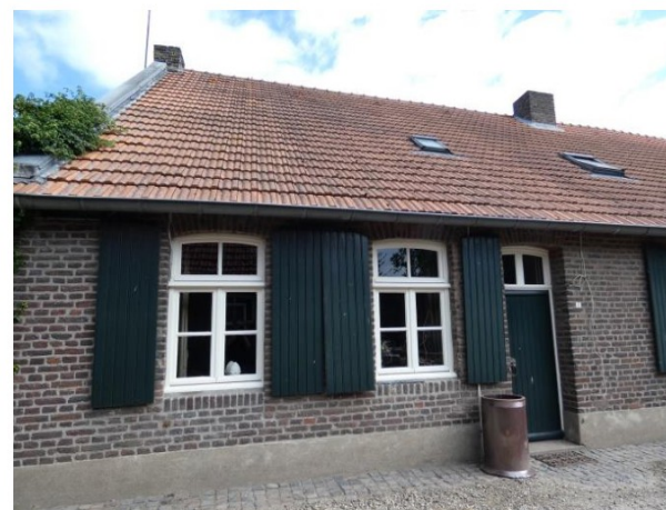
Afb. 16. Zuidgevel: linker gedeelte. .
