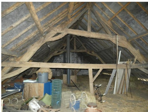
Afb. 222 Een van de achttiende-eeuwse eikenhouten spanten, met gestapelde jukken in het woonhuis.
