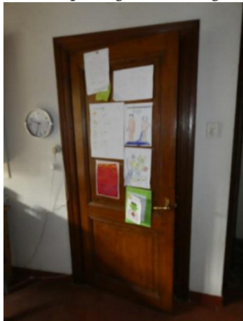
Afb. 246 Een van de vroeg-twintigste-eeuwse paneeldeuren en architraven: deur tussen gang en keuken.
