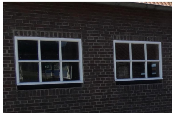
Afb. 43 De stalvensters zijn breder dan de onderliggende kopse rollagen.
