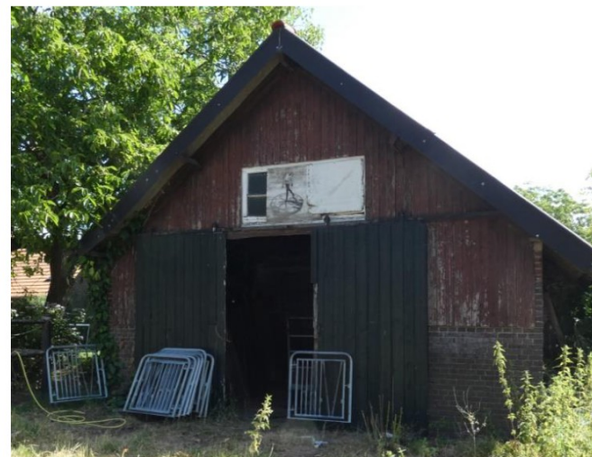
Afb. 191 Westgevel westelijke staluitbreiding: bakstenen basement van de oorspronkelijke stal onder lessenaardak. Opgehoogd met hergebruikt materiaal.
