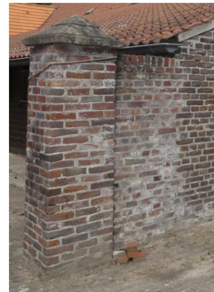
Afb. 153 Hekpijler en muurtje. Het 'oude' metselwerk loopt door tot de goot (zichtbaar aan de oostzijde), terwijl de zuidelijke gevel van de stal ruim een halve meter naar het noorden is geplaatst.
