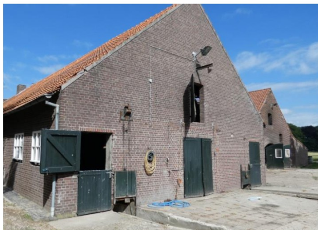
Afb. 25 Achtergevel van het volume uit 1910-1930.
