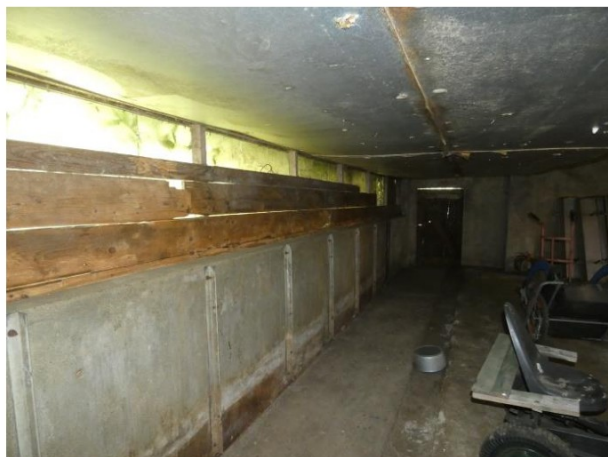
Afb. 195 Zuidelijke gevel stal, van binnenuit gezien.
