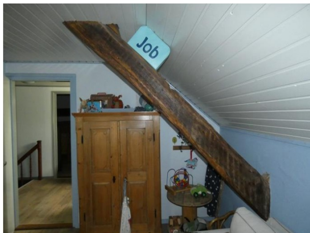
Afb. 60 Spantbeen van het westelijke spant. Dit spant heeft een andere opzet dan de overige vier exemplaren.
