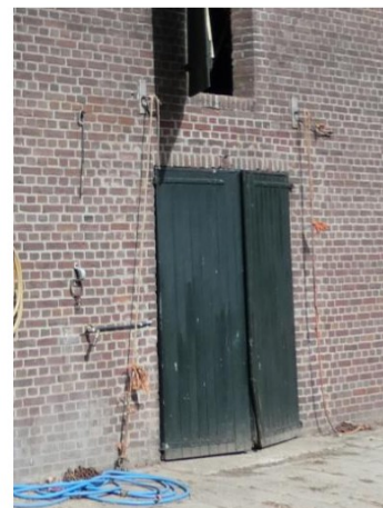
Afb. 26 De poort is aangepast, zoals zichtbaar is uit het metselwerk rondom de gevelopening.
