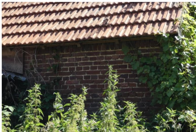
Afb. 190 Westgevel zuidoostelijk volume, met onder de dakoverstek een kopse rollaag.
