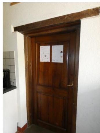
Afb. 80 Eiken deur, gevat in authentiek eiken kozijn en onder eiken latei, tussen keuken en geut.
