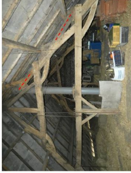
Afb. 58 Oostelijke spant. Aan de noordzijde voorzien van nieuwe balken ten behoeve van het uitlijnen van het dak.
