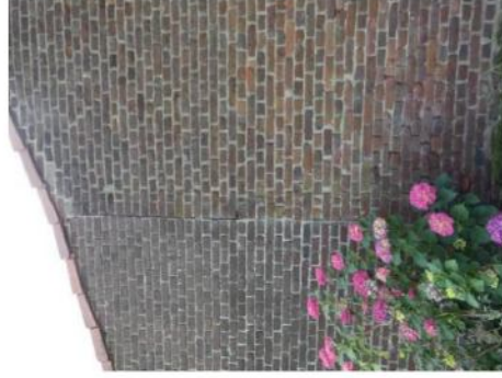
Afb. 122 Aansluiting van de aanbouw op de schuur. De gevel wordt afgesloten door een rij klezoren.
