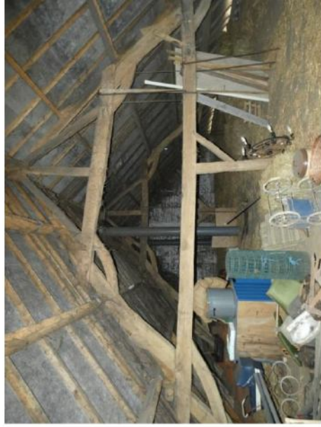
Afb. 56 De twee oostelijke spanten: zoldergebint, vlieringgebint en nokgebint.
