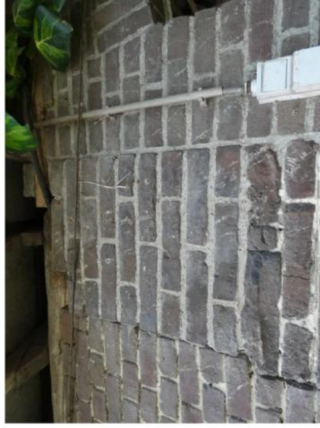
Afb. 182 Verschillende bakstenen: links de stal, rechts de westelijke stal (oorspronkelijk onder lessenaardak) in het midden de kopgevel met aan onderzijde veldbrandstenen.
