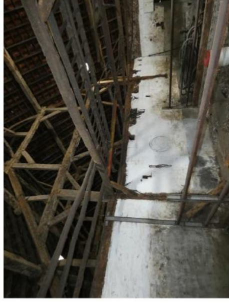
Afb. 134 Oorspronkelijke muur tussen voormalige tas en stal.
