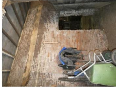
Afb. 112 Voormalige poortopening van de dwarsdeel, geplaatst onder zware eiken latei.
