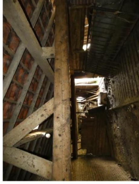
Afb. 161 Impressie van het interieur van de noordelijke aanbouw, gezien vanuit het oosten.
