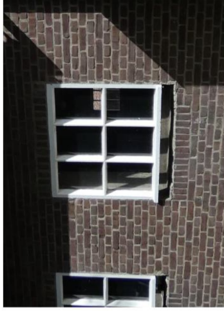
Afb. 24. Een van de betonvensters. De rollaag onder de vensters is smaller dan het venster.
