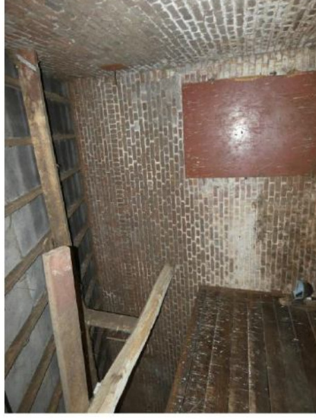
Afb. 115 Dichtgezette staldeur in het vierde travee (vanuit het westen gezien).
