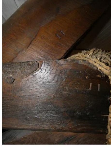
Afb. 54 Telmerken (III) in het tweede spant vanuit het oosten gezien.
