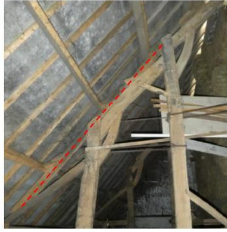
Afb. 57 Balk bovenop de spantbenen geplaatst ten behoeve van het uitlijnen van het dak.
