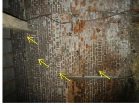
Afb. 139 Vier kopse rollagen in de zuidgevel, links van de dichtgezette bandeuren. Afb. 140 Vier kopse rollagen in de westgevel.
