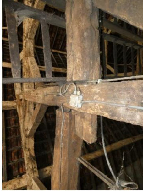
Afb. 145 Detail van de zuidelijke gebintstijl van het oostelijke spant.
