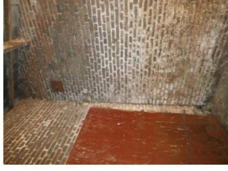
Afb. 151 Blinde westgevel. Aan de bovenzijde is aan het kleurverschil van de steen zichtbaar dat het volume is opgehoogd.
