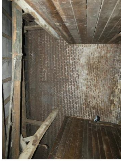
Afb. 156 Halfhoge houten wanden tussen de individuele stallen.
