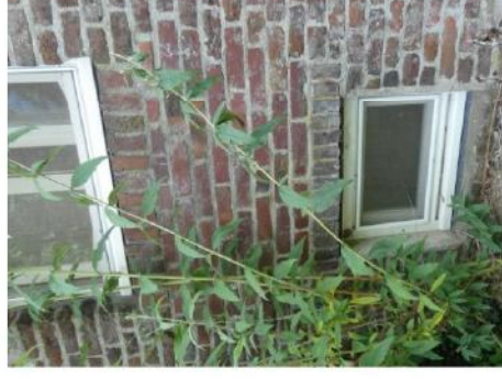
Afb. 11. Het metselwerk tussen beide vensters is vervangen.
