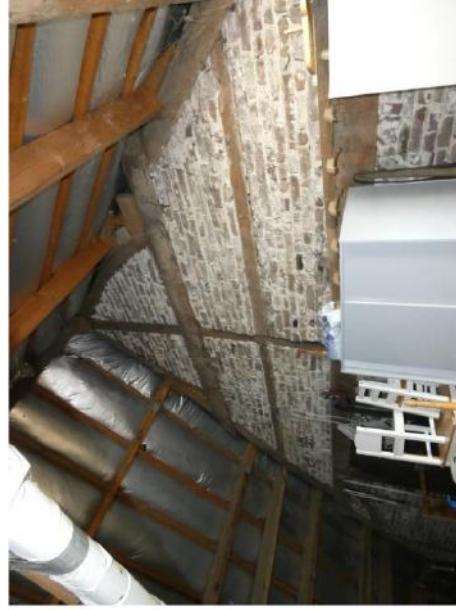
Afb. 100 Wand tussen geutzolder en hooizolder.
