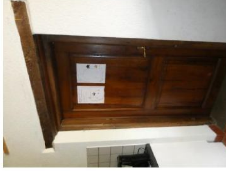
Afb. 80 Eiken deur, gevat in authentiek eiken kozijn en onder eiken latei, tussen keuken en geut.
