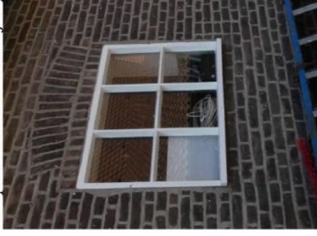
Afb. 40 Segmentboog boven het venster, rechts van de deur.
