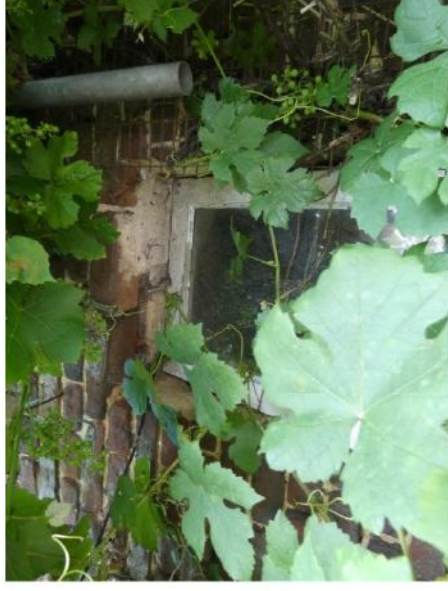
Afb. 193 Later geplaatst venster in de zuidelijke gevel van het zuidoostelijke volume.
