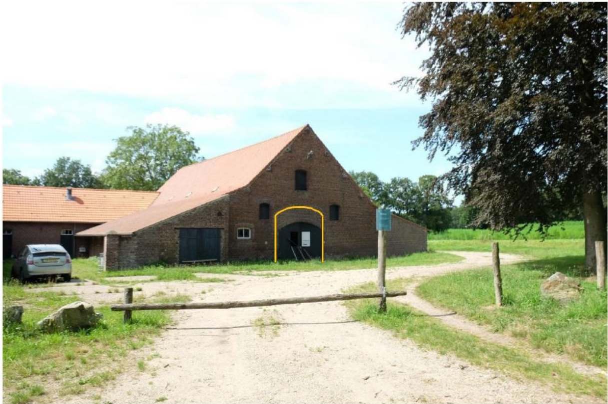
Het verwijderen van de aanbouwen tegen de oude schuur zorgt voor een duidelijkere structuur. De oostgevel wordt de hoofdentree voor de schuur, hiertoe worden de afmetingen van de toegang hersteld naar de historische situatie.
