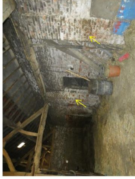
Afb. 137 Muurdammen aan weerszijde van de voormalige poortopening in de zijgevel.
