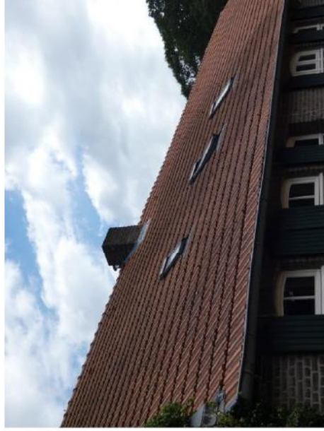
Afb. 3. Dak met muldenpannen. De schoorsteen hoort bij de oorspronkelijke stookplaats van de herd/keuken.
