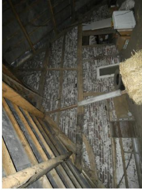
Afb. 52 Bakstenen wandvulling tussen de zoldering van de geut en de stal.
