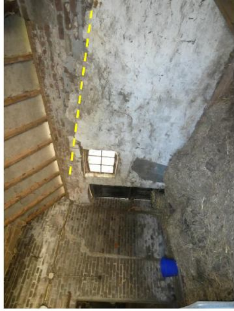
Afb. 205 Zuidelijke gevel. De diagonale belijning in het muurwerk is duidelijk herkenbaar.
