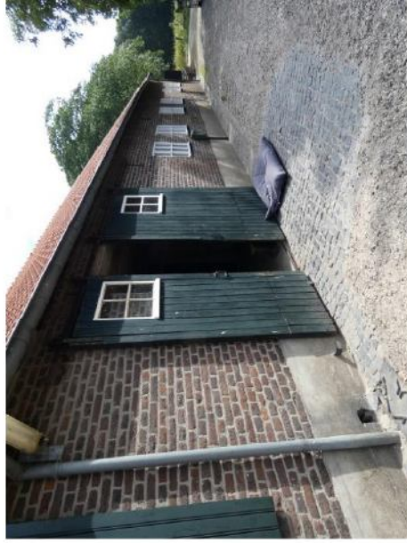
Afb. 20. Zuidgevel: overzicht stal.
