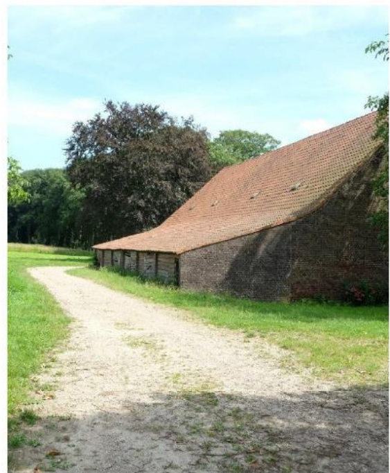
Aanbouw tegen oude schuur verwijderen
