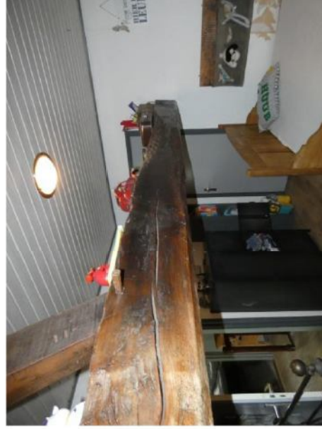
Afb. 97 Impressie oostelijke slaapkamer, met dwars door de ruimte de debalk van het spant.
