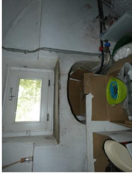
Afb. 62 Keldervenster uit circa 1900 in de westgevel. Hieronder een nagenoeg geveldikke nis.
