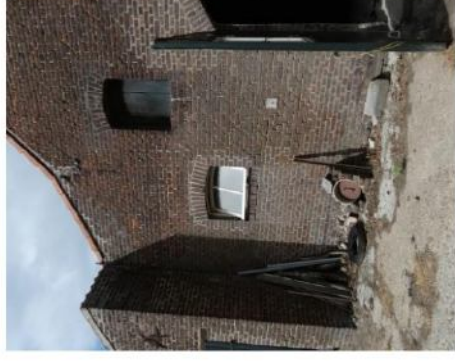
Afb. 129 De oorspronkelijke segmentboog (anderhalf streks) is aan de binnenzijde nog herkenbaar. De kruin bevindt zich 11 rijen onder het hooiluik.
