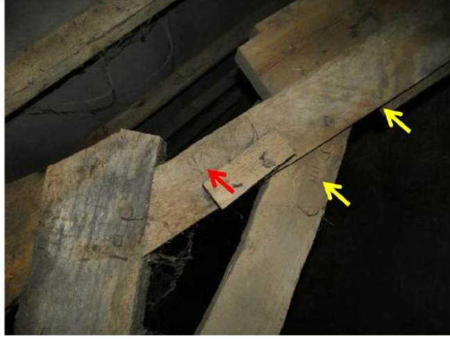
Afb. 55 Spant vier, zuidzijde. Zowel nummering IIII (geel) als VII (rood)
