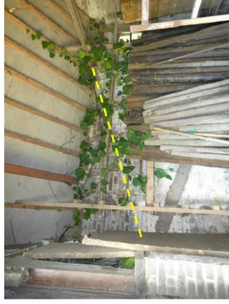
Afb. 206 Noordelijke gevel. De diagonale belijning in het muurwerk is duidelijk herkenbaar.
