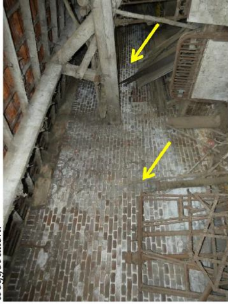
Afb. 119 Oorspronkelijke staldeur in het tweede travee (vanuit oosten gezien). De ontlastingsboog is weggevallen.
