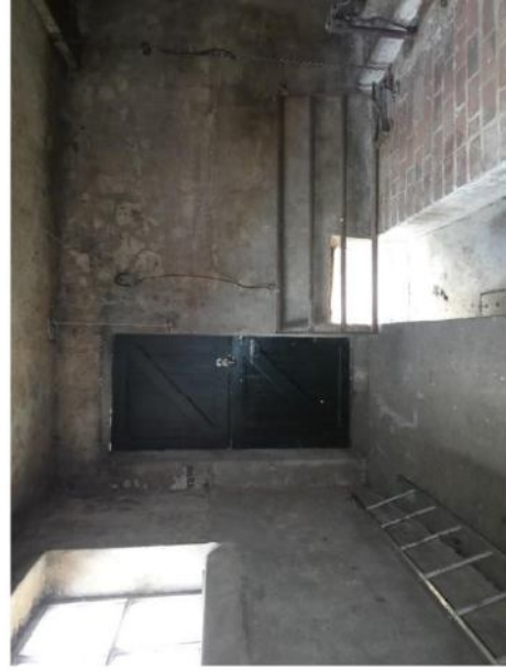
Afb. 106 Noordoost hoek met rechts de plavuizenvloer voor de koeien en in het midden de mestgoot.
