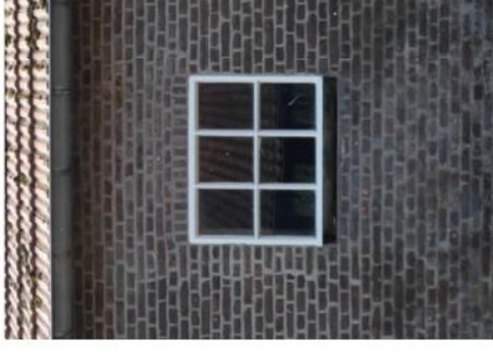
Afb. 41 Inboetwerk boven en links van het venster, links van de deur: sporen van een soortgelijk venster (ca 1900) als rechts.
