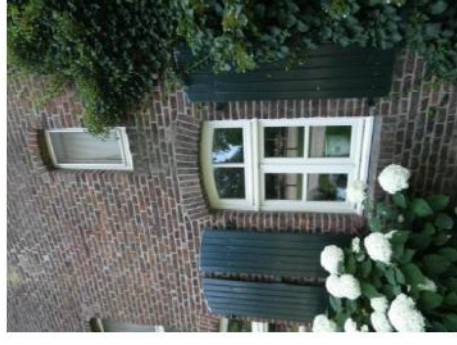
Afb. 9 Venster, circa 1900, geplaatst onder strekse segmentboog.
