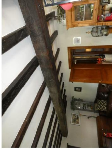
Afb. 66 Impressie van de goeikamer. De noordelijke zijde van de kinderbalken is rond 1900 vervangen door grenen exemplaren (vanaf derde balk van rechts op foto).
