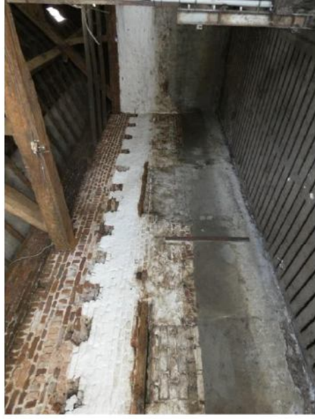
Afb. 117 Dichtgezette staldeur en stalvenster onder eiken latei, gezien vanuit de schuur.
