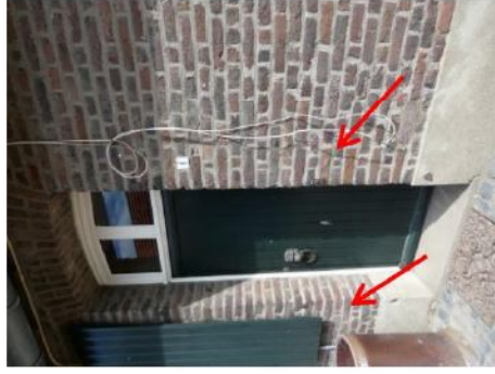
Afb. 18 Authentiek achttiende-eeuws venster onder segmentboog en met opvallende hardstenen lekdoorpel.
