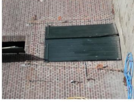
Afb. 26 De poort is aangepast, zoals zichtbaar is uit het metselwerk rondom de gevelopening.
