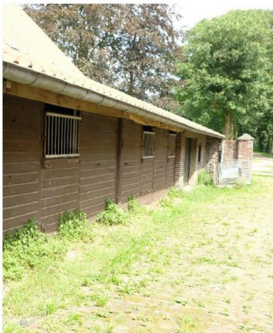
Verwijderen schuur zorgt voor zichtbaarheid monumentale schuur én aangename binnenplaats
