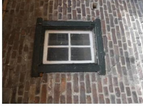
Afb. 150 Authentiek kozijn met sponning in de zuidgevel.
