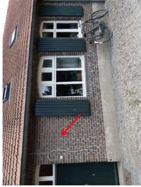
Afb. 17. Zuidgevel: voorhuis keuken en geut. De rode pijl geeft een rij klezoren weer (bouwspoor voormalig venster).
