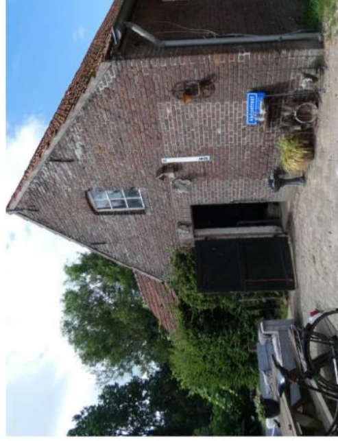
Afb. 183 Oostgevel van de stal.
