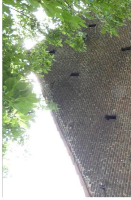
Afb. 125 Uilen- of duivengaten en haakvormige ankers.
