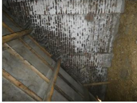
Afb. 30 Noordelijke gedeelte van de achtergevel van het hoofdvolume, met steunberen en vlechtwerk.
