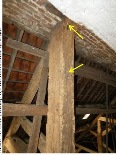
Afb. 148 Oplegging van de oostelijke (moer)balk met aan de onderzijde twee pengaten.
