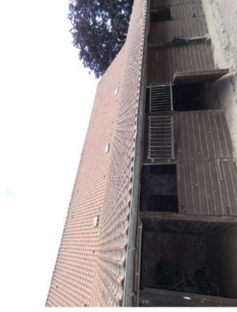
Afb. 154 Open schuur, later voorzien van rabatbeschoot en staldeuren.
