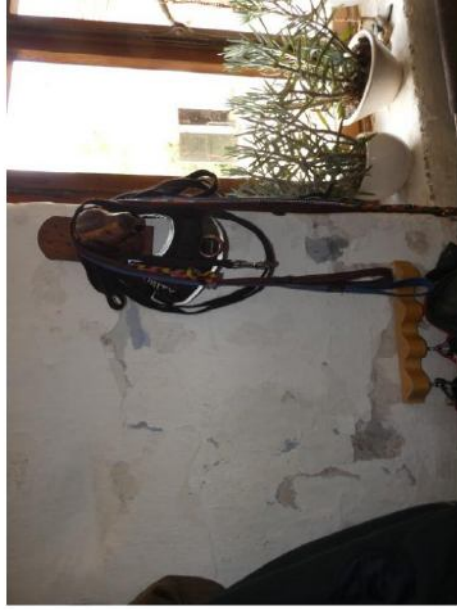
Afb. 88 Sporen van blauwswel onder de witte verflaag: zuidelijke muur.
