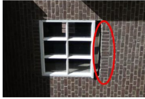
Afb. 243 Venster bij de uitbreiding van de stal van de boerderij. Onder de betonramen zit en rollaag met vijftien koppen.
