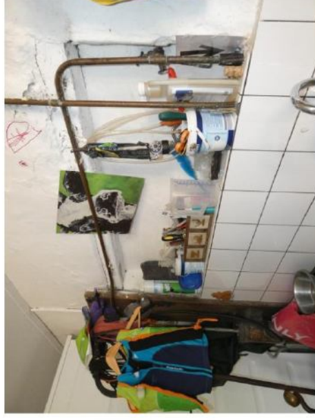
Afb. 91 Nis tussen geut en stal. Onderste gedeelte is dichtgezet en betegeld.
