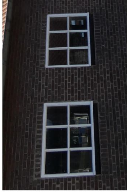
Afb. 43 De stalvensters zijn breder dan de onderliggende kopse rollagen.
