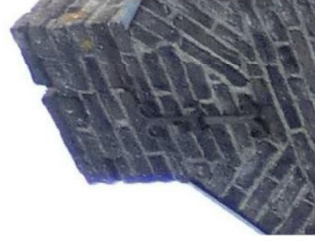
Afb. 13 Krulanker in de geveltop.
