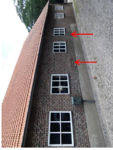
Afb. 22. Betonvensters uit de jaren vijftig-zestig. De rode pijlen geven de locatie van inboetwerk weer.
