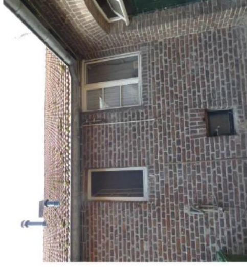
Afb. 33 Middenboven een authentiek opkamerervenster. Midden onder een authentiek keldervenster. Het venster rechtsboven is na de bouw van het koppelstuk aangebracht.
