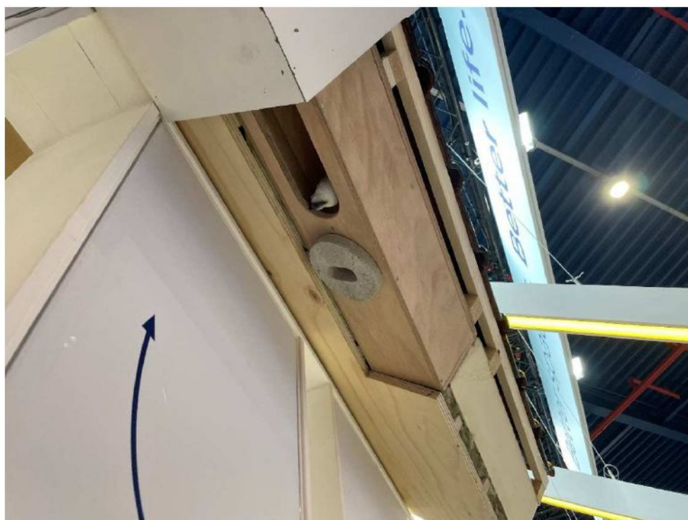
Nestkast maken in de dakconstructie
