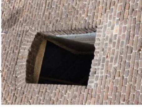
Afb. 129 De oorspronkelijke segmentboog (anderhalf streks) is aan de binnenzijde nog herkenbaar. De kruin bevindt zich 11 rijen onder het hooiluik.
