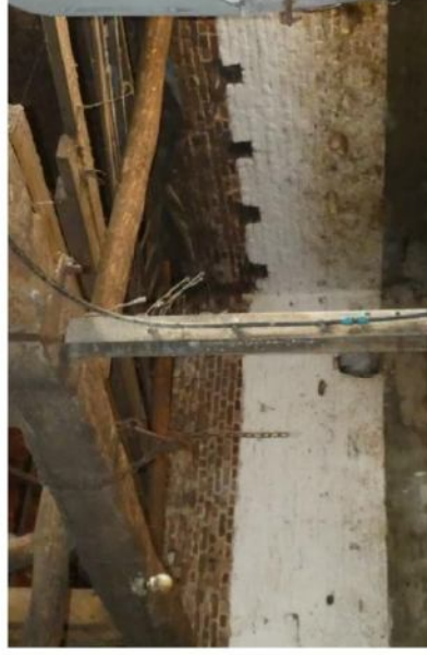
Afb. 136 Balkgaten in de oostelijke gevel, boven de noordelijke stal.
