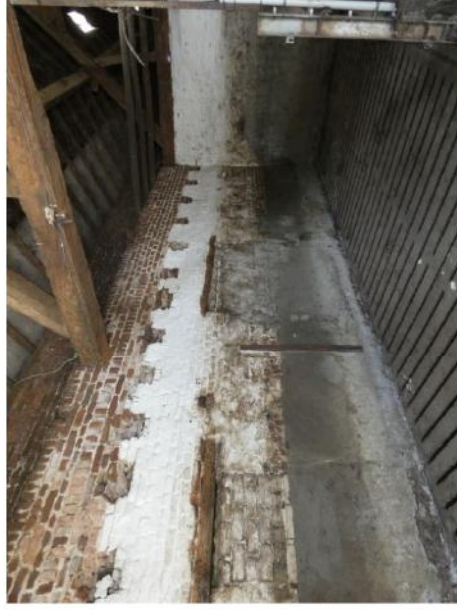
Afb. 135 Balkgaten van een voormalige slietenzolder boven de zuidelijke zijbeuk.
