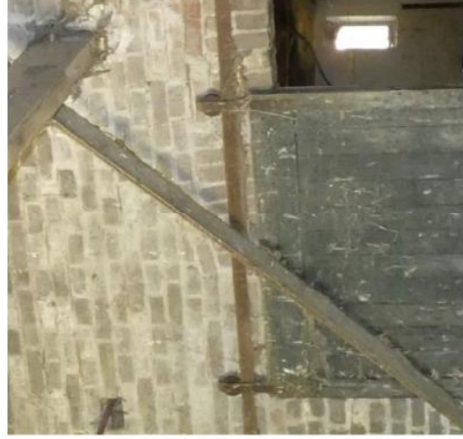
Afb. 204 Aanzet segmentboog boven schuifpoort.
