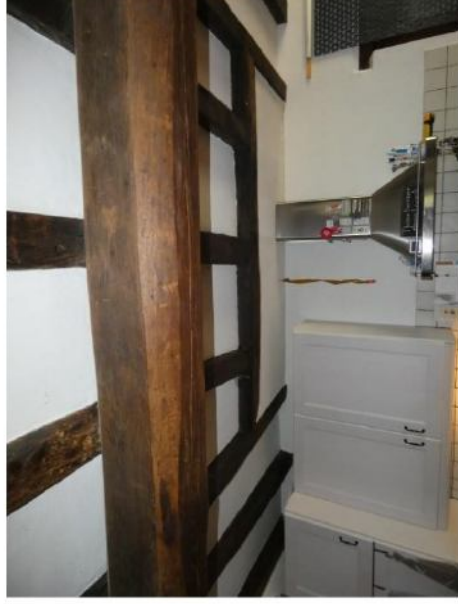
Afb. 75 De moerbalk en de raveling van de oorspronkelijke stookplaats.
