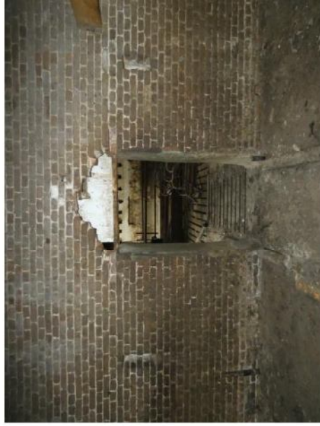
Afb. 119 Oorspronkelijke staldeur in het tweede travee (vanuit oosten gezien). De ontlastingsboog is weggevallen.
