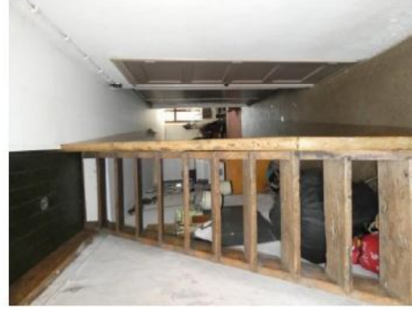
Afb. 95 Authentieke eikenhouten steektrap naar de zolder.
