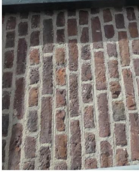
Afb. 5 Grove, gemêleerde veldbrandsteen (groot formaat), voeg deels voorzien van dagstreep.
