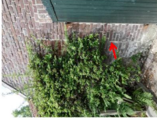
Afb. 187 Verticale bouwnaad: overgang van ouder zuidoostelijk volume naar stal uit 1910-1930.
