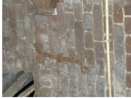
Afb. 113 Sieranker en kopse rollaag. Rechts de aanzet van de eikenhouten latei.
