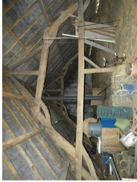
Afb. 222 Een van de achttiende-eeuwse eikenhouten spanten, met gestapelde jukken in het woonhuis.
