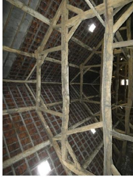
Afb. 142 Westelijke gebint. Rechts de oversteek van de dekbalk. Links steekt de balk door in de stijl.
