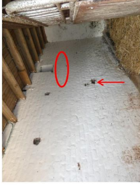
Afb. 34 Inpandig gelegen geveldeel van het voorhuis. De rode pijl wijst een hanenkam van een keldervenster aan (zie ook afb. 35), de rode ovaal omkadert een kopse rollaag van een opkamerervenster.
