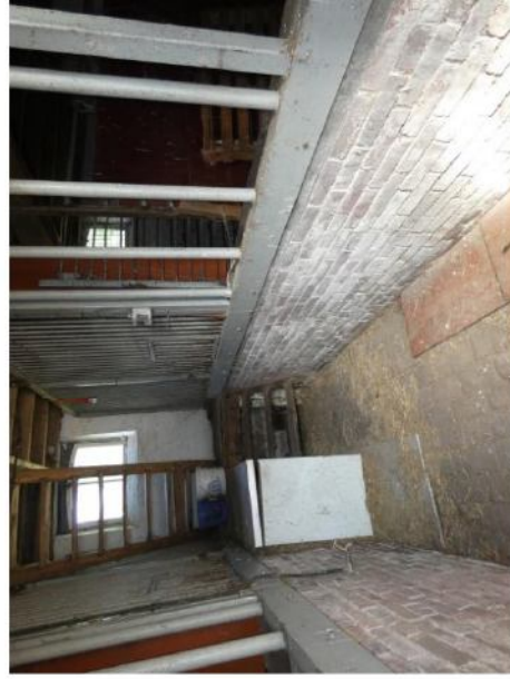
Afb. 169 De voergang, met authentieke bakstenen muurtjes. De kei-formaat klinkers zijn niet authentiek, echter wel karakteristiek.
