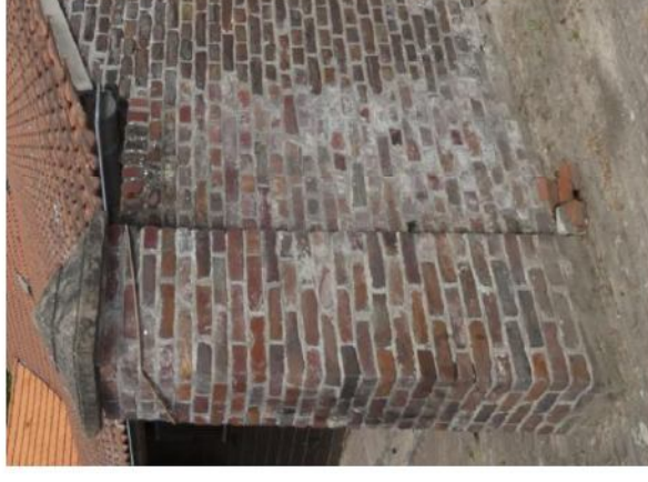
Afb. 153 Hekpijler en muurtje. Het 'oude' metselwerk loopt door tot de goot (zichtbaar aan de oostzijde), terwijl de zuidelijke gevel van de stal ruim een halve meter naar het noorden is geplaatst.
