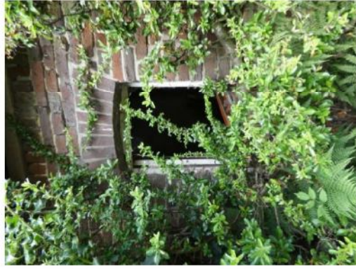
Afb. 186 Getoogd venster onder hanenkam en rollaag ter afsluiting van de gevel.
