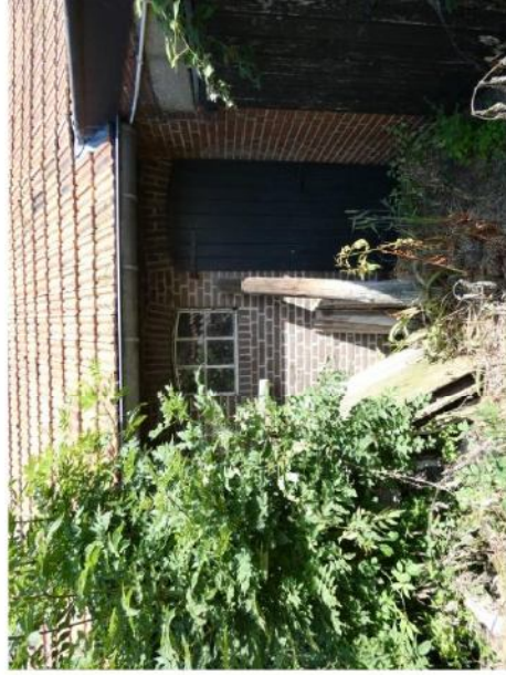
Afb. 196 Zuidelijke gevel van de westelijke stal: staldeur en -venster onder segmentboog.
