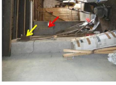
Afb. 200 Westelijke wand. De rode pijl wijst de noordelijke gevel van het zuidoost volume aan. D gele pijl het I-profiel.
