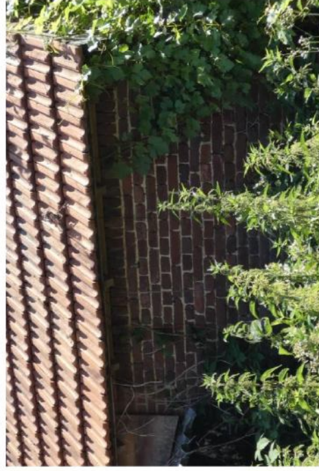
Afb. 190 Westgevel zuidoostelijk volume, met onder de dakoverstek een kopse rollaag.
