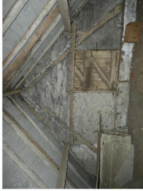
Afb. 176 Noordelijk spant, met baksteenvulling en luik: verbinding met de grote schuur.
