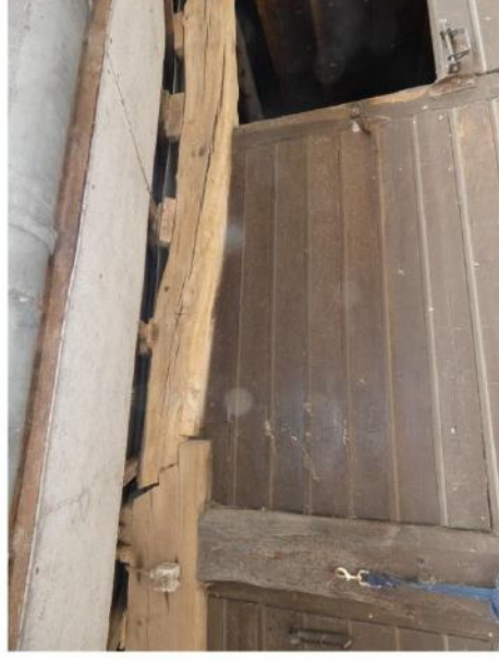
Afb. 155 Hergebruikt materiaal: links een grenen dekbalk, rechts een eiken dekbalk, beide via een lasverbinding gekoppeld.
