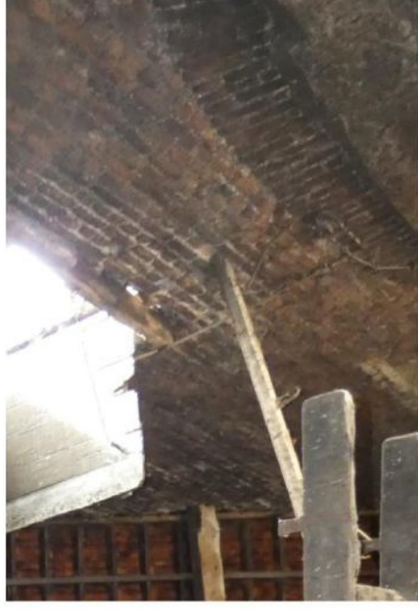
Afb. 129 De oorspronkelijke segmentboog (anderhalf streks) is aan de binnenzijde nog herkenbaar. De kruin bevindt zich 11 rijen onder het hooiluik.
