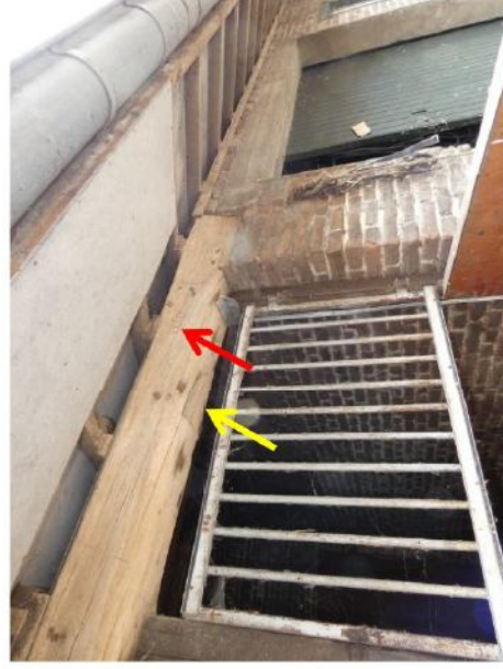
Afb. 157 Telmerk (rode pijl, III) en pengat (gele pijl) in de hergebruikte eiken dekbalk.
