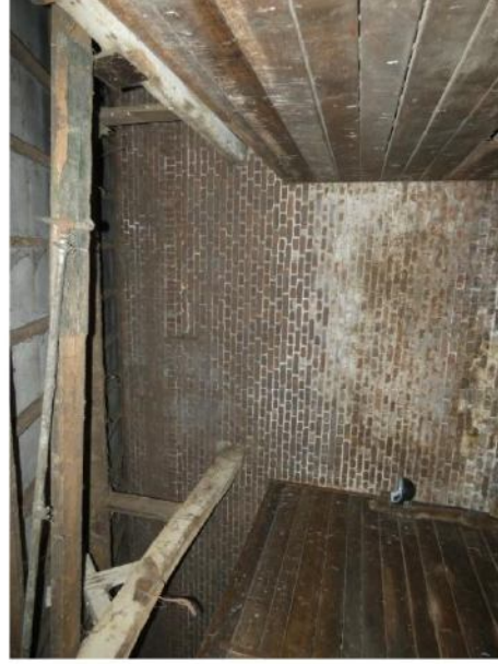
Afb. 114 Blind muurlak, aan de bovenzijde afgesloten door een kopse rollaag. Hierboven is in de loop van de twintigste eeuw de gevel opgehoogd.
