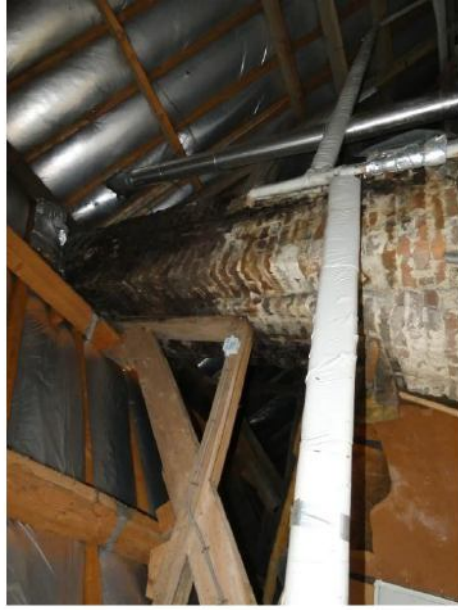
Afb. 99 Authentieke rookkanaal van de stookplaats in de keuken. Deze wordt aan beide zijden gestut door een half, verbeterd Hollands spant.
