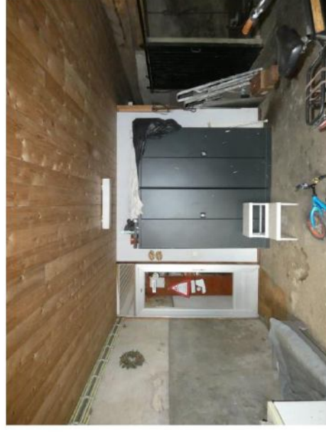
Afb. 107 Impressie van het westelijke travee, waar in e en later stadium (laatste kwart 20 e eeuw) een kantoor is afgeschoten.
