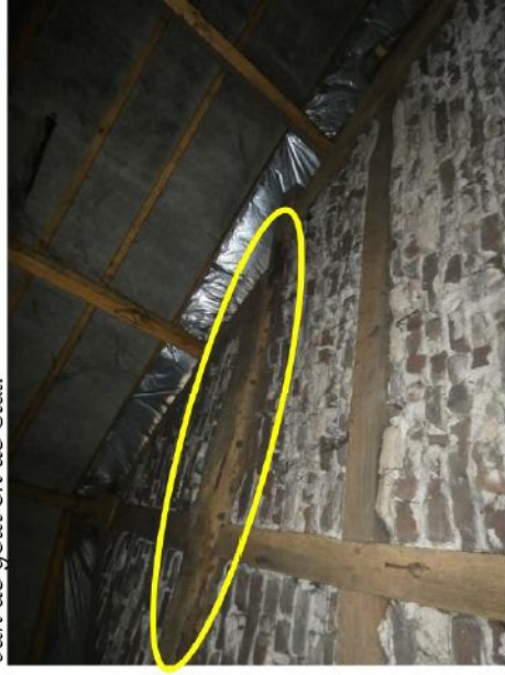
Afb. 53 Staakgaten aan de onderzijde van de dekbalk van het vlieringgebint: sporen van een voormalige lemen wand.
