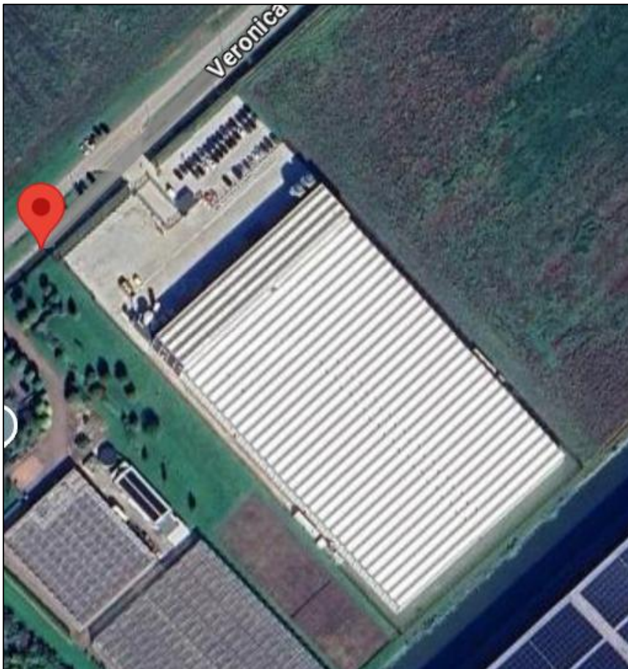
Afbeelding: luchtfoto locatie Veronica 5 Bommel (dak-doorvoeren zichtbaar)
