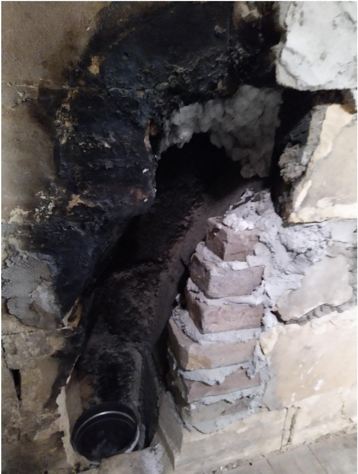
Beëindiging RVS flexibele kachelpijp in bestaand rookkanaal ter hoogte zoldervloer
