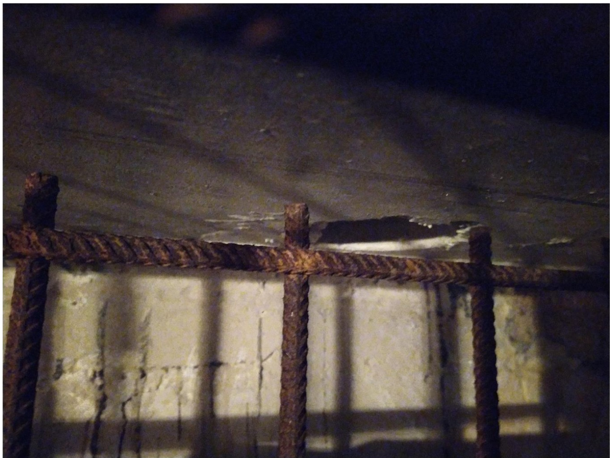
Boring kelderdek t.b.v. luchttoevoer houtkachel vanuit kelder
