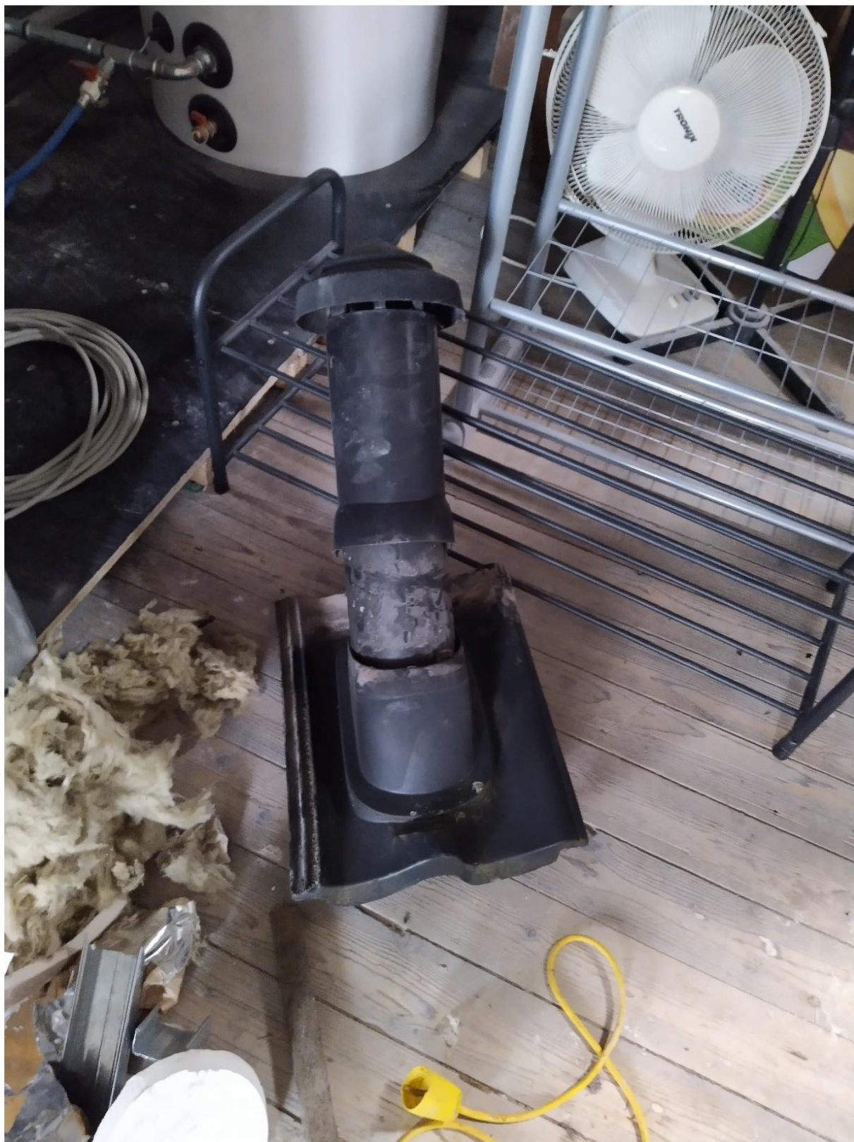
Verwijderde bestaande kunststof doorvoerbuis / afdekkap
