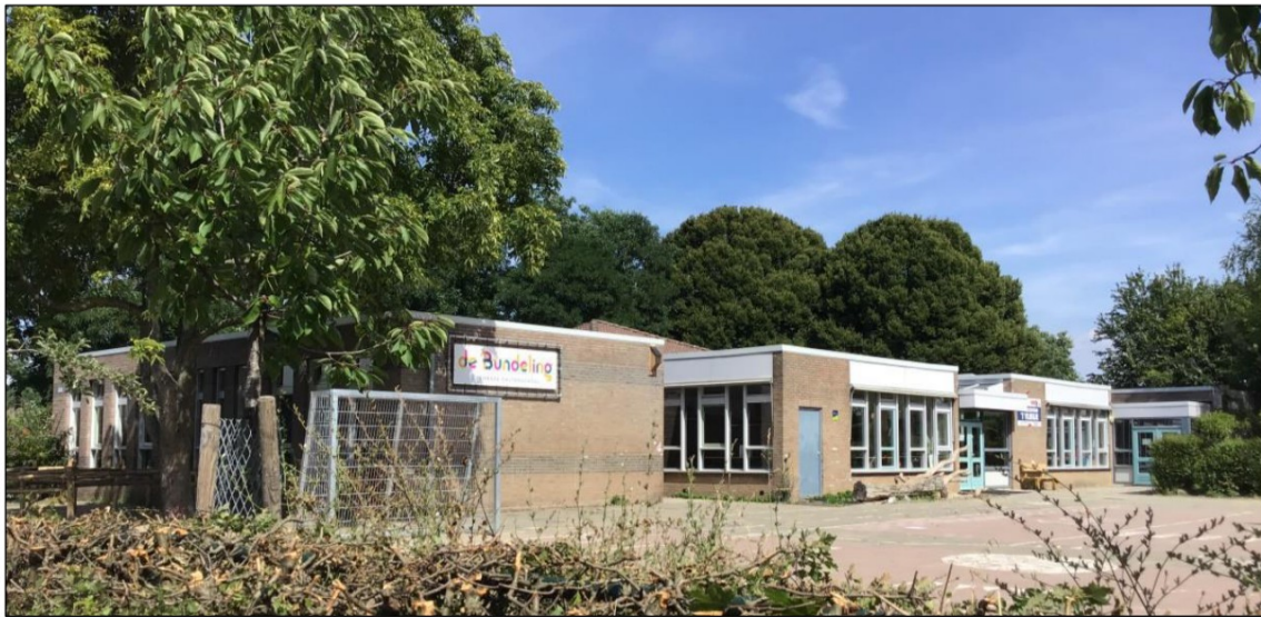
Figuur 2-2 ODS de Bundeling met zicht op speelterrein, hoofdentree en zijentree
