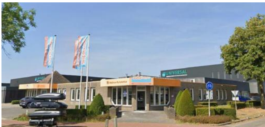
Afbeelding 1 : Overzichtsfoto locatie vanuit zuidoostelijke richting [bron: Google Street View augustus 2025]
