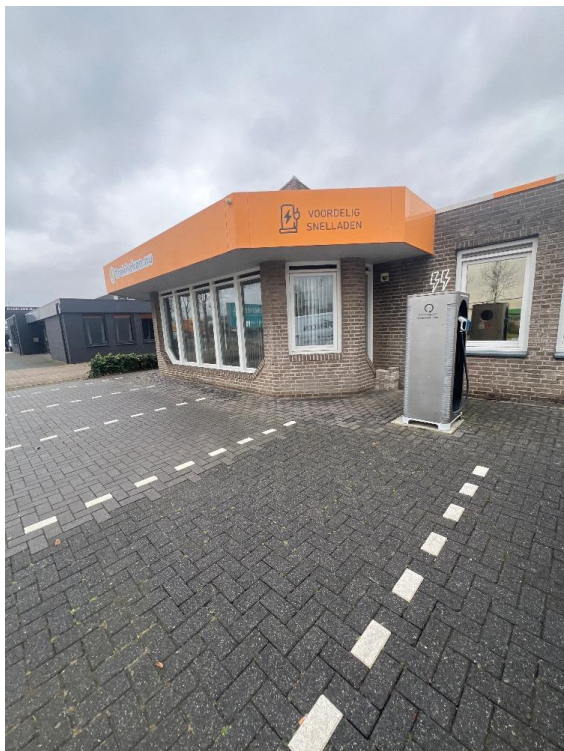
Afbeelding 14: zuidzijde locatie, vanuit (zuid)oostelijke richting [15-1-2026]
