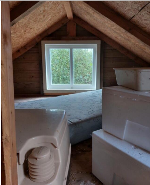
Figuur 2. Matras en chemisch toilet op zolder.
