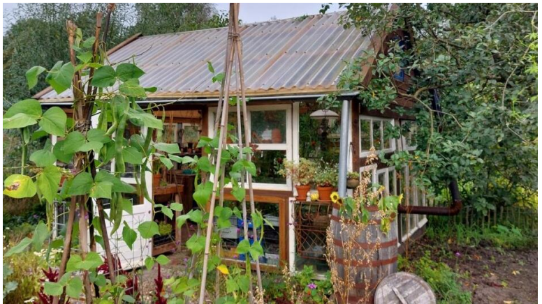
Figuur 14. Bouwwerk 6, plantenkas begaanbaar en in gebruik.
