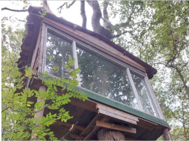
Figuur 30. Bovenzijde boomhut (20) achterzijde.
