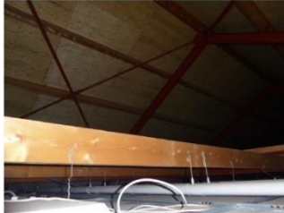
Foto 37: Foto project houten dakbeschot
