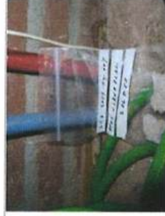
Foto 18 | vlakke plaat verkenningsschot
