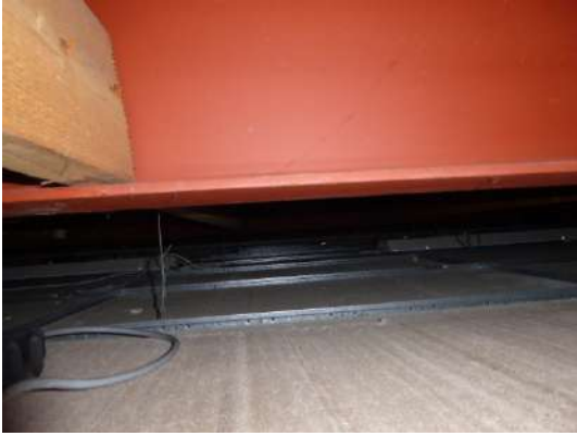
Foto 38: Foto project staal constructie niet omkleed
