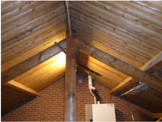
Foto 24 | vlakke plaat varkensschot
