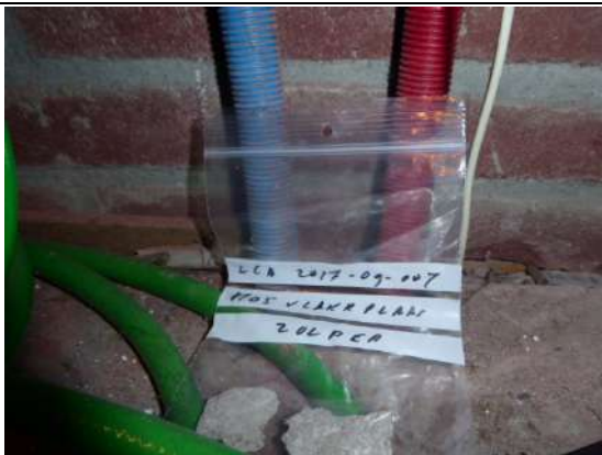
Foto 18 | vlakke plaat varkensschot
