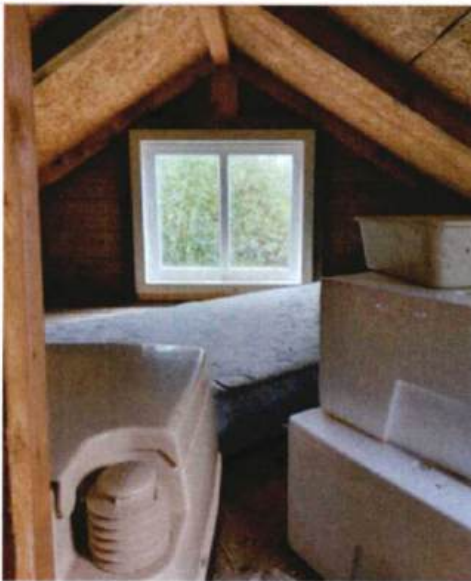
Figuur 2. Matras en chemisch toilet op zolder.
