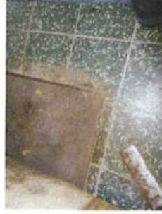
Foto 39: Foto project houten dakbalk watermeter.
