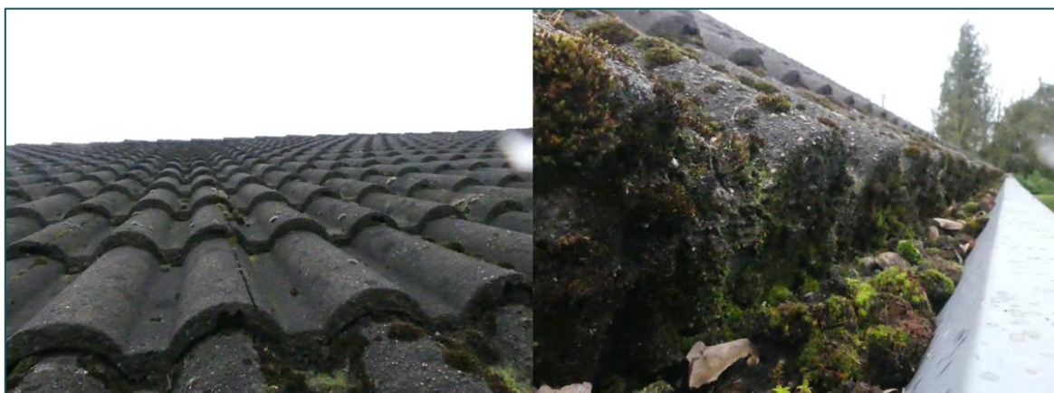
Figuur 3.1 De dakpannen sluiten strak aan en zijn niet toegankelijk voor huismussen.
