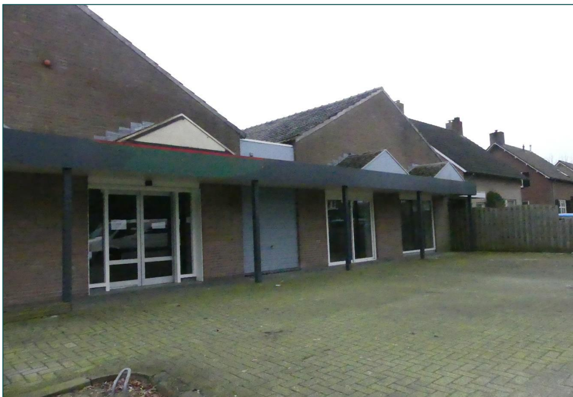
Figuur 1 De planlocatie is gelegen aan de Van den Elsenstraat 36 te Breugel en bestaat uit een bedrijfspand en een groenstrook. De beoogde ruimtelijke ingreep betreft de sloop van de bebouwing ten behoeve van nieuwbouw.
