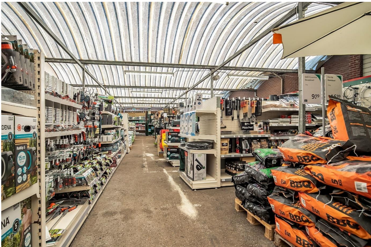
Asfalt vloer en golfplaten dak zonder isolatie.
