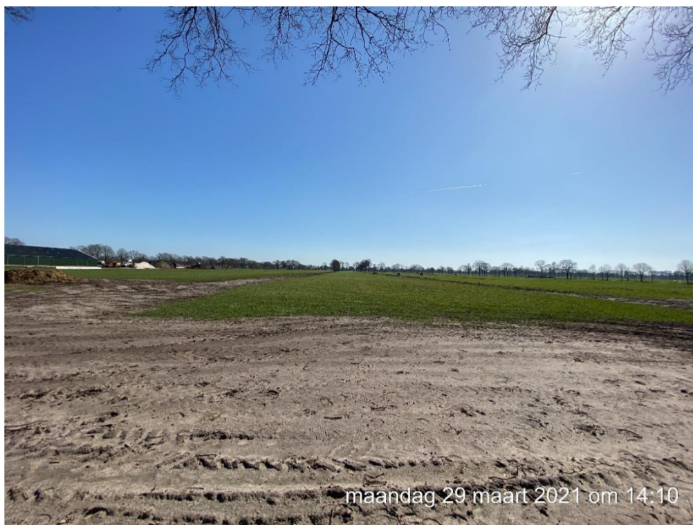
Foto 6: de gedempte sloten op het perceel, sloot 1 en 2.
