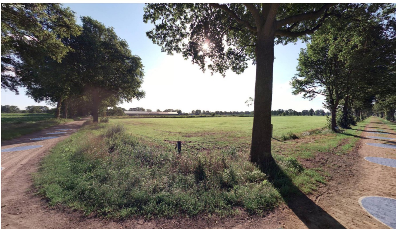
Afbeelding 2.6: StreetView d.d. 20-07-2020. De bermsloot gezien vanaf de T-splitsing Bron: Street Smart, by Cyclomedia
