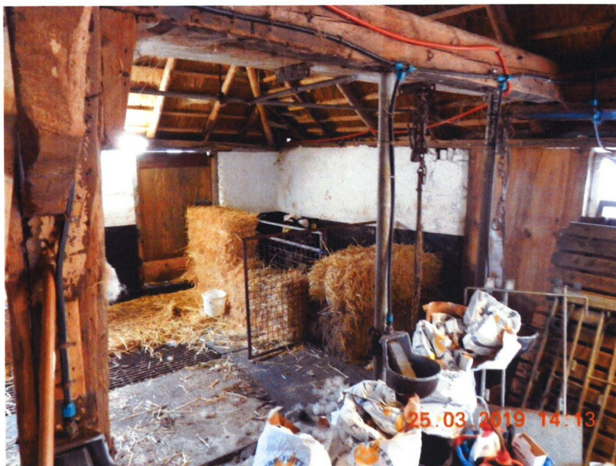
Foto 5: Gedeelte van de stal in het achterhuis van de woning. Locatie van de foto; [redacted] te Staphorst.
