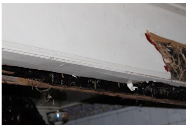
Afb.44 Detail omtimmering ankerbalken met ojiefprofiel.
