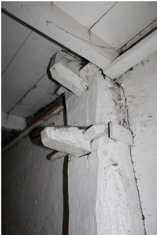
Afb.29 Het deel van de ankerbalk die doorsteekt door de stijl en in de gang zichtbaar is. Het lijkt te gaan om een gevorkt worteleind.
