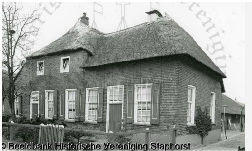
Afb.15 Situatie voorgevel in 1992. De twee kleine vensters op zolderniveau zijn ook vernieuwd tussen 1980 en 1992. Verder valt de houten schoorsteen op boven de aanbouw. Deze was eerst in baksteen opgetrokken.
