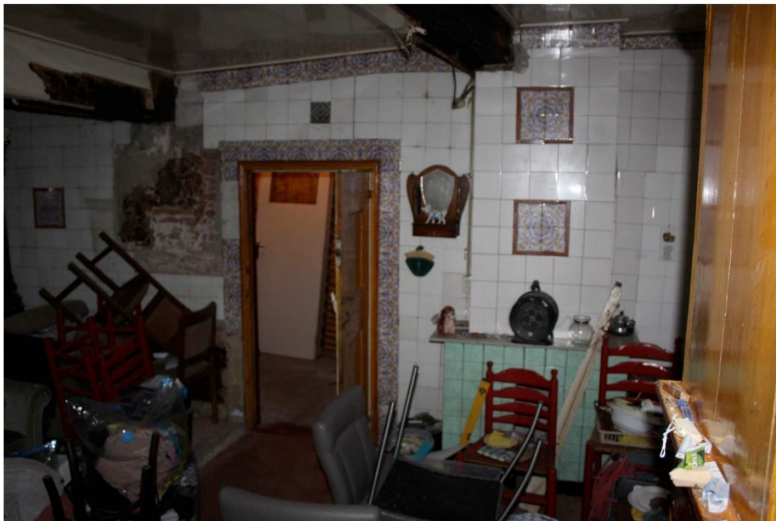
Afb.43 Rechterzijde ruimte D met de deur naar ruimte c en rechts daarvan de schouw.
