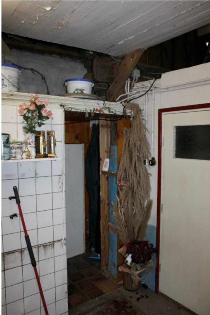
Afb.30 Centraal op de foto de linkerstijl van het derde gebint. Het geheel is deels aan het zicht onttrokken door aftimmeringen.
