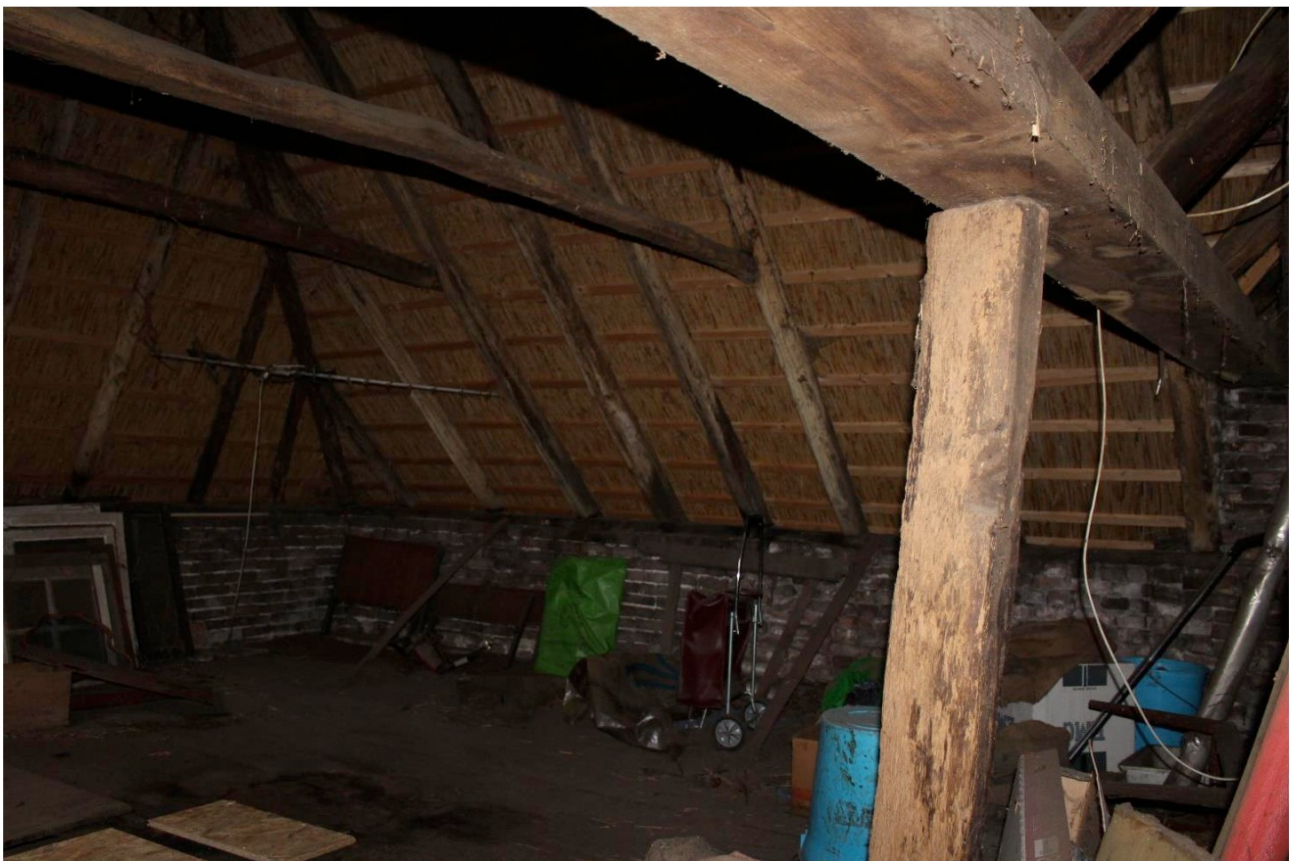
Afb.65 De zolder boven de aanbouw met de oorspronkelijke vloer, borstwering en sparrenkap.
