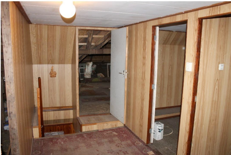
Afb.64 Interieur kamer/overloop C met links de trapopgang, daarnaast de deur naar zolder D en uiterst rechts de twee toegangsdeuren tot kamer B en A.
