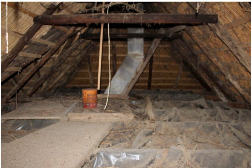
Afb.31 Bovenste deel kap hoofdhuis met sparren, hanebalken en het rookkanaal van de schouw in de centrale kamer (D).
