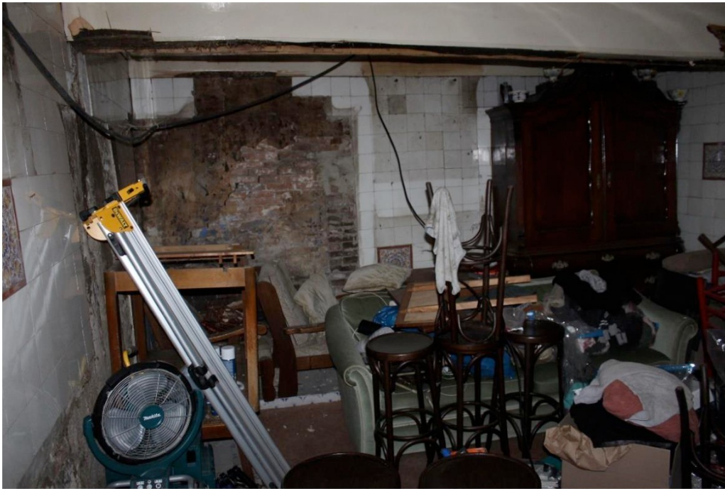
Afb.46 Zicht op de achterwand van ruimte D. Links de contouren van een ontbrekende kast waaromheen is getegeld en rechts nog een overgebleven kast.
