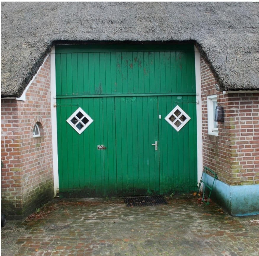
Afb.22 Baanderdeuren links met aan de linkerzijde het kleine gedeelte 'achtergevel' met venster.
