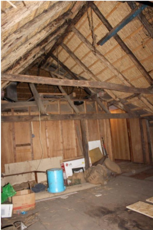
Afb.32 Kapconstructie aanbouw met lagere hanebalken en zicht op de doorlopende gebintplaat van het hoofdhuis met de sparren daar nog op uit de oudere situatie van vóór 1893.
