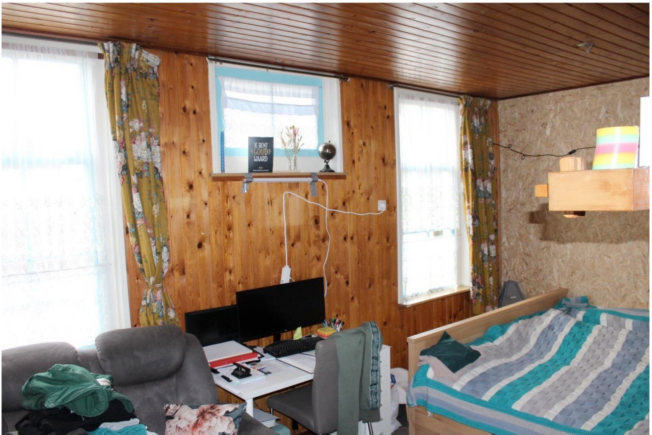
Afb.40 Interieur woonkamer. In het midden het bovenlicht van de oorspronkelijke toegangsdeur in de voorgevel.
