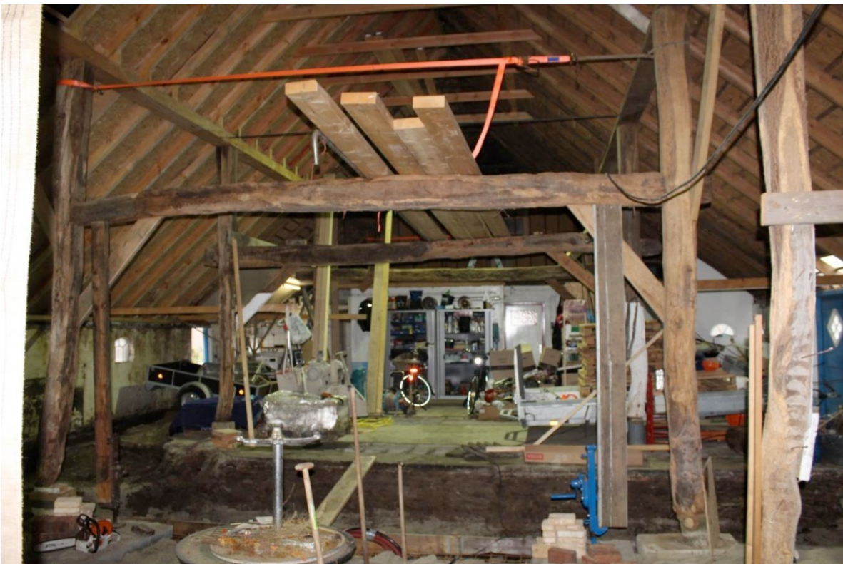
Afb.68 De deel gezien van achteren naar voren met rechts vooraan op de foto de stijl zonder ankerbalk (gebint 4 op de plattegrond in bijlage 1.)
