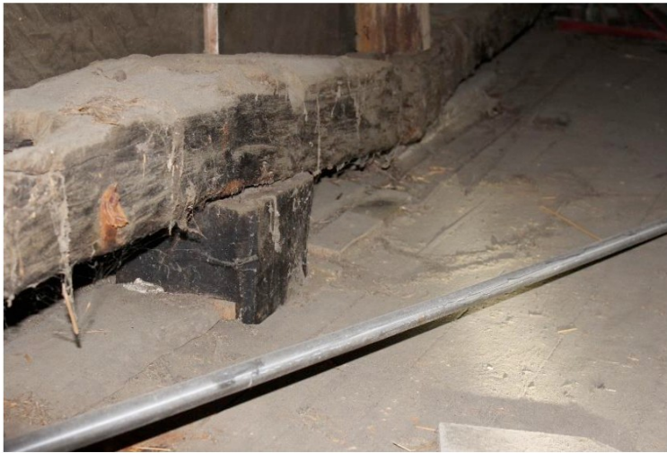
Afb.26 Situatie op zolder bij de afgezaagde gebintstijl van het voorste gebint linkerzijde. Nog net te zien de onderzijde van de steun onder de gebintplaat op de gebroken eiken balk.
