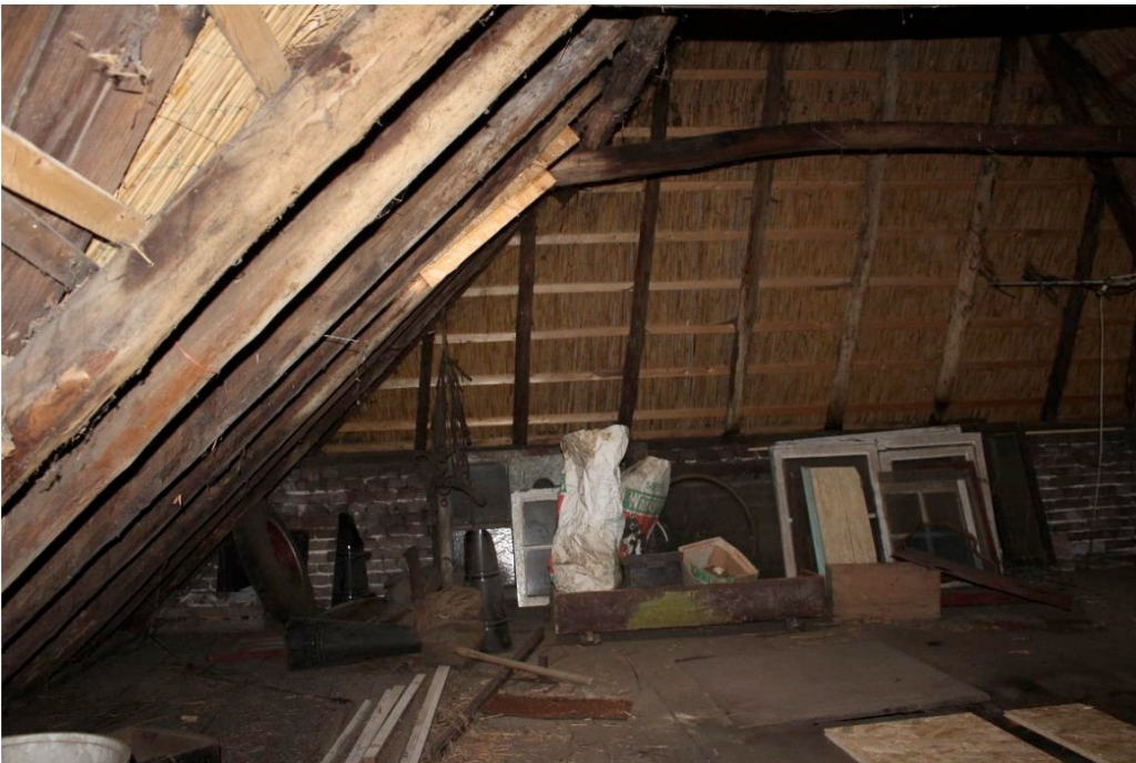
Afb.33 Kap met zolder en borstwering boven de aanbouw.
