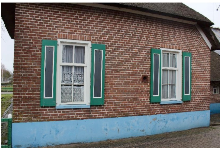
Afb. 16 Zijgevel rechterzijde aanbouw.
