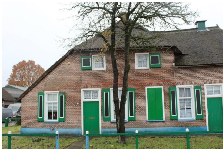
Afb.12 Voorgevel met globale aanduiding oudste metselwerk onder de rode lijn.
