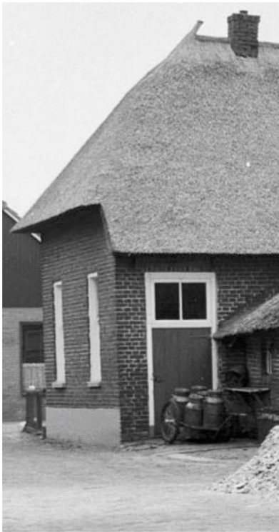
Afb.20 Achtergevel aanbouw in 1980.
