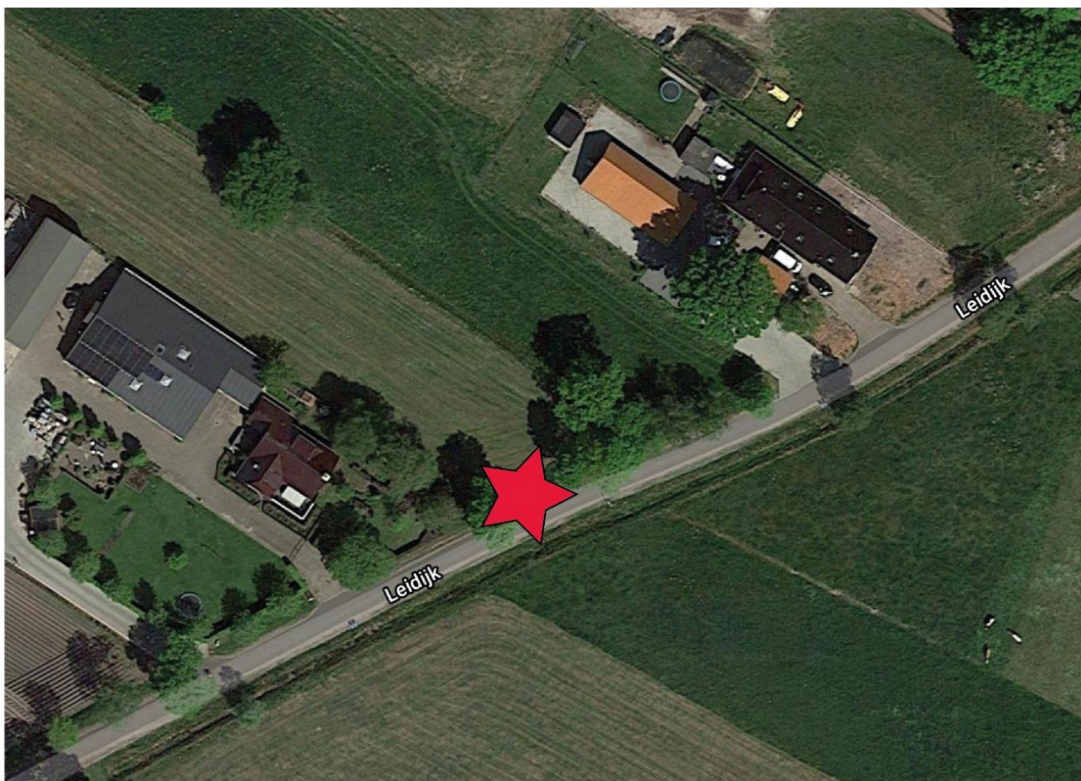
Figuur 9: Locatie transformatorhuisje
