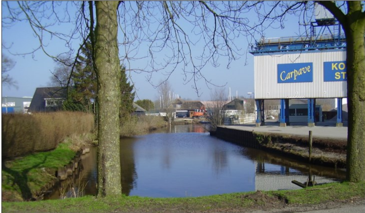
Afbeelding 2: Te dempen deel van de insteekhaven
