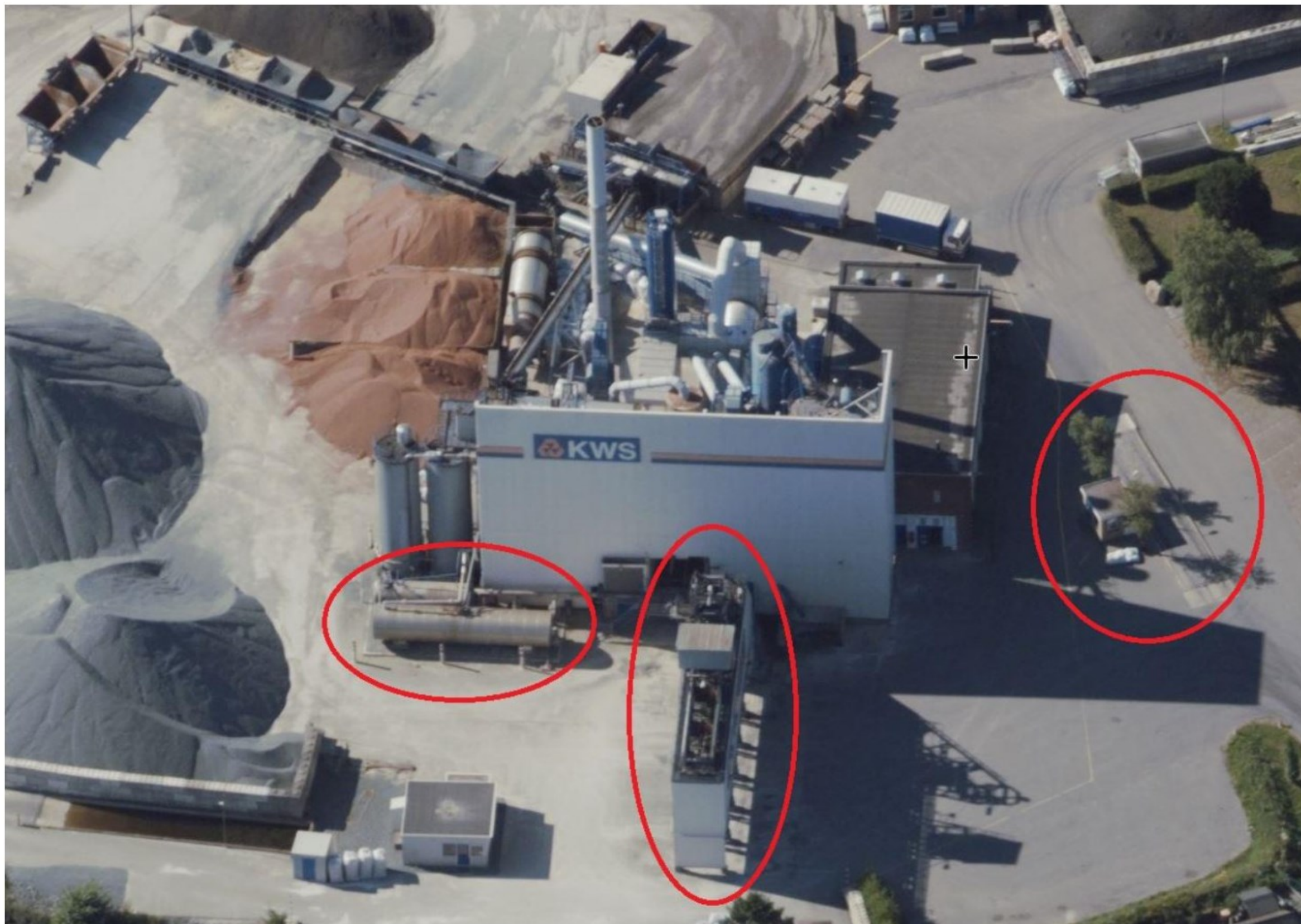
Afbeelding 1.4: bestaande aanzicht (van links naar rechts: bitumentanks, eindsilo's en weeghuisje)
