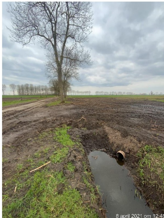
Foto 1 en 2: De gedempte bermsloot over een lengte van ca. 50 meter. Er is geen duiker toegepast.
