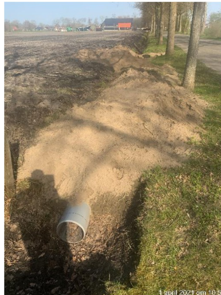
Foto 4: Er is een dam/duiker aangebracht, en een demping in de bermsloot, nabij [REDACTED]
