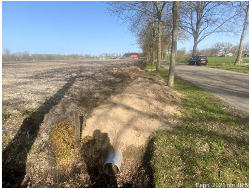
Foto 3: Er is een dam/duiker aangebracht, en een demping in de bermsloot, nabij [REDACTED]
