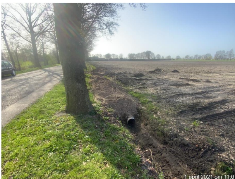
Foto 1: Er is een dam/duiker aangebracht, en een demping in de bermsloot, nabij
