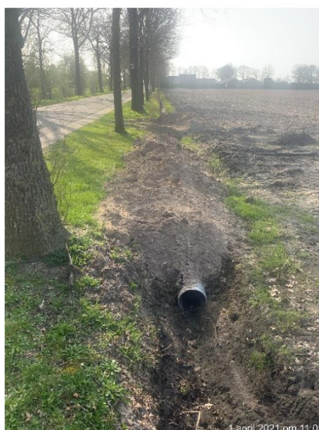
Foto 2: Er is een dam/duiker aangebracht, en een demping in de bermsloot, nabij
