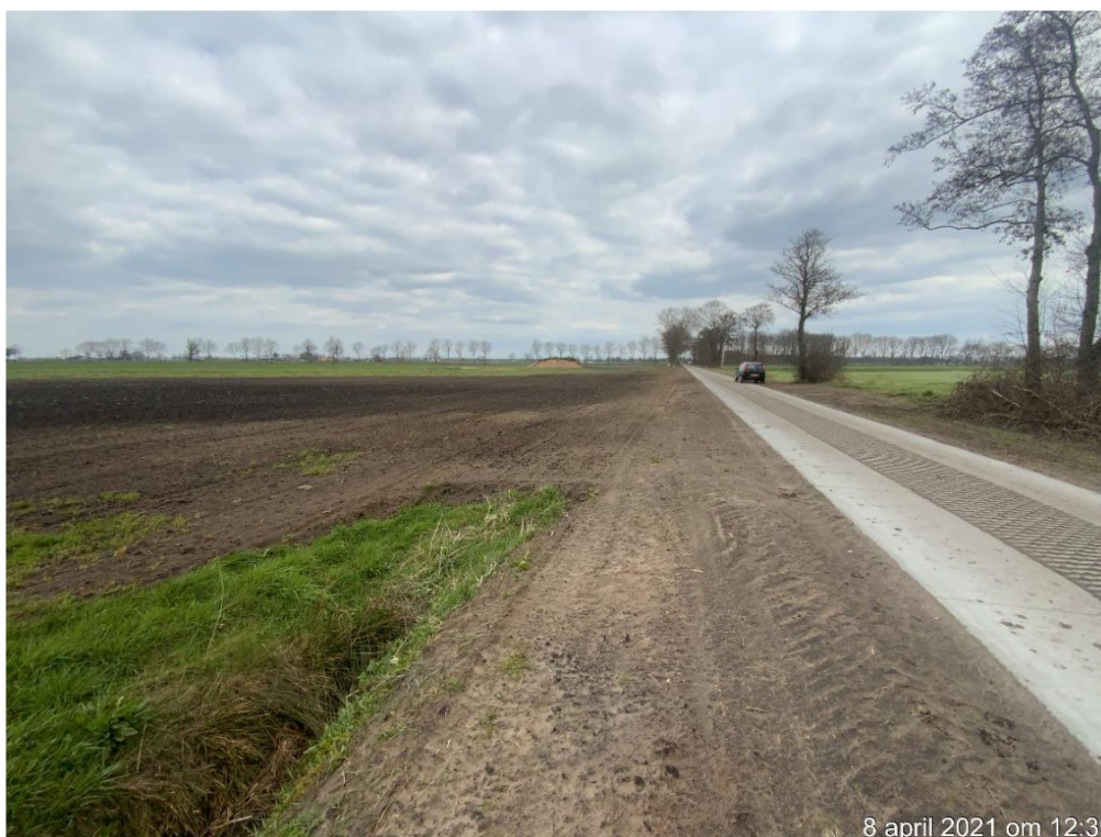
Foto 1: de gedempte bermsloot
