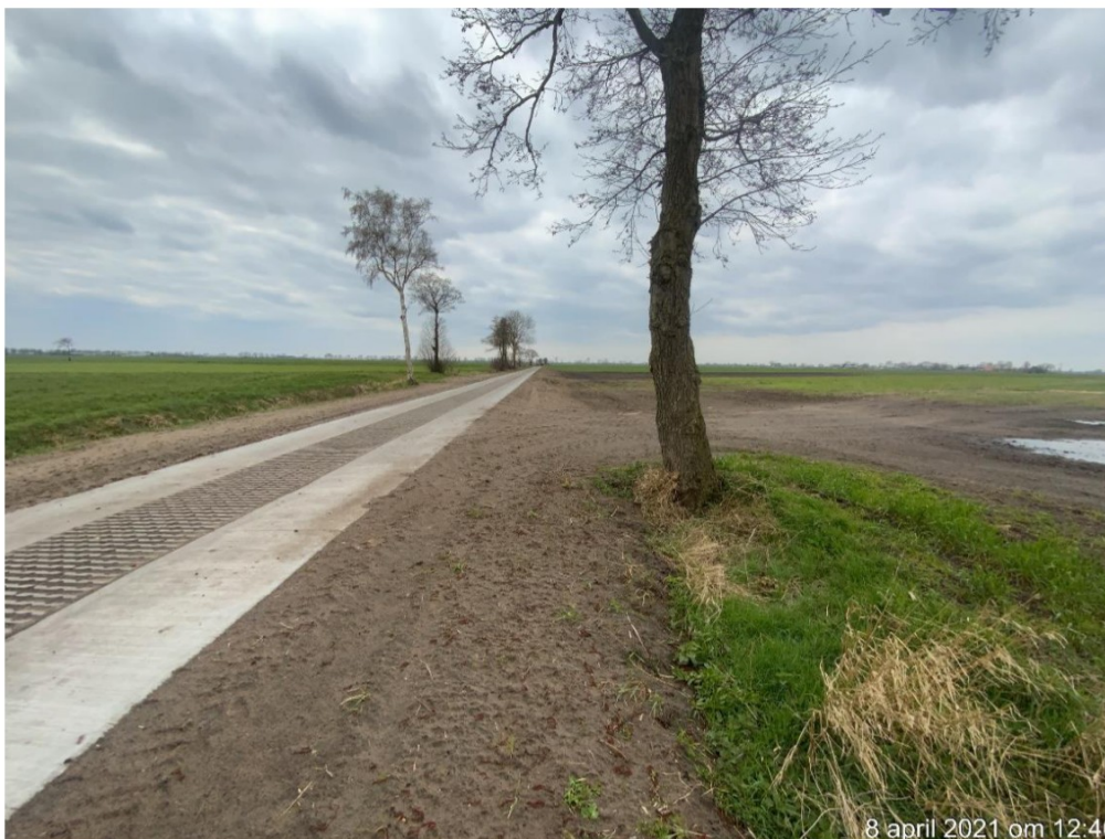
Foto 2: de gedempte bermsloot
