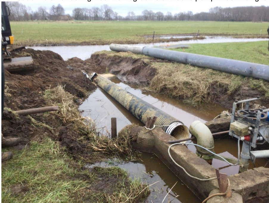
De aangebrachte nieuwe duiker. Op de kant ligt nog klaar de buis die op pomp gaat worden aangesloten.
