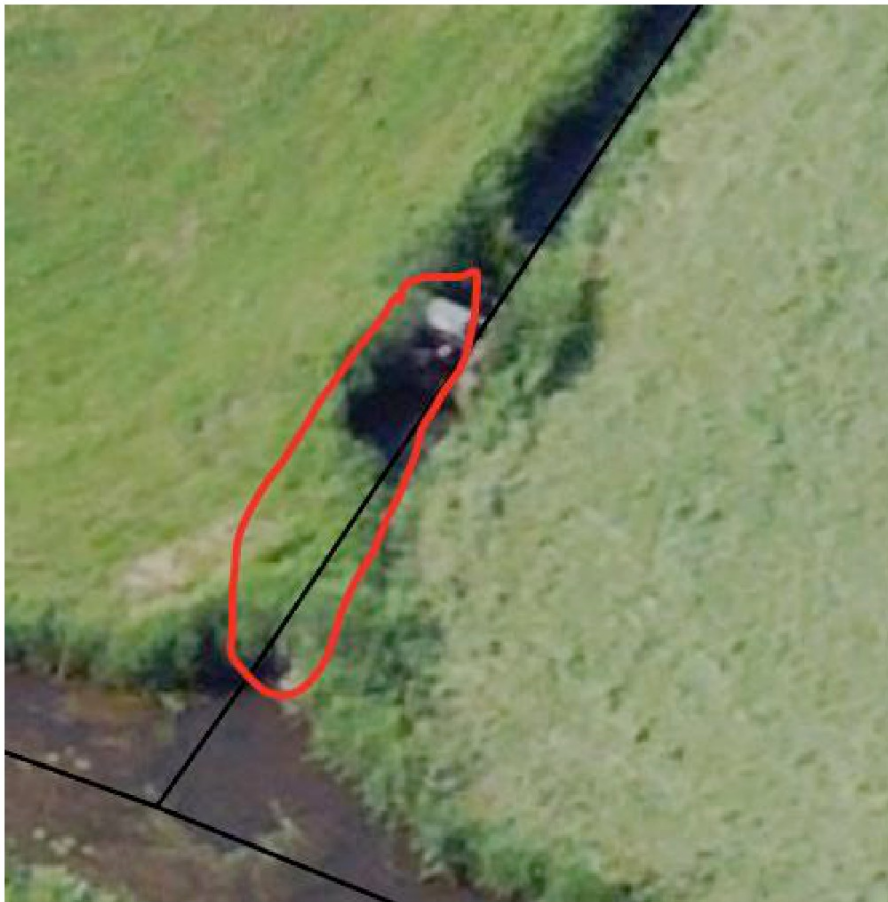
Gebiedje dat was opengegraven en waar de duiker was vervangen. Duidelijk zichtbaar een oude molenfundering waar nu nog een elektrische pomp in aanwezig is.
