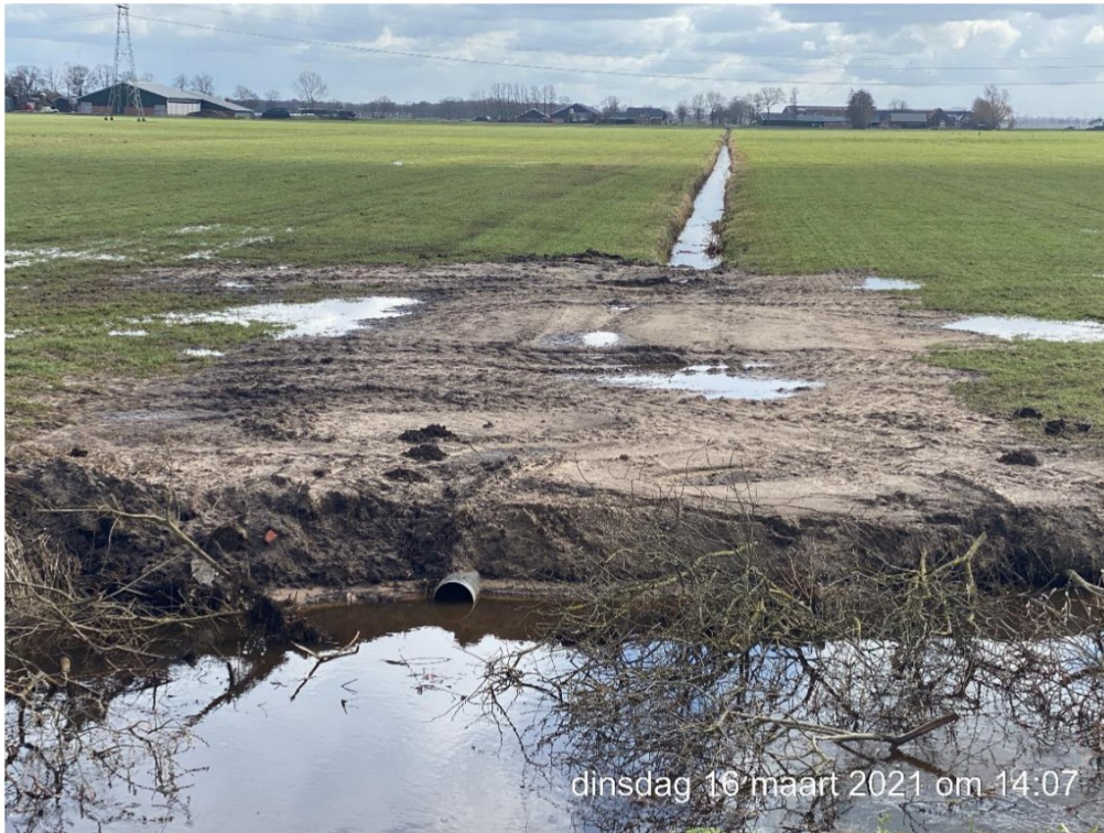
Foto 2: Sloot demping 1 Er is een dam gemaakt van ca. 20 á 25 meter met een duiker Links op de achtergrond het [REDACTED] J
