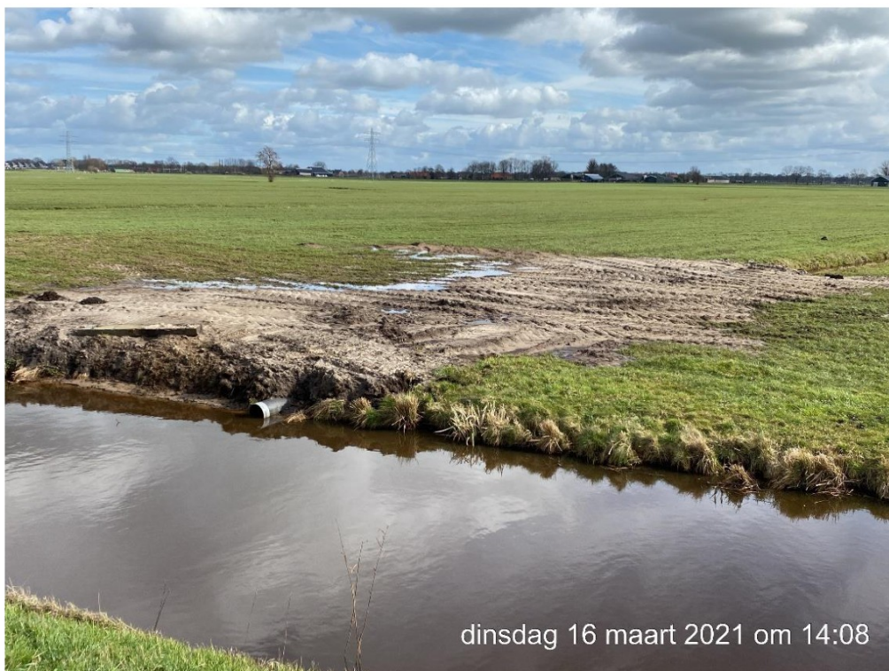
Foto 5: Sloot demping 2 Er is een dam gemaakt van ca. 20 á 25 meter met een duiker Ø315
